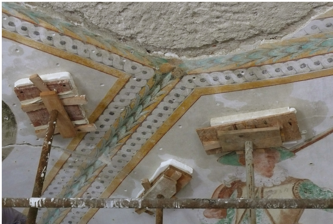
obr.25 - Sokolník, stav po injektáži dutiny lehčenou maltou
