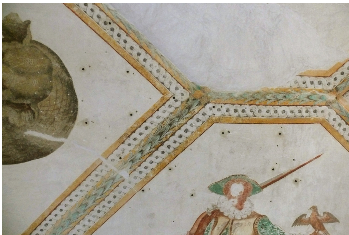
obr.26 - Sokolník stav po vyschnutí, odstranění bionapadení a osazení kotev
