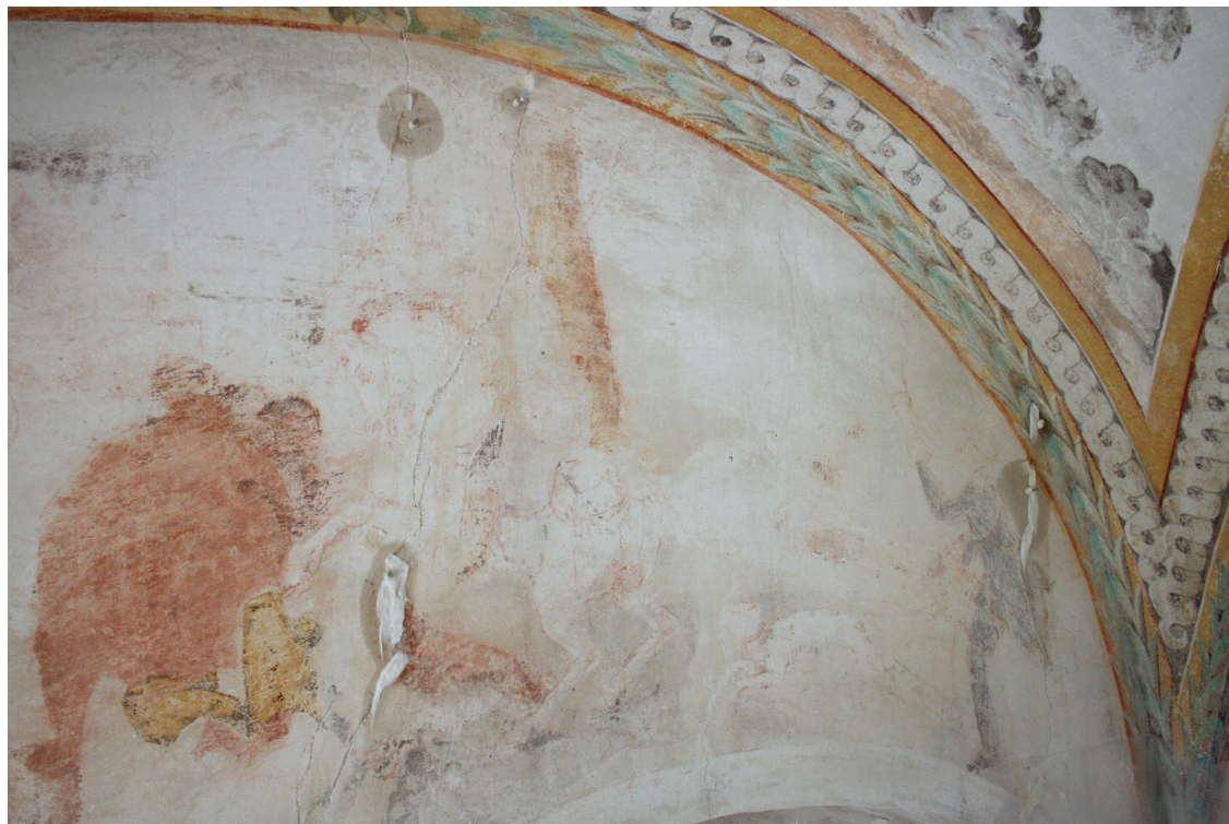
obr.23 - Lov na medvěda, injektáž oddělených omítek
