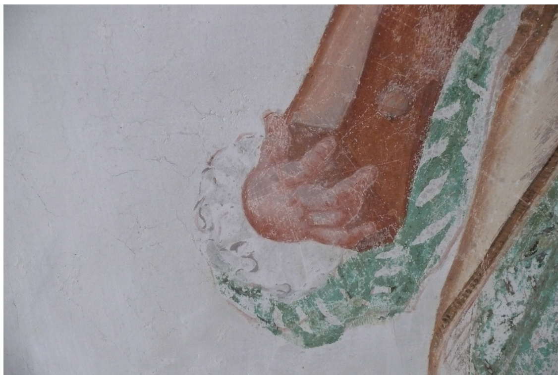
obr.5 - Sokolník, původní rozpraskání omítek
