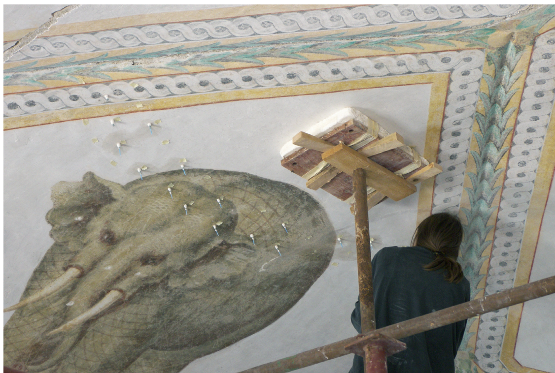
obr.24 - Slon (Sokolník), injektáž okraje dutiny Ledanem
