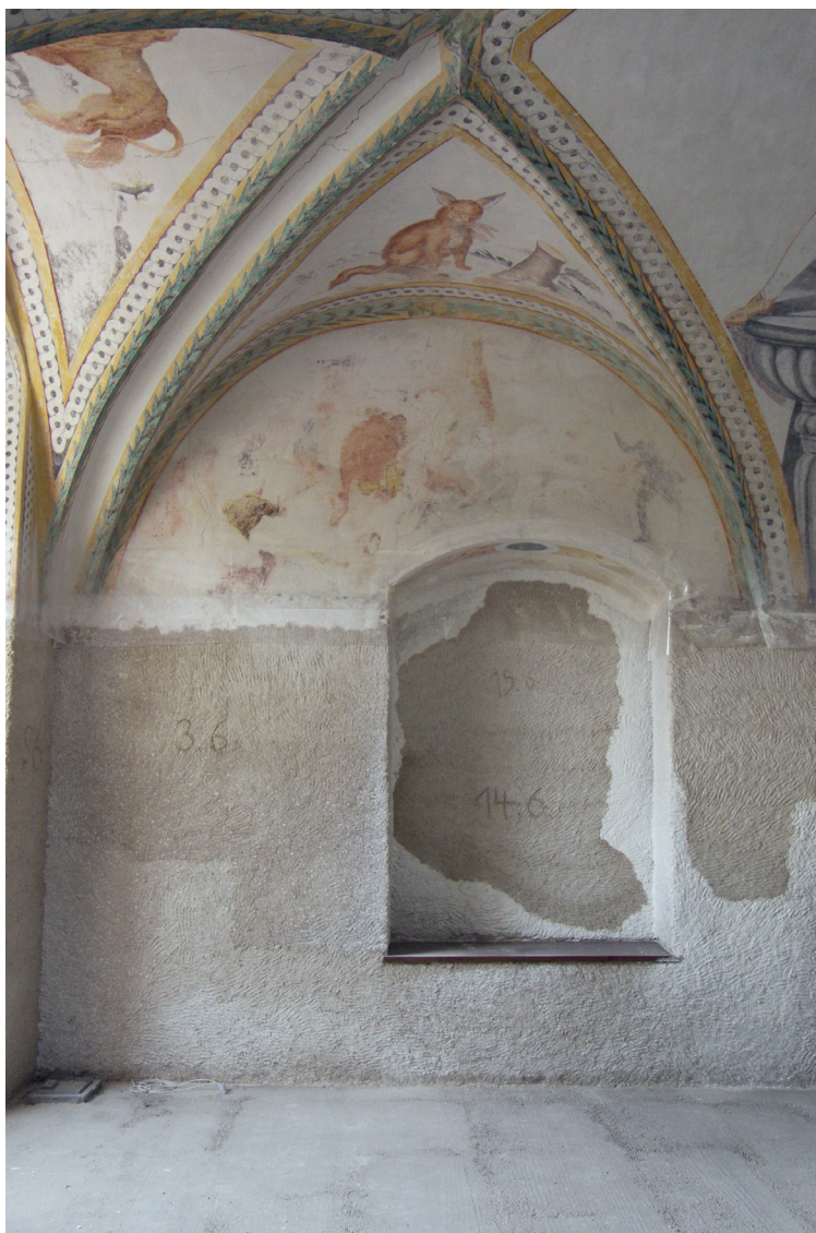
obr.22 - Cyparissus a sokl kolem, odsolovací zábal, na Cyparissovi ohraničená oblast, kde zábal nanesen podruhé (předchozí se separací japonského papíru odpadl)
