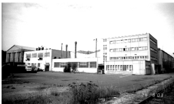
Obrázek 5 - Bývalá elektrárna Poříčí Zdroj: www.duklatrutnov.cz
