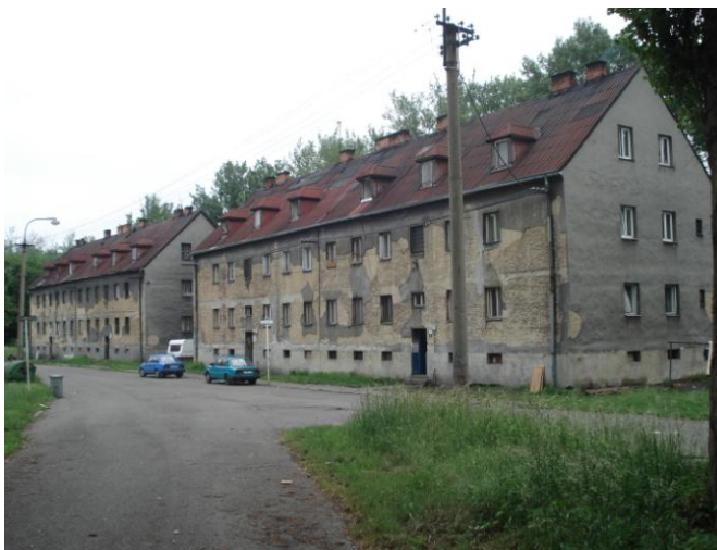
Foto č.1 Domy v lokalitě Hrušov
