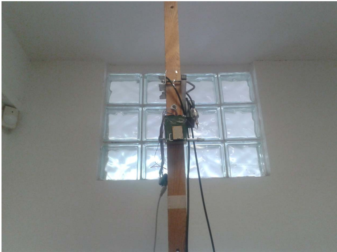
Obrázek 8.3 – Instalace sensorové jednotky detekce osob
