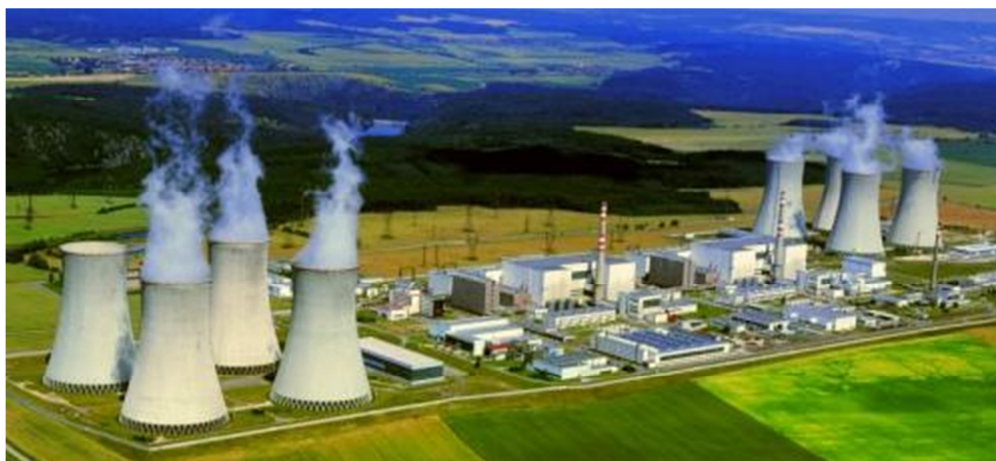
Obrázek 5: Jaderná elektrárna Dukovany
