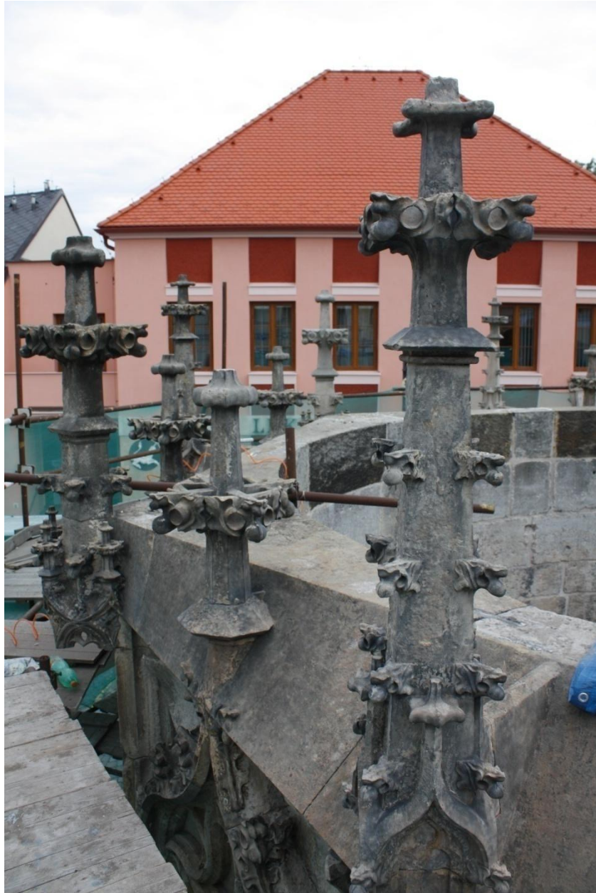
Kamenná kašna Kutná Hora, po odstranění tmelů, spár, povlaků a nátěrů, horní část, foto Jiří Helma
