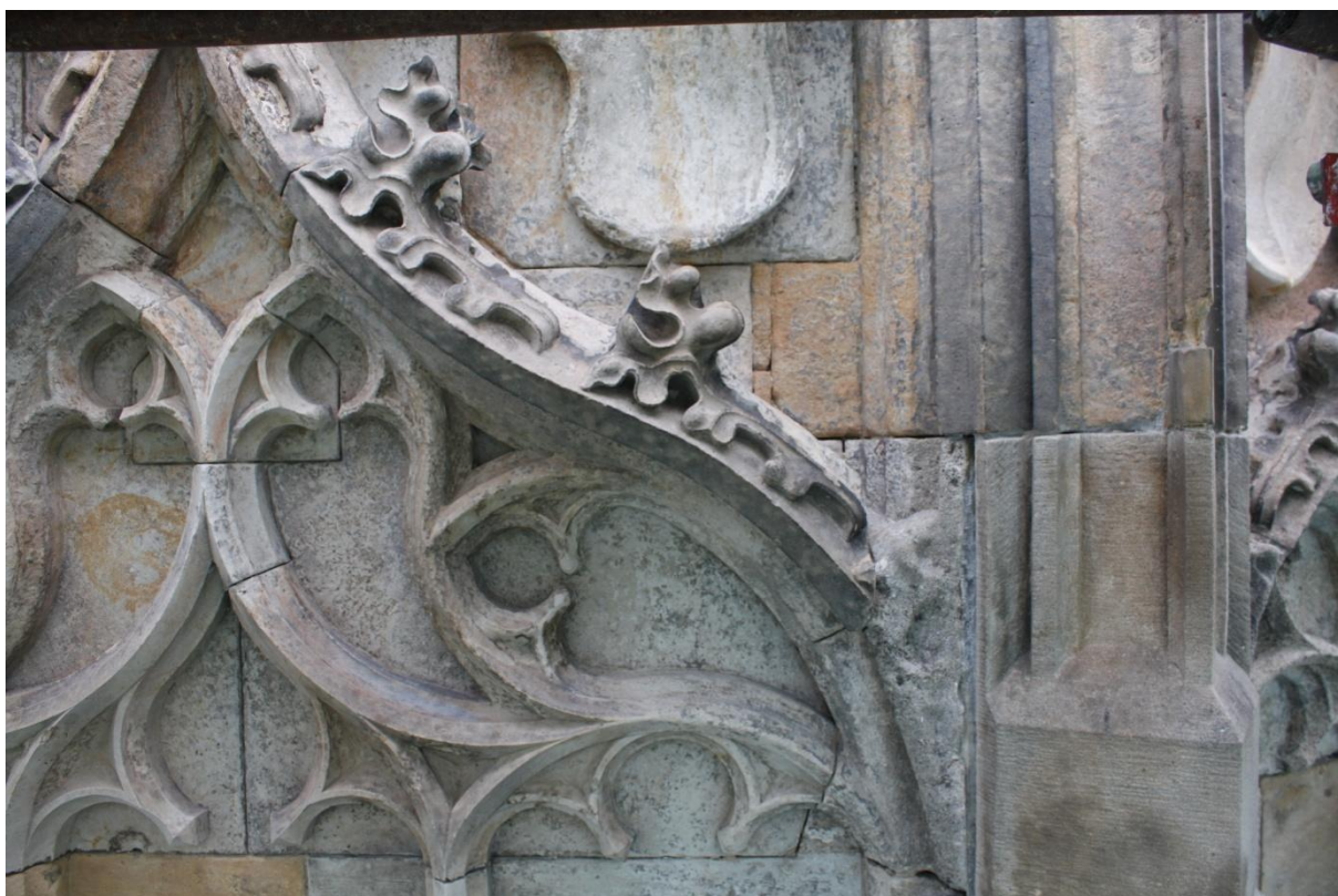
Kamenná kašna Kutná Hora, po odstranění tmelů, spár, povlaků a nátěrů, střední pravá část, foto Jiří Helma
