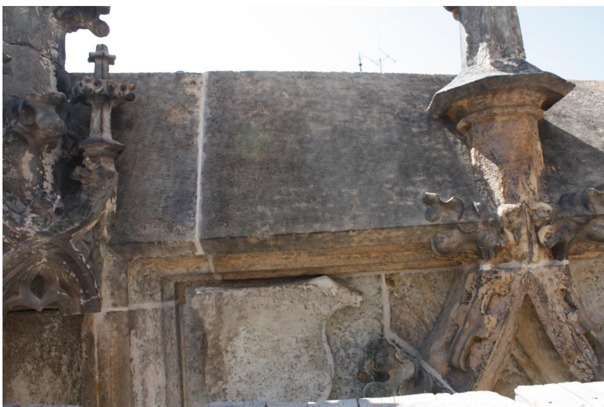
Kamenná kašna Kutná Hora, po vytmelení a vyspárování, horní levá část, foto Jiří Helma
