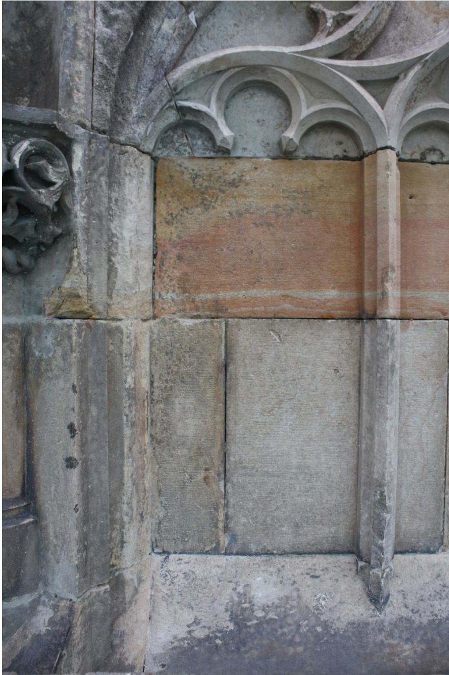
Kamenná kašna Kutná Hora, po odstranění tmelů, spár, povlaků a nátěrů, střední levá část, foto Jiří Helma
