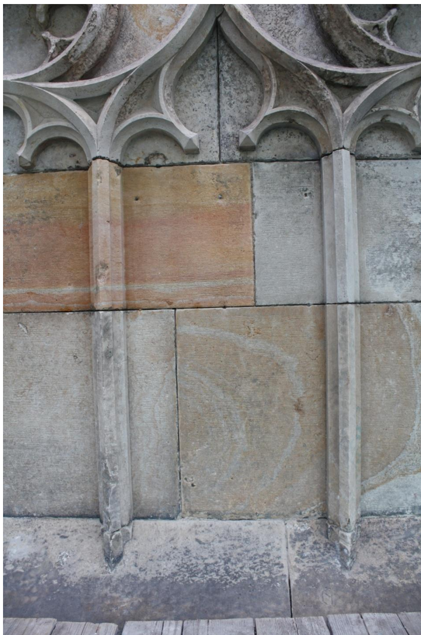
Kamenná kašna Kutná Hora, po odstranění tmelů, spár, povlaků a nátěrů, střední část, foto Jiří Helma
