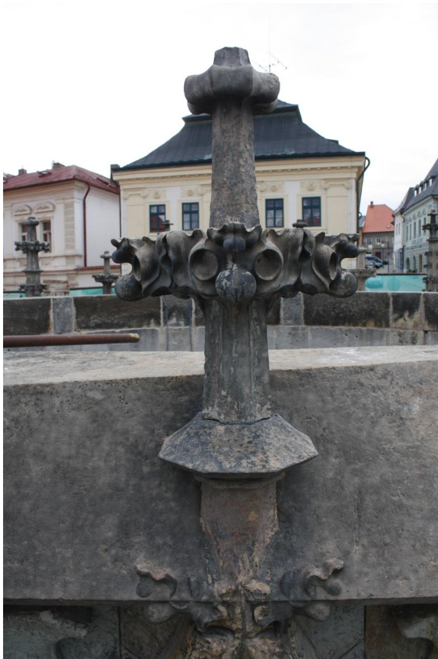
Kamenná kašna Kutná Hora, po odstranění tmelů, spár, povlaků a nátěrů, středová vrcholová kytka, foto Jiří Helma
