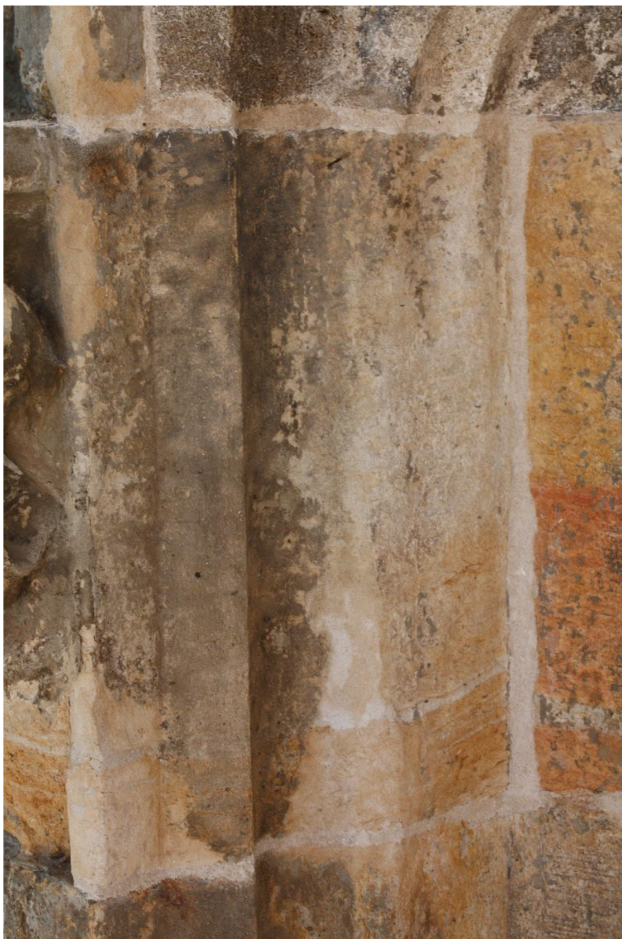
Kamenná kašna Kutná Hora, po vytmelení a vyspárování, detail probarvených tmelů, horní část levého pilíře, foto Jiří Helma
