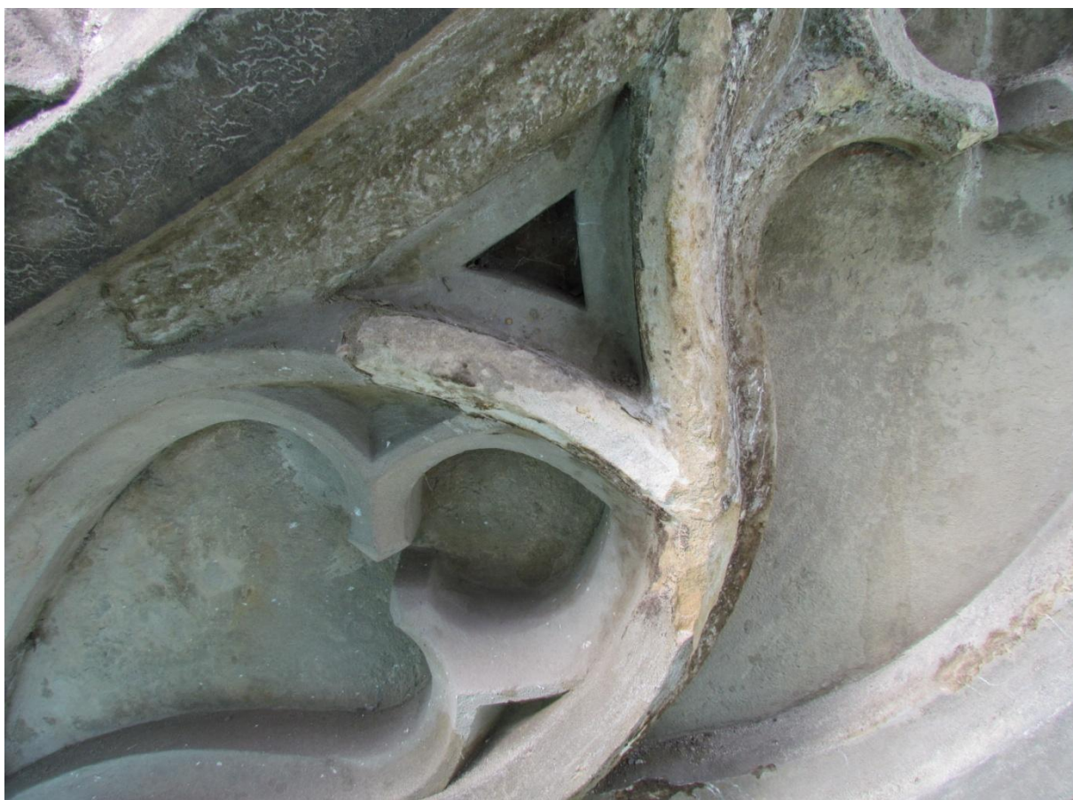
Kamenná kašna Kutná Hora, odstraňování tmelů, levá část kružby pod klenbou, foto Jiří Helma
