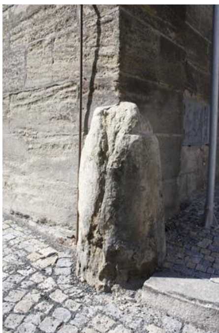
Obr. 40. Internát SPŠ. KH. čp. 67, budova první kutnohorské reálné školy z roku 1857. Vyplavený povrch mušlového vápence do hloubky několika cm vlivem proudící vody z rohové římsy
