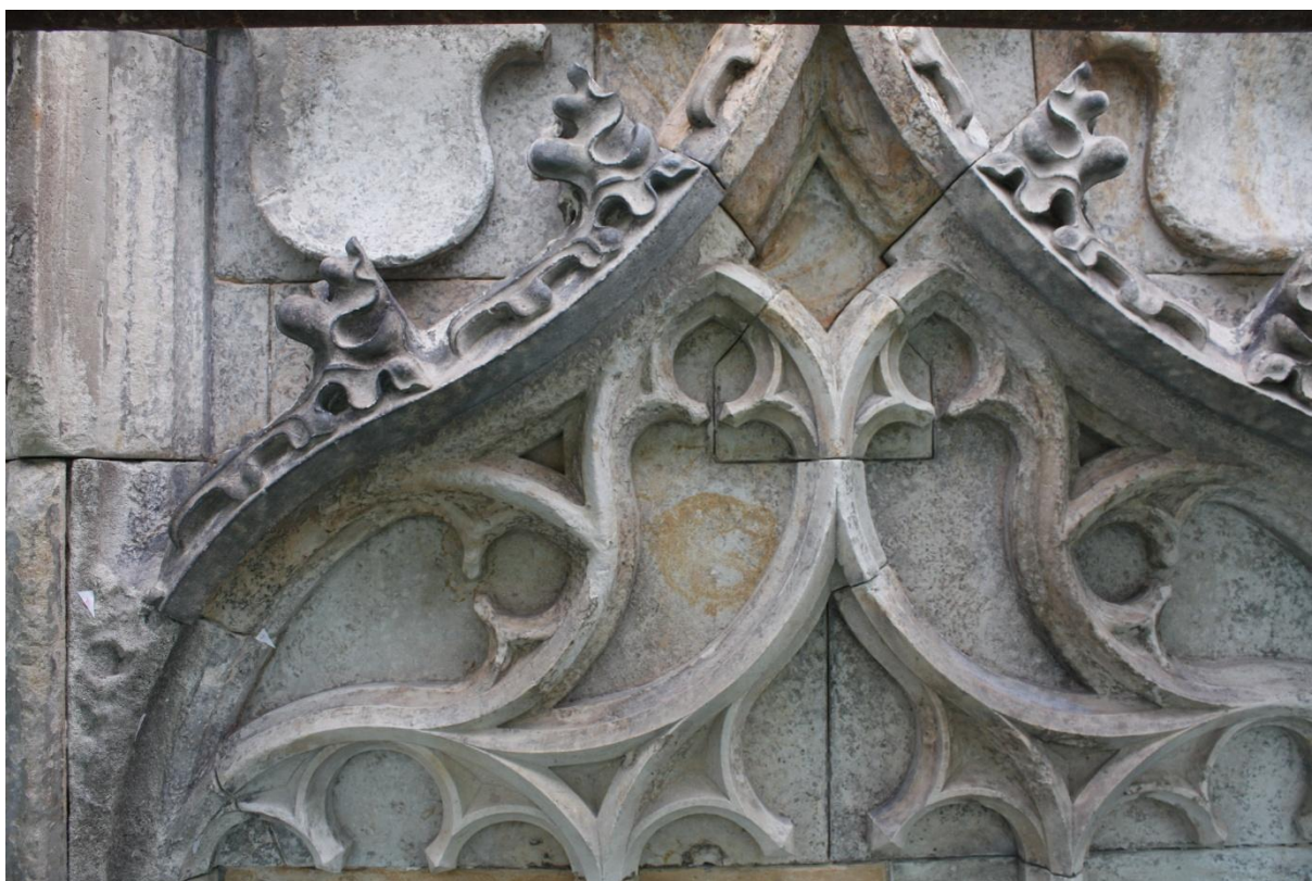
Kamenná kašna Kutná Hora, po odstranění tmelů, spár, povlaků a nátěrů, střední levá část, foto Jiří Helma
