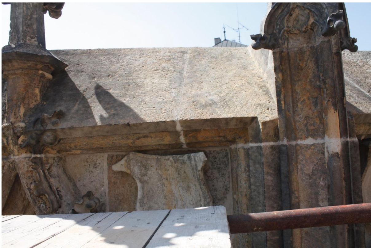
Kamenná kašna Kutná Hora, po vytmelení a vyspárování, horní pravá část, foto Jiří Helma
