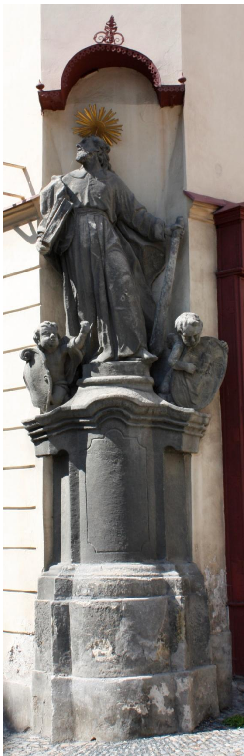
Obr. 43. Socha sv. Judy Tadeáše nárožní nika domu čp. 562. Na soše je patrný dobrý stav povrchu kamene, bez výraznějších ztrát materiálu.
