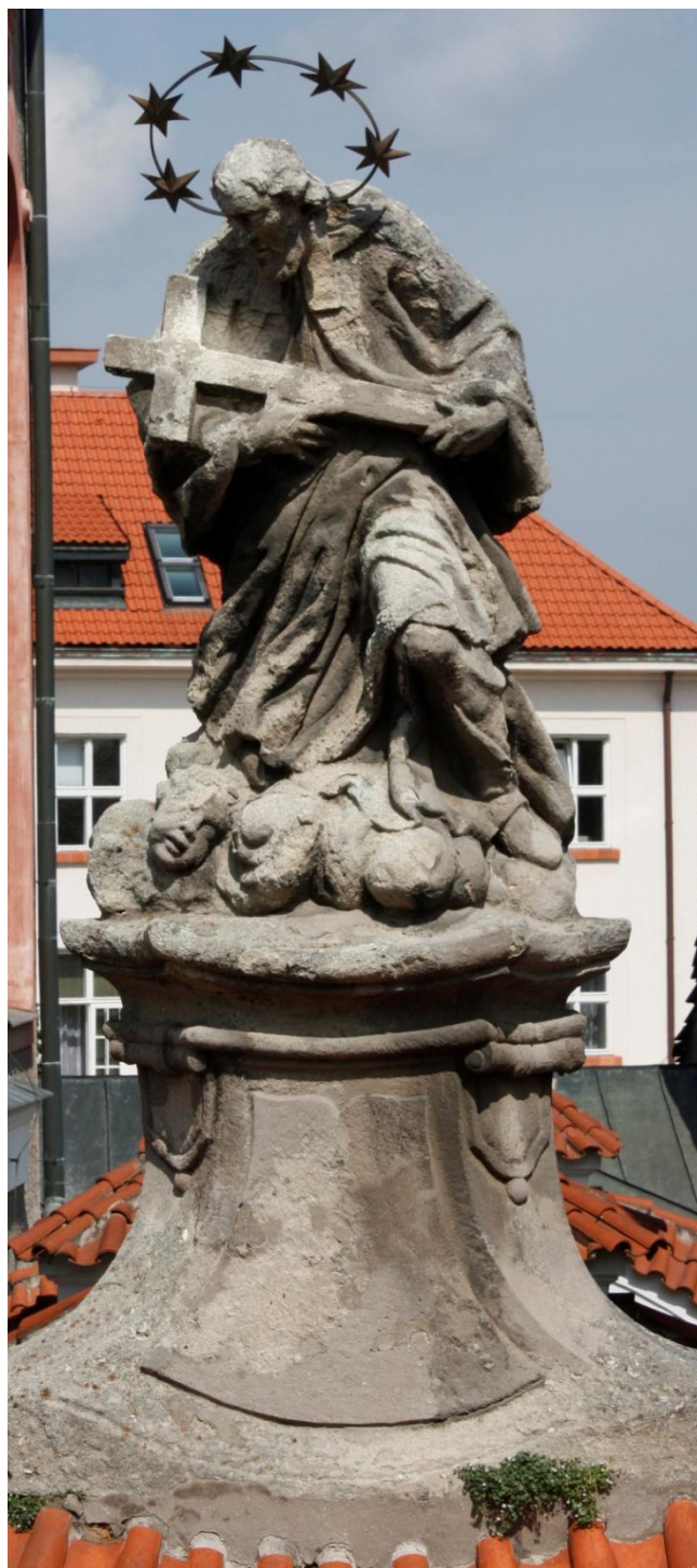
Obr. 44. Socha sv. Jana Nepomuckého z poloviny 18. století, kostel sv. Jana Nepomuckého, Kutná Hora. Povrch kamene je silně vymyt, objevují se místa s degradujícím kamenem pod sádrovcovou krustou, dále velké praskliny a dutiny, do kterých zatíká voda. Na soše jsou patrné opravy z pozdějších dob.
