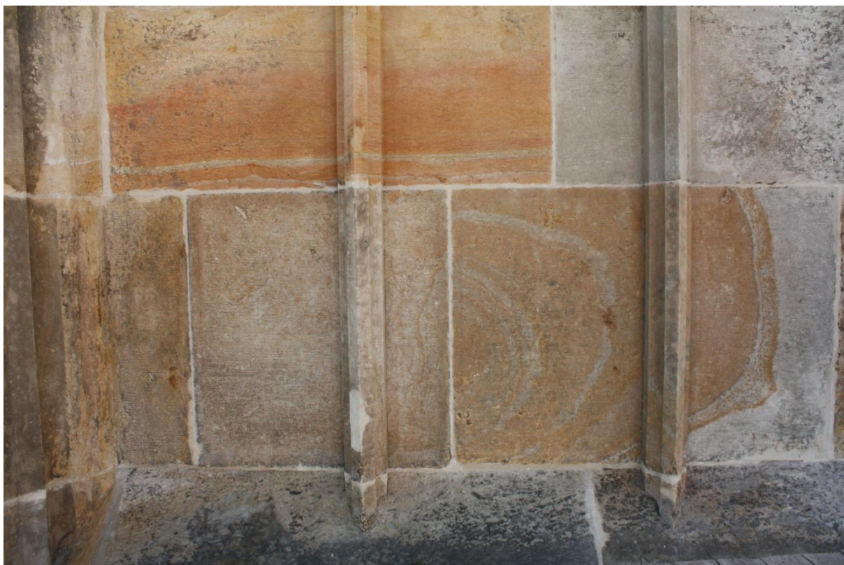
Kamenná kašna Kutná Hora, po vytmelení a vyspárování, střední levá část, foto Jiří Helma
