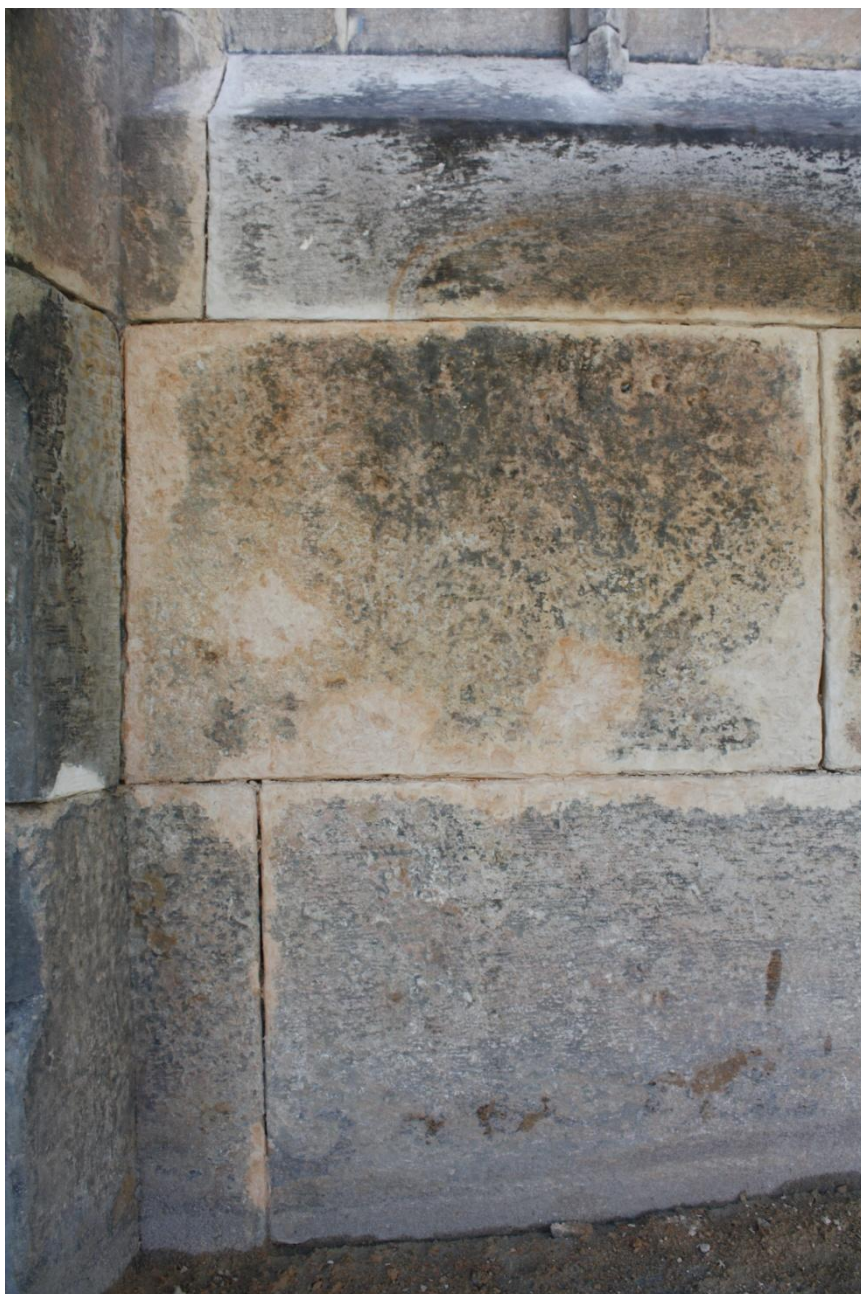
Kamenná kašna Kutná Hora, po vytmelení, spodní levá část, foto Jiří Helma
