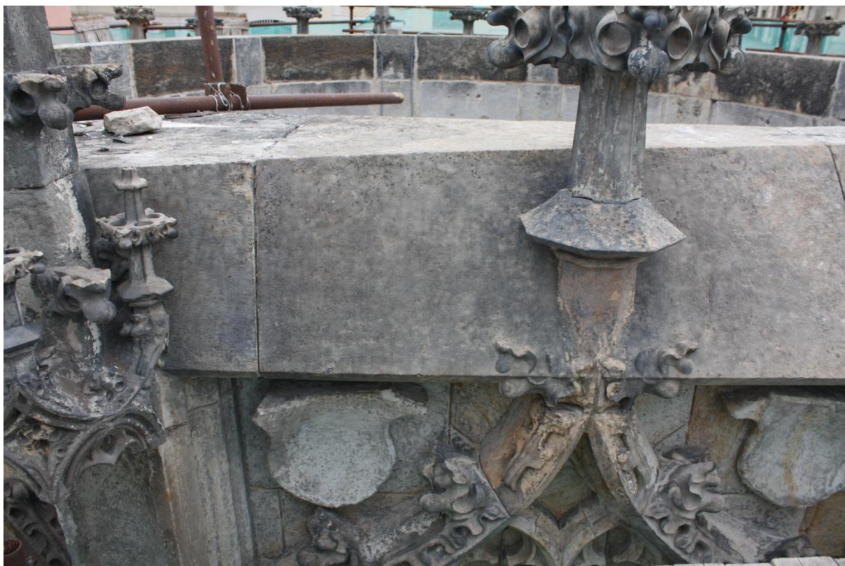
Kamenná kašna Kutná Hora, po odstranění tmelů, povlaků a nátěrů, nahoře vlevo, foto Jiří Helma
