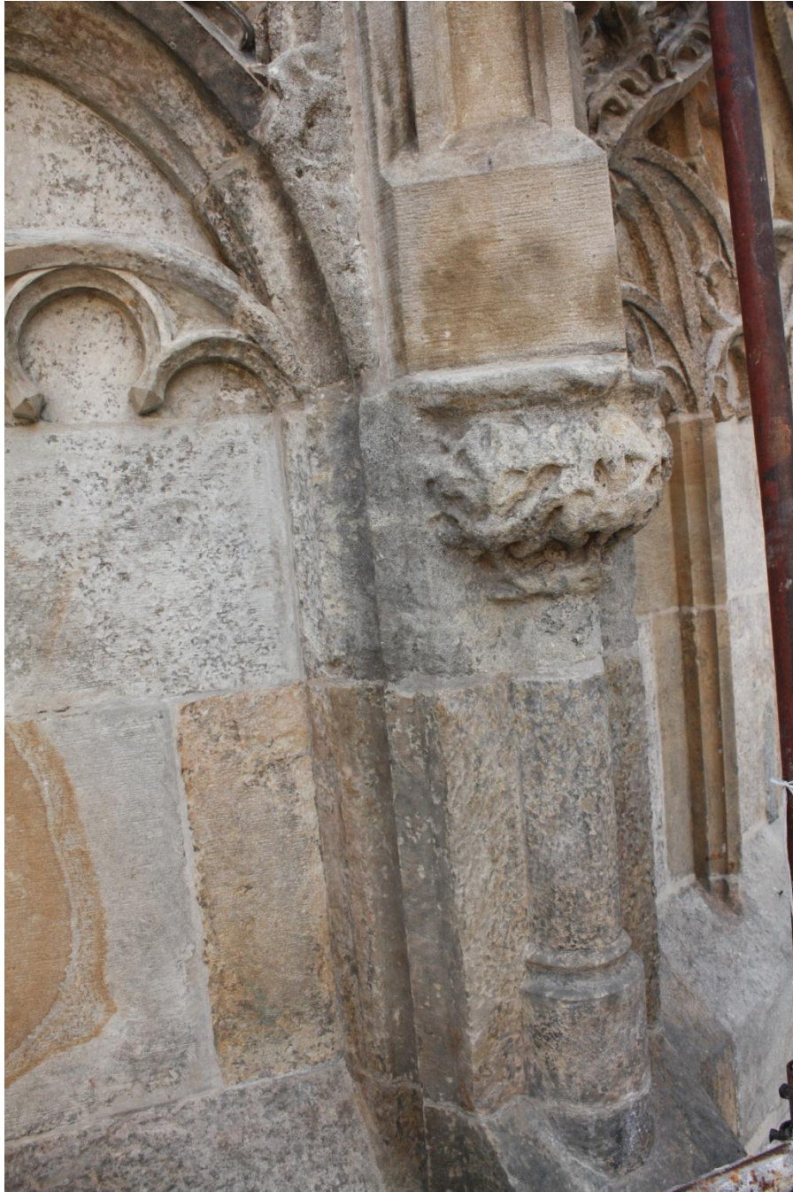
Kamenná kašna Kutná Hora, po retuši, detail hlavice a sloupku na pravém pilíři, foto Jiří Helma
