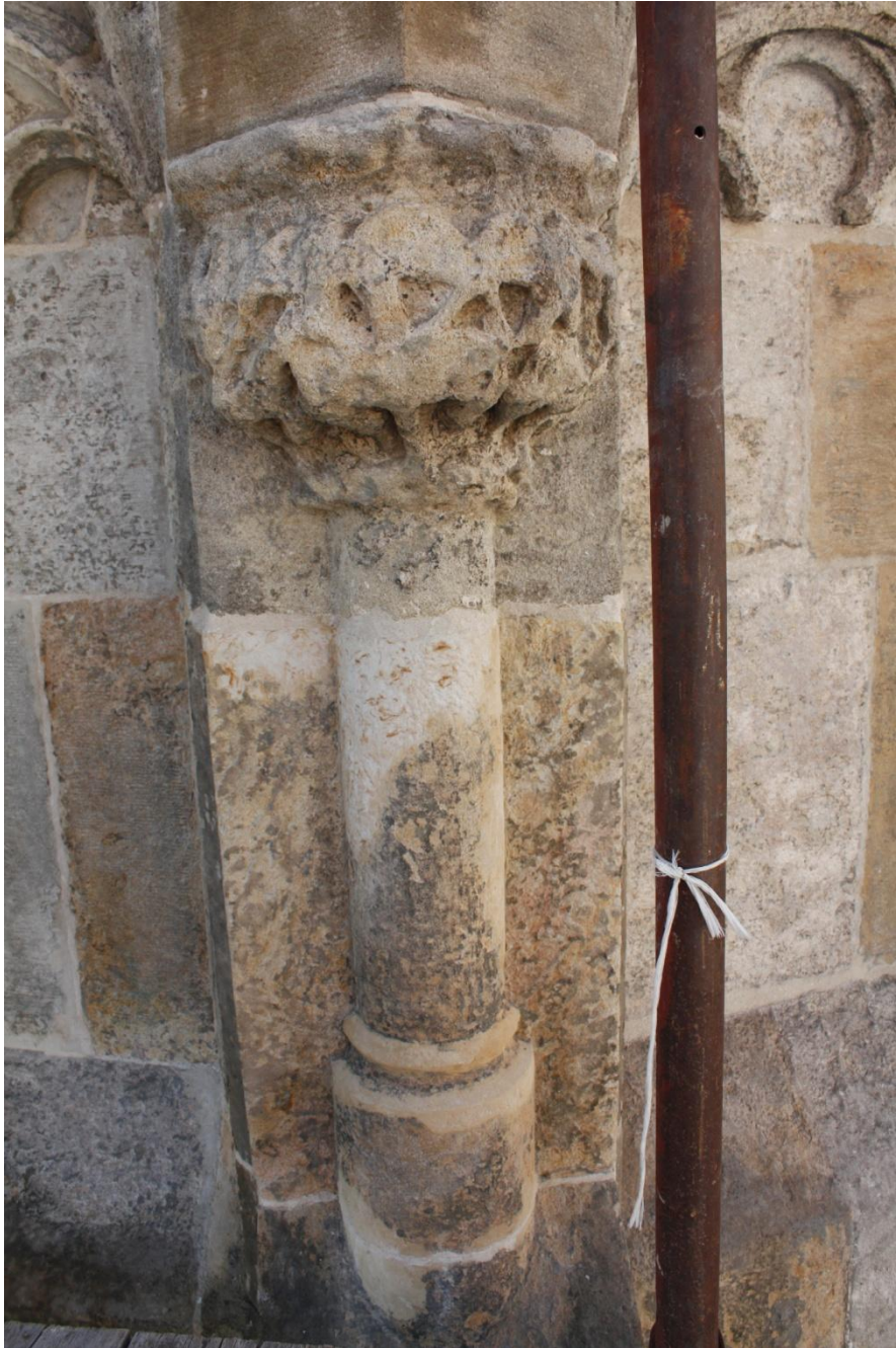
Kamenná kašna Kutná Hora, po vytmelení a vyspárování, střed pilíře, foto Jiří Helma
