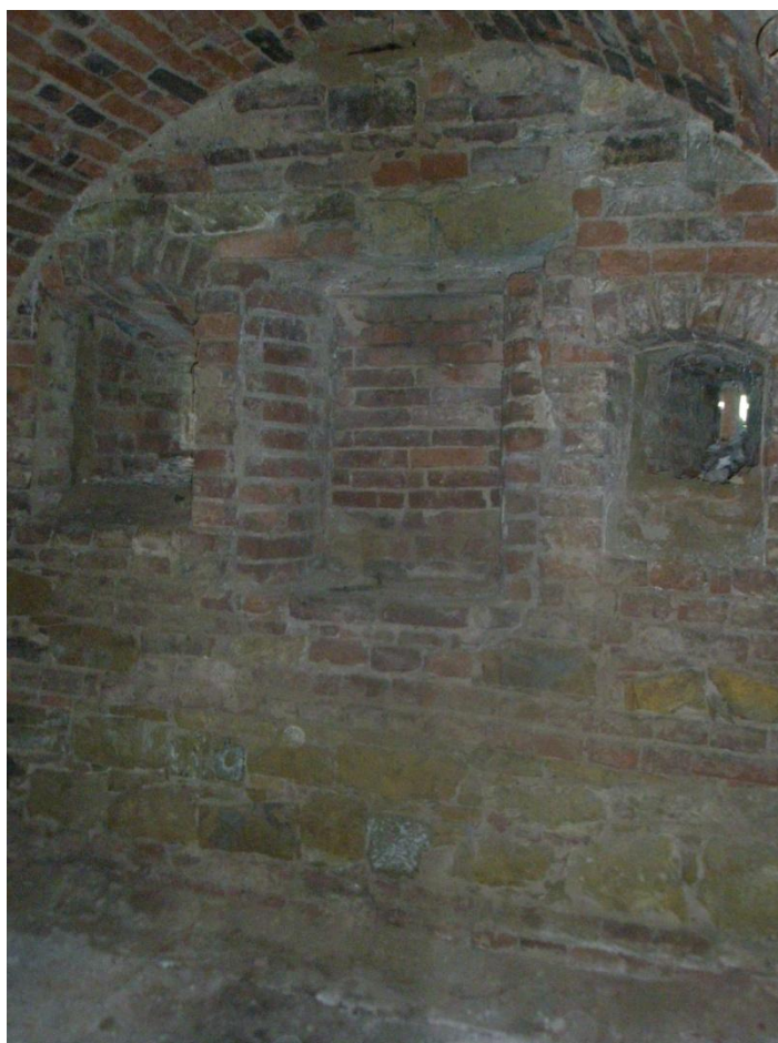
Obrázek č. 59: Fotka palpostů v lunetě, tyto střílny jediné mířily přímo na nepřítele (autor: vlastní foto 21. 5. 2011).
