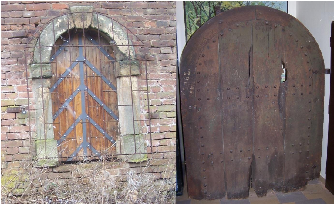
Obrázek č. 93: Vpravo spatříme původní typ dveří, který byl po celé pevnosti a vlevo moderní úprava. Bohužel, z důvodů finanční náročnosti byly tyto dveře osazeny pouze na místech, kde nejvíce hrozí pronikání nepovolaných osob do podzemního systému (autor: vlastní foto 14. 5. 2011).
