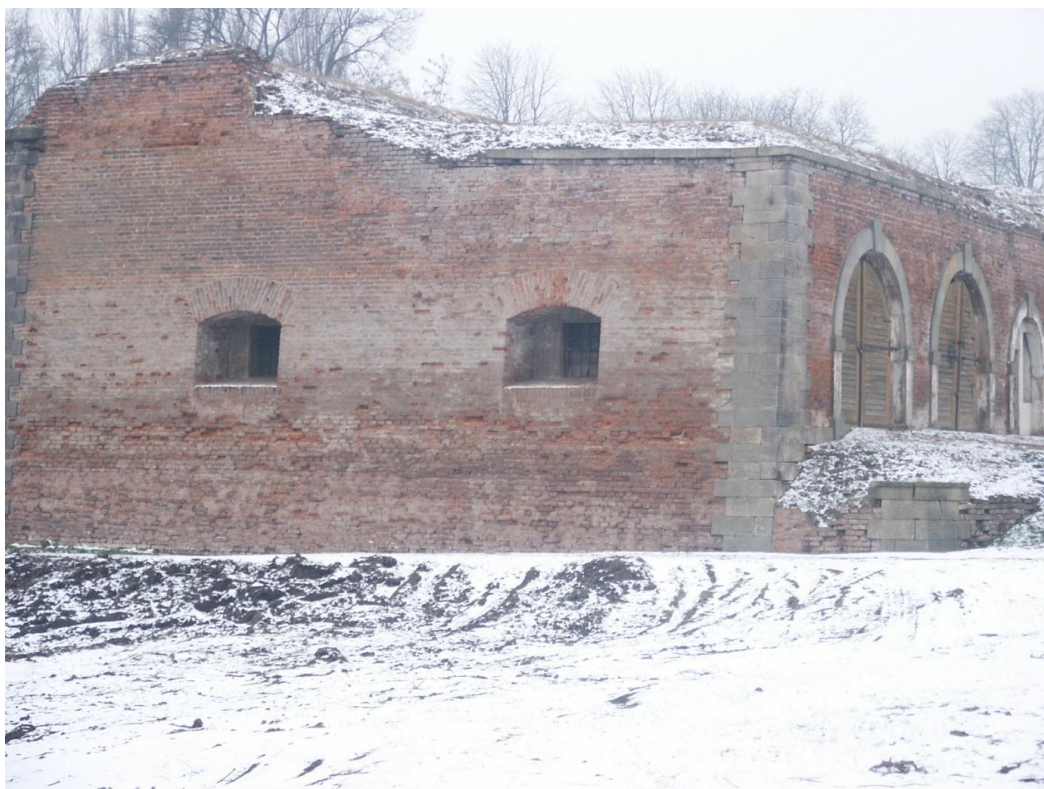
Obrázek č. 81: Dvě dělostřelecké střílny v týlu reduty (autor: archiv firmy STAVEX Č+B s.r.o. 2. 1. 2011).
