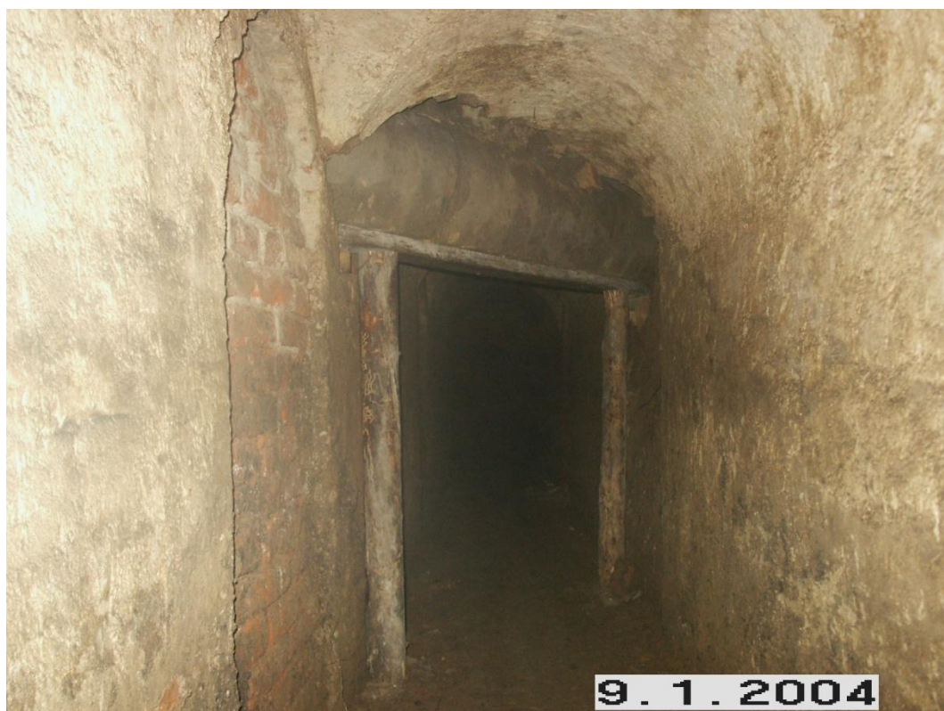
Obrázek č. 96: Na této fotografii jsou zachyceny škody, kterých se dopustila firma SČVAK. Díky tomuto proražení klenby byla narušena celá konstrukce chodby a kaverna způsobená sedající si hlinou ohrožovala výše položenou galerii (autor: archiv firmy STAVEX Č+B s.r.o. 9. 1. 2004).
