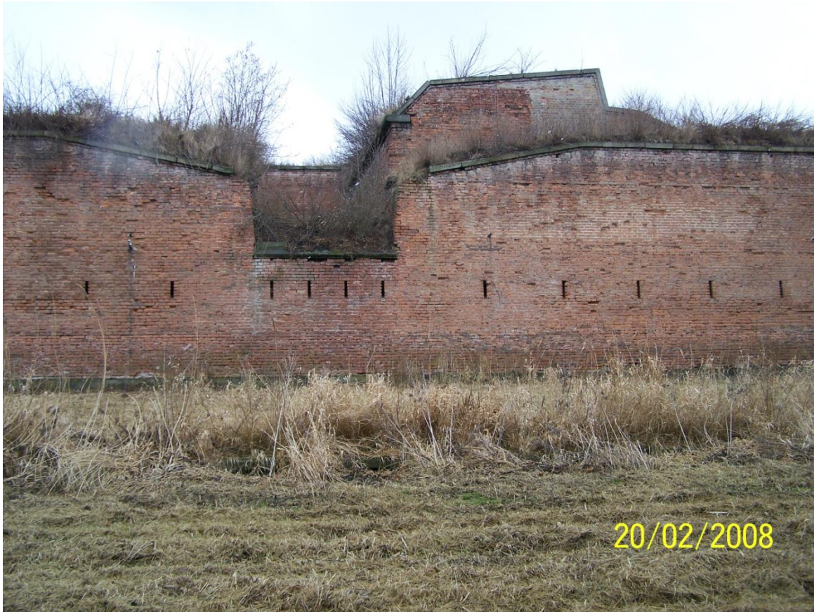
Obrázek č. 47: Na fotografii vidíme zářez do kontragardy č. XXII. Sloužil k odříznutí nepřítele, pokud by se mu podařilo uchytit nebo odpálit špičku kontragardy. V kontraeskarpě jsou dutou batardeaxu, ve které procházela střelecká galerie (autor: archiv firmy STAVEX Č+B s.r.o. 20. 2. 2008)
