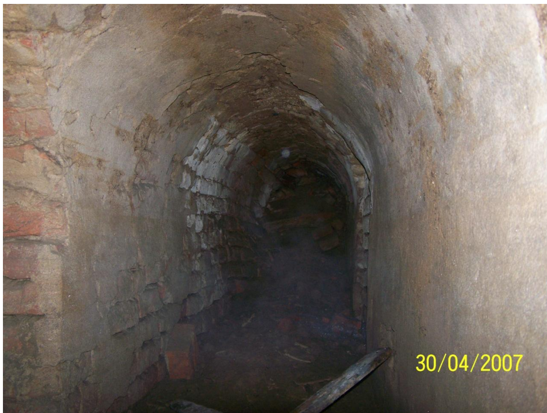
Obrázek č. 102: U takto hroutících se chodeb bylo nejdůležitější zabránit dalšímu šíření destrukce. V místě, kde už se neprojevovala tak silně, se vyzdilo nové čelo a prostor za ním se vyplnil hlínou a sutí (autor: archiv firmy STAVEX Č+B 30. 4. 2007).
