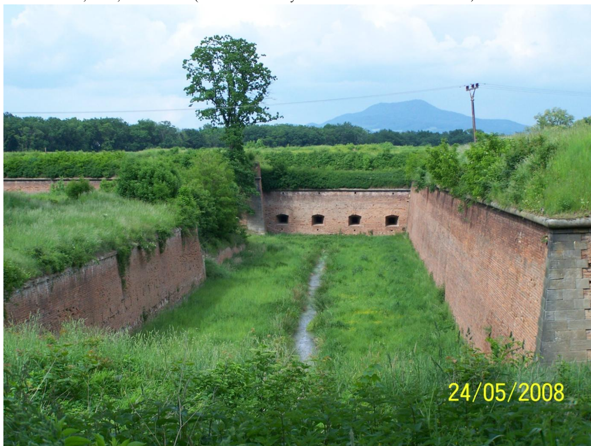
Obrázek č. 82: Dělostřelecká kasemata v křídle kontragardy měly bránit mosty a nejohroženější křídla ravelinů č. XVI, XVII, XVIII a XIX (autor: archiv firmy STAVEX Č+B s.r.o. 24. 5. 2008)
