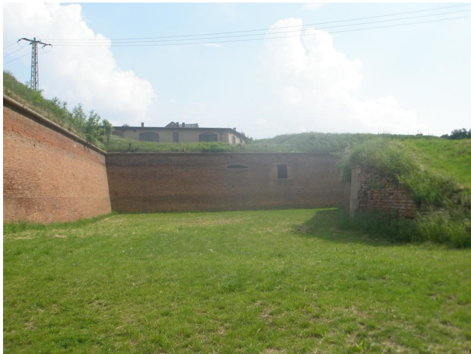
Obrázek č. 79: Zbytky dělostřelecké kasematy v křídle bastionu č. IV, které měly chránit prostor za kleštěmi č. XII a poternu v kurtině (autor: vlastní foto 21. 5. 2011)
