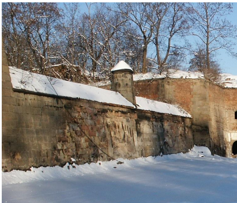
Obrázek č. 50: Fotografie batardeau od napouštěcích stavidel. Oddělovaly jednotlivé úseky hlavního příkopu, které se daly napouštět každý zvlášť (autor: vlastní foto 14. 2. 2004)
