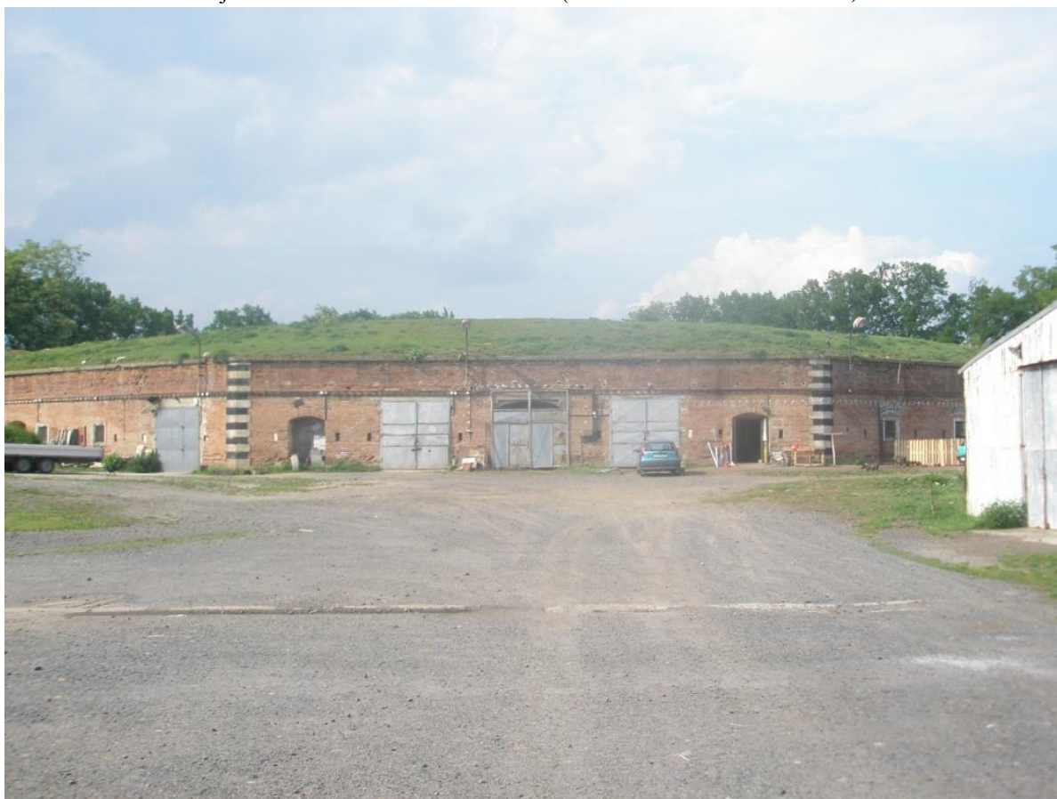
Obrázek č. 43: Zde je vidět tyl špičky ravelinu č. XX z retranchementem. Zde původně byly dělostřelecké laboratoře. Bohužel ani jeden retranchement se nedochoval (autor: vlastní foto 21. 5. 2011).
