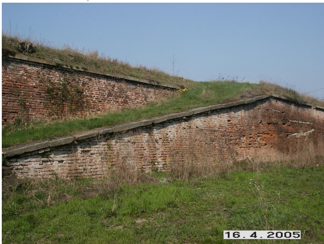
Obrázek č. 30: Na fotografii je vidět skvěle zachovalá rampa na ravelin č. XIX (autor: archiv firmy STAVEX Č+B s.r.o. 16. 4. 2005).
