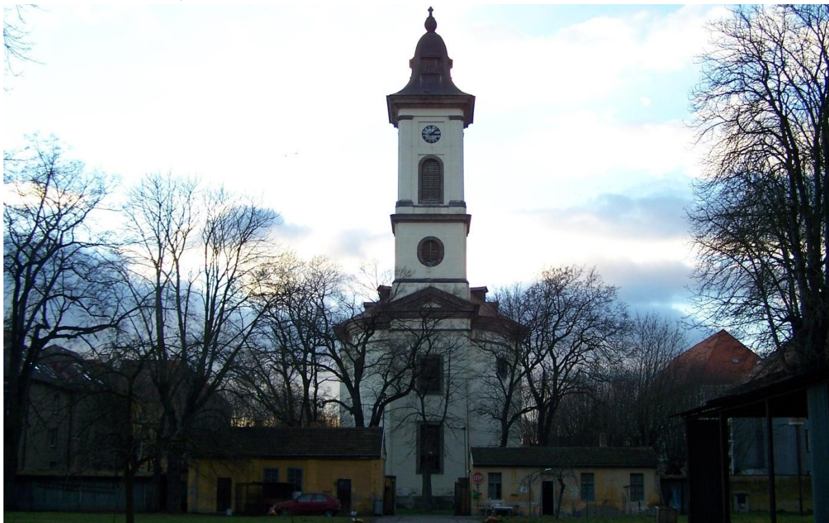
Obrázek č. 12: Fotografie posádkového kostela směrem od nemocnice. Tato věž má ve své spodní části minové komory pro odpálení. Nepřítel by se podle postavení kostela mohl zaměřit na další budovy. (autor: vlastní foto 21. 05. 2011)
