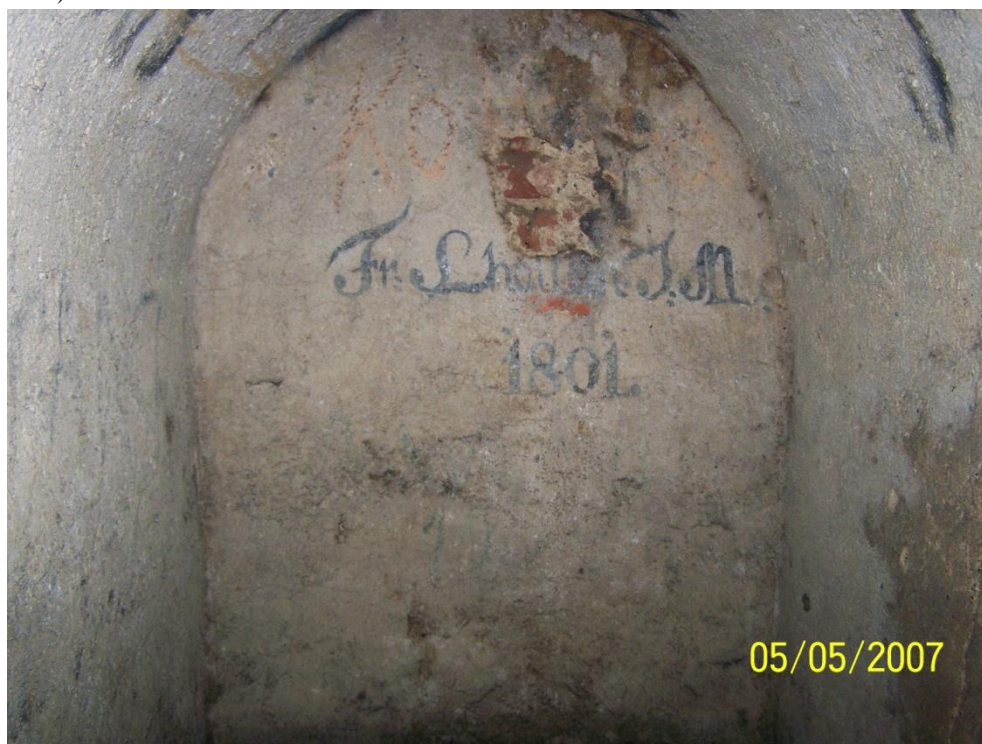
Obrázek č. 100: Fotografie zachycuje čelo envelopy na Malé pevnosti. Takto zachovalá původní barokní omítka i s označujícím nápisem je velká vzácnost. Většina omítek a nápisů se zachovala díky tomu, že byly konzervovány naplaveninami a zásypem, který se časem v chodbách nasrádal (autor: archiv firmy STAVEX Č+B 5. 5. 2007).
