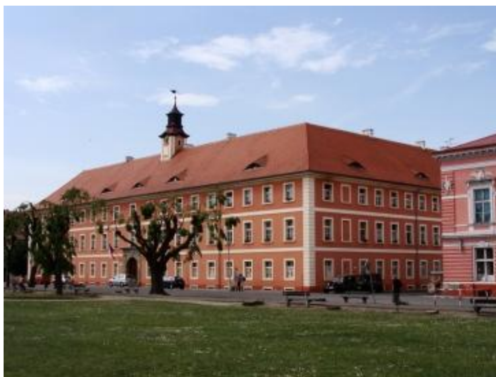
Obrázek č. 13: Dům inženýrů zde stál jako první budova vůbec a možná, že ještě dříve než hradební systém. Dnes je zde kulturní dům (autor: vlastní foto 21. 5. 2011)
