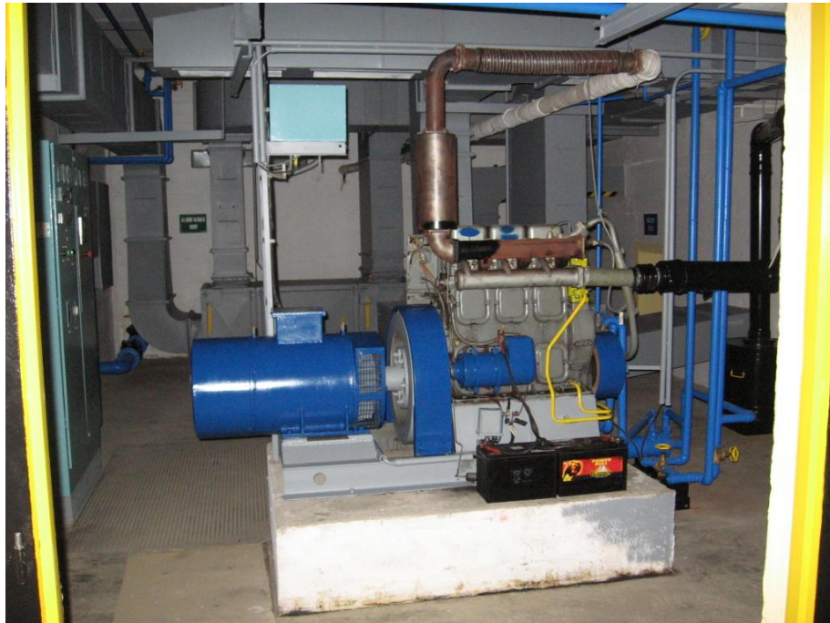
Obrázek 7 - Diesel agregát
