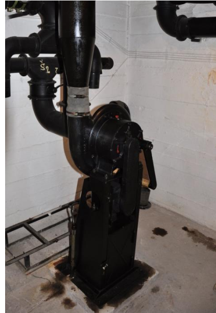
Obrázek 15 – Filtroventilační zařízení
