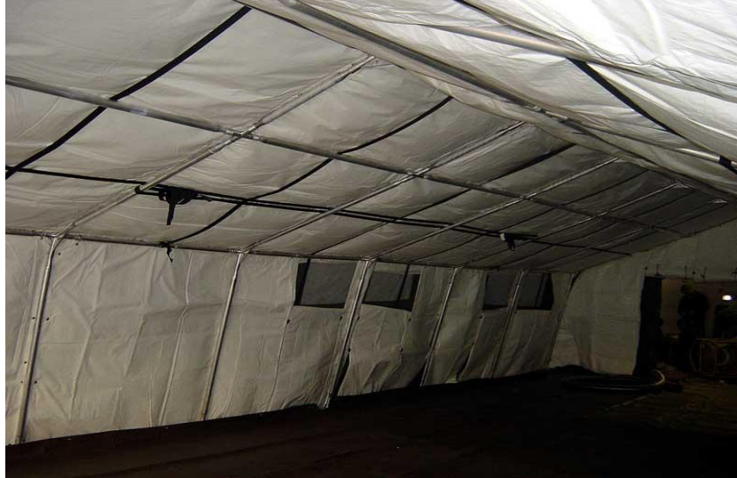
Obrázek 9 – Kovová konstrukce stanu
