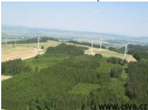
Obrázek 9: Větrné elektrárny mezi obcemi Anenská Studánka a Helvíkov
