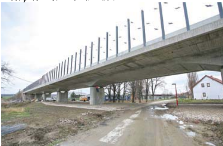
Most přes místní komunikaci.
