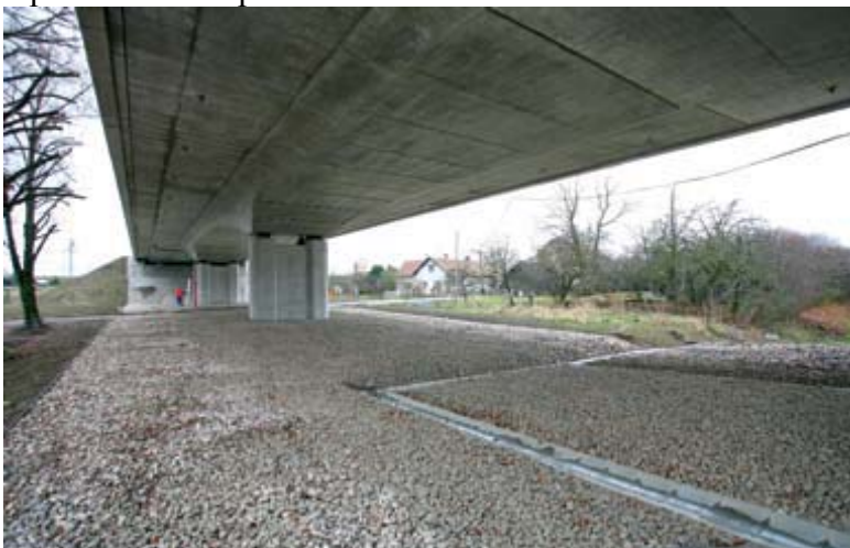
Úprava terénu a pilíře mostu.
