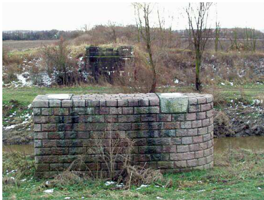
Obr. 1: Snesený most přes Dyji
