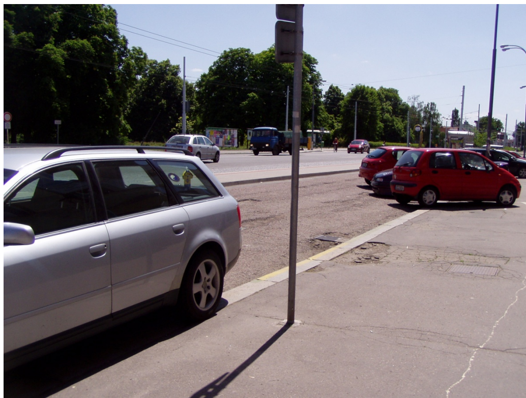
Obrázek 5 – Výtluk, způsobený mozaikovými trhlinami
