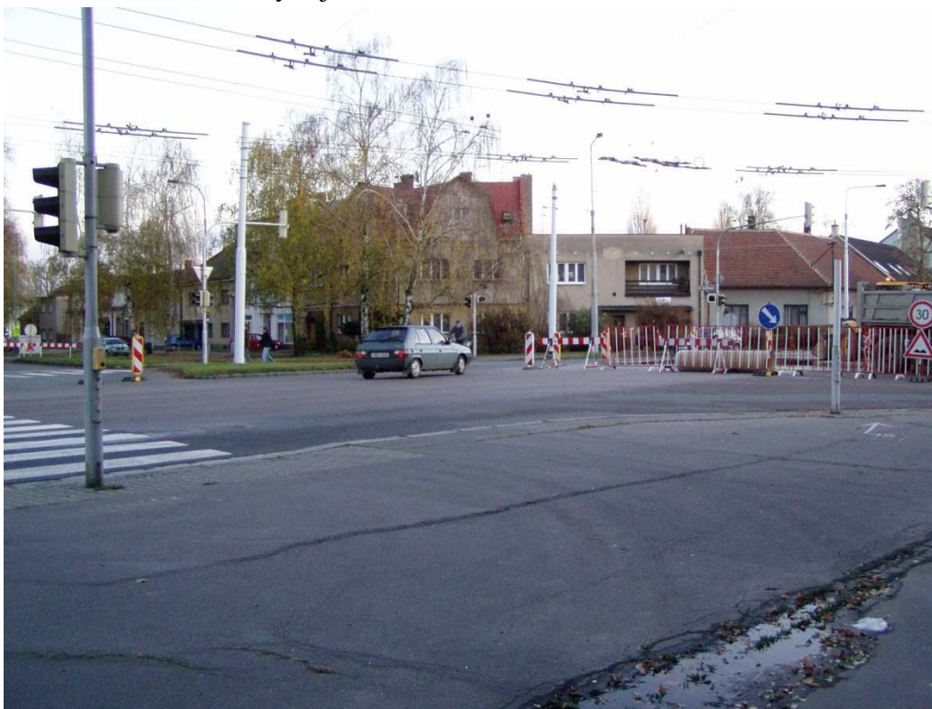
15. Rekonstrukce křižovatky, říjen 2008
