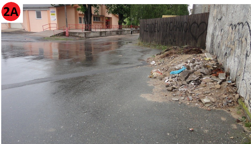
Obrázek č. 22: Překážka u stěny domu
