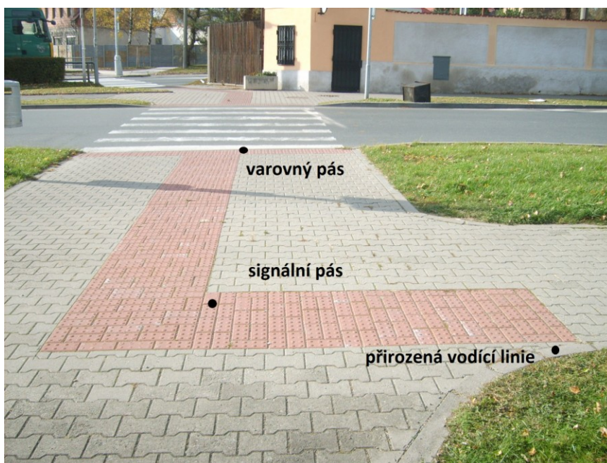
Obrázek č. 3: Správné řešení přechodu pro chodce ve Vysokém Mýtě
