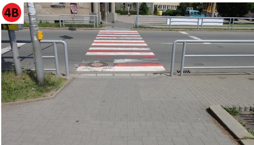
Obrázek č. 29: Přechod pro chodce u bazénu
