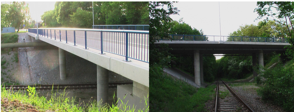
Obr. 11 Mostní konstrukce v ul. Průmyslová
