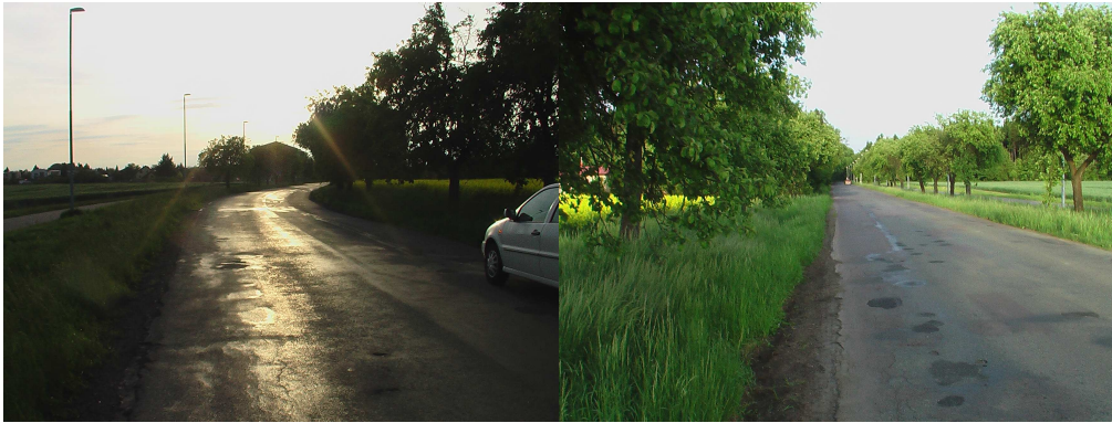
Obr. 5 Komunikace III/34028 v místě průsečné křižovatky
