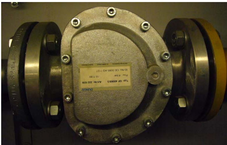
Obrázek 13 - Filtr bioplynu
