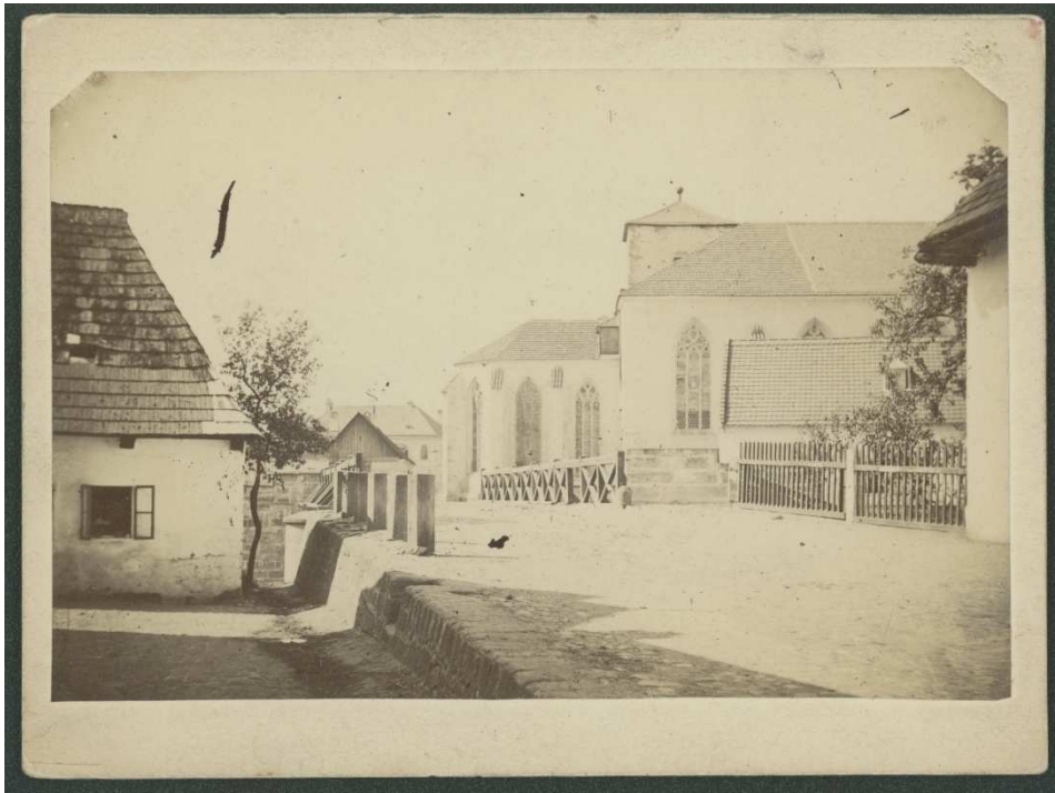
Obr. 7. Kostel sv. Kateřiny, při pohledu z Havlíčkovy ulice
