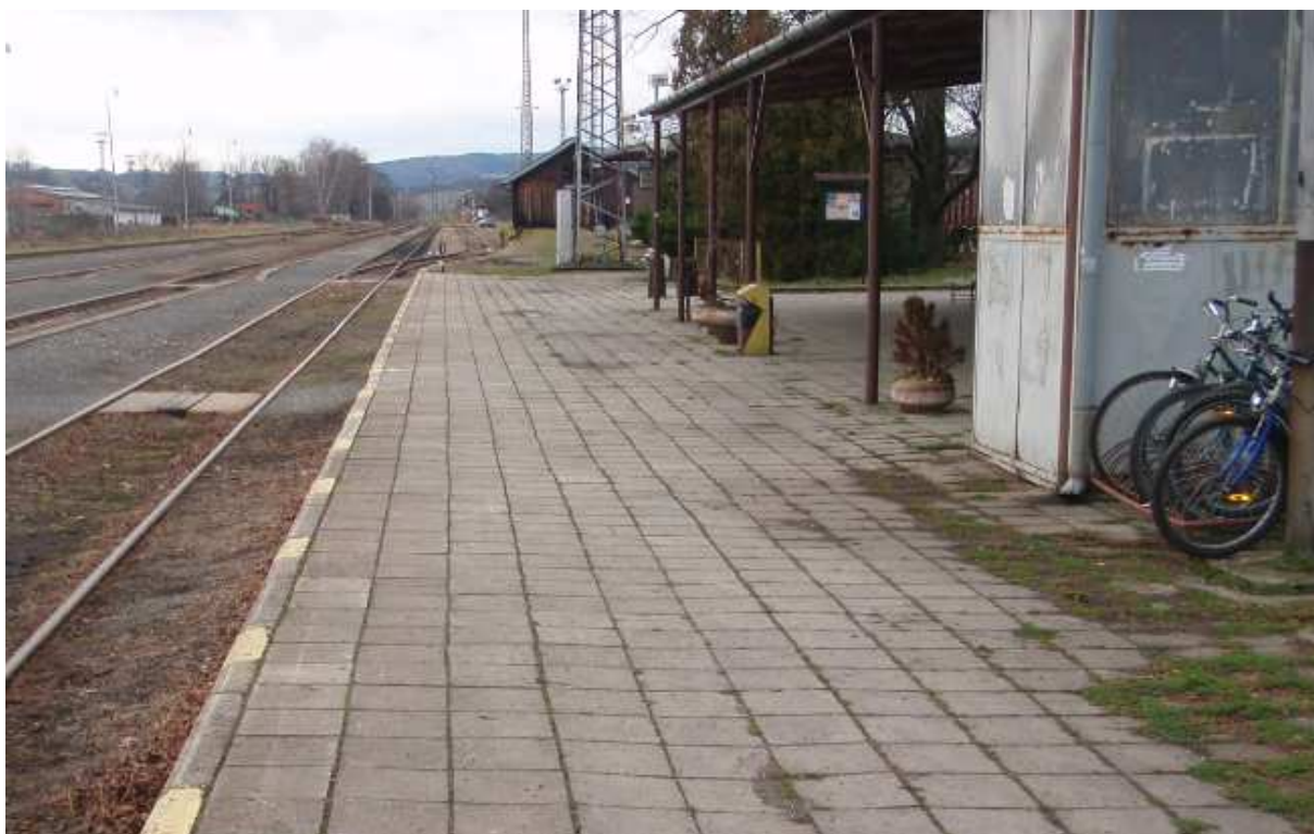
Obr. 14 Zpevněná plocha před výpravní budovou s dlážděným prvním nástupištěm
