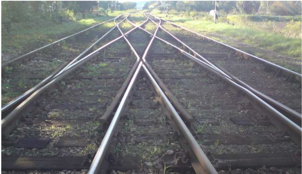
Obr. 28 Kolejová křižovatka na začátku bohulavického zhlaví
