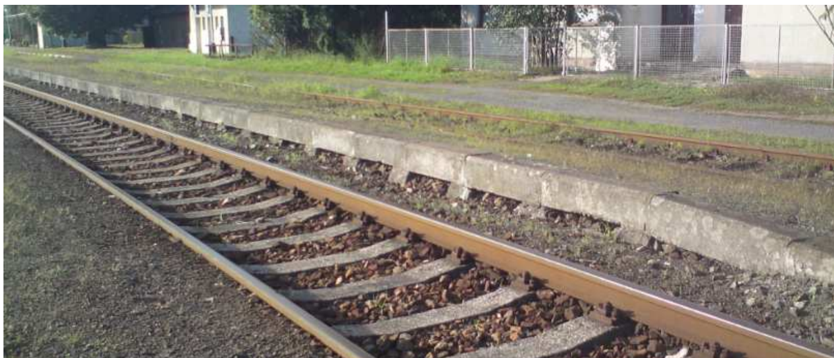
Obr. 17 Detail nástupní hrany, tvárnice Tischer
