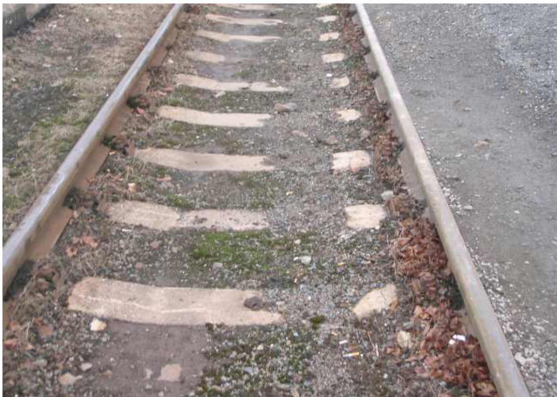
Obr. 19 Železniční svršek – pražce SB5, kolejnice S49
