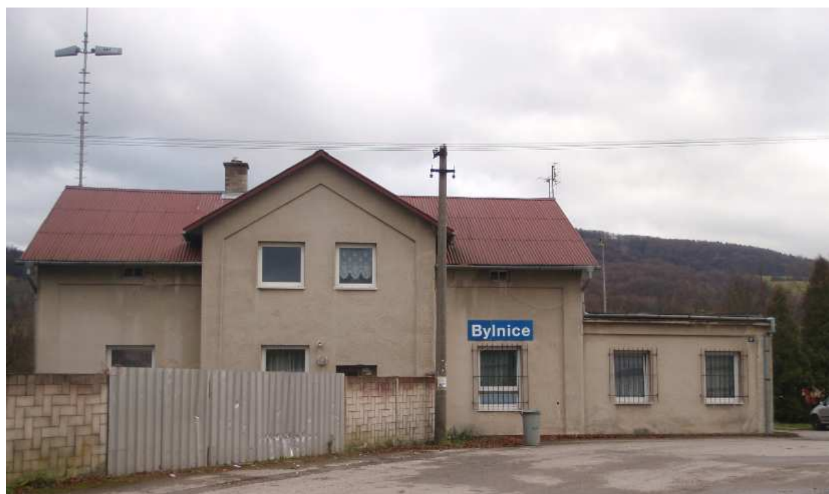
Obr. 2 Výpravní budova v pohledu z příjezdové komunikace
