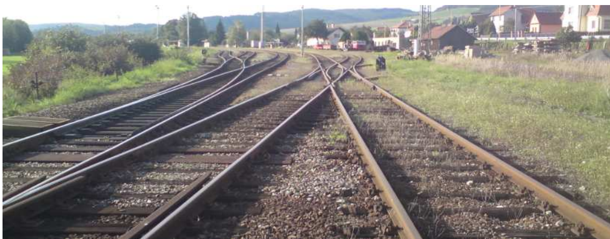
Obr. 31 Rozvětvení vlárského zhlaví; vpravo křižovatková výhybka
