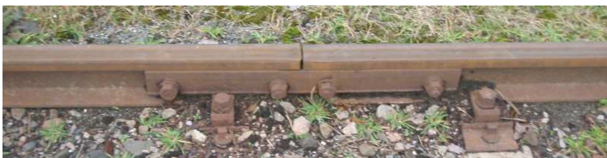
Obr. 23 Kolejnicový styk v manipulační koleji
