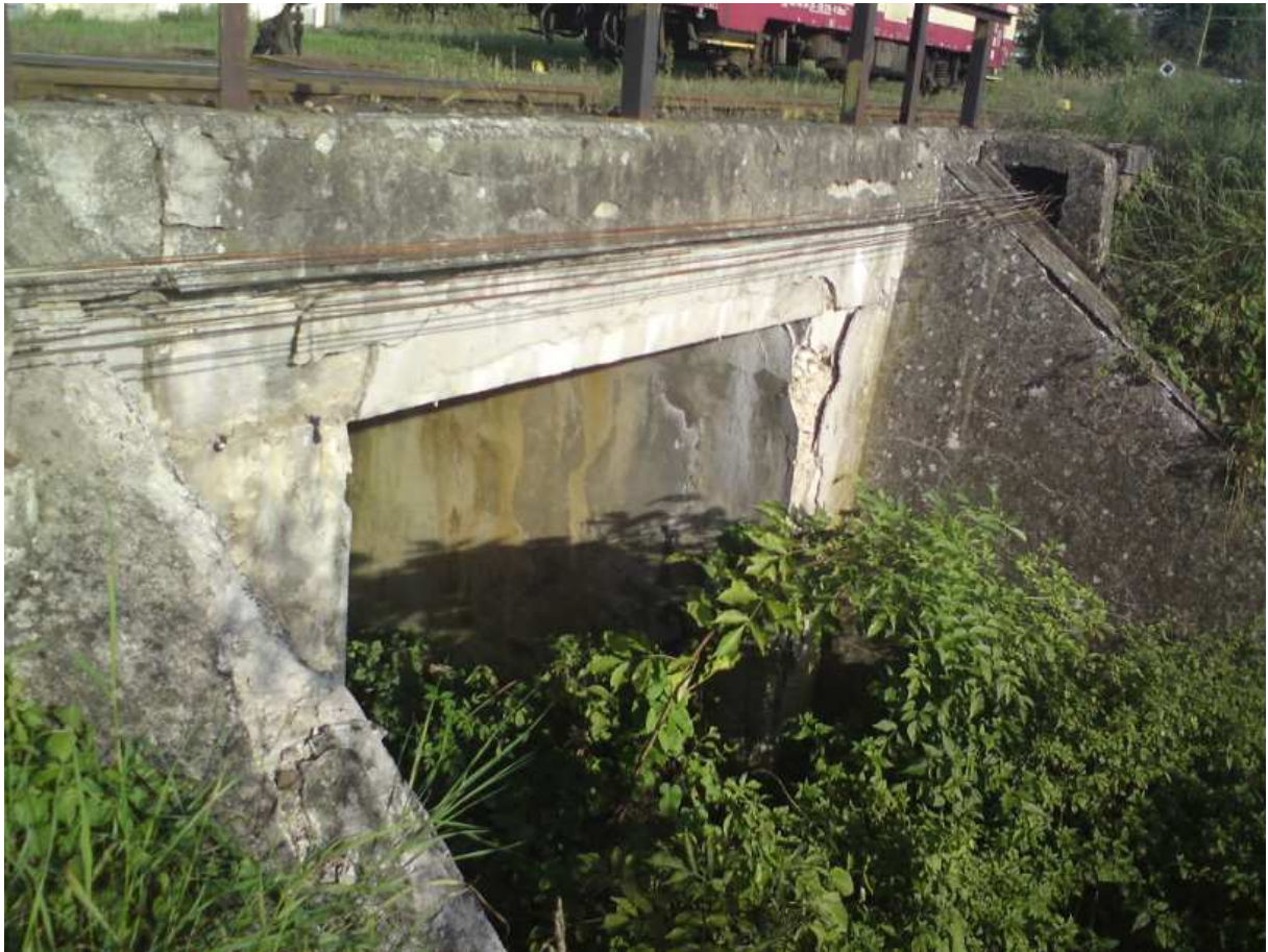
Obr. 35 Mostní objekt v km 158,124
