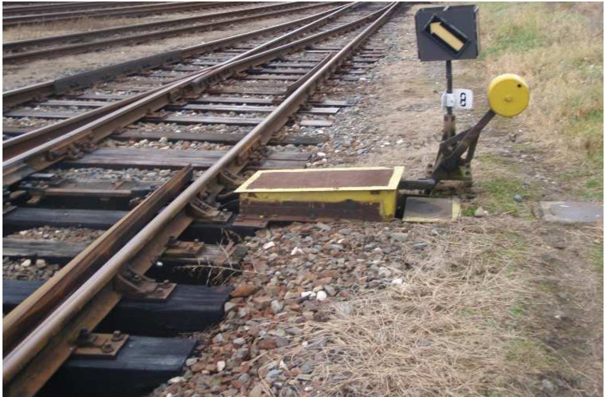
Obr. 24 Stávající výhybka č. 8
