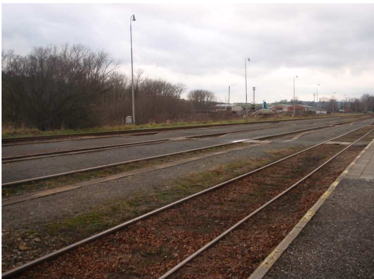
Obr. 16 Pohled na nástupiště od VB včetně osvětlení
