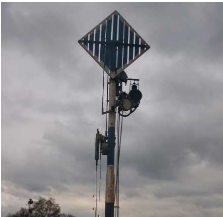
Obr. 33 Mechanické seřadovací návěstidlo
