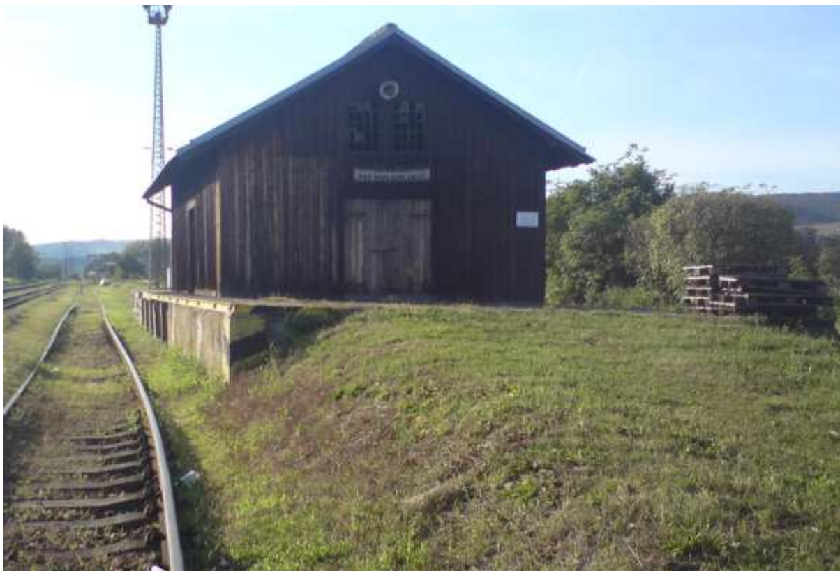
Obr. 7 V současné době nevyužívané skladiště s boční rampou, do budoucna volné prostory pro muzeum, případně jiné služby
