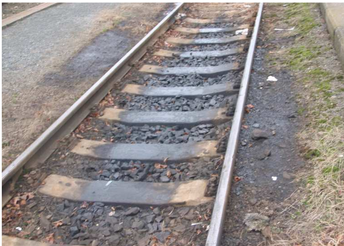
Obr. 20 Značně znečištěné štěrkové lože
