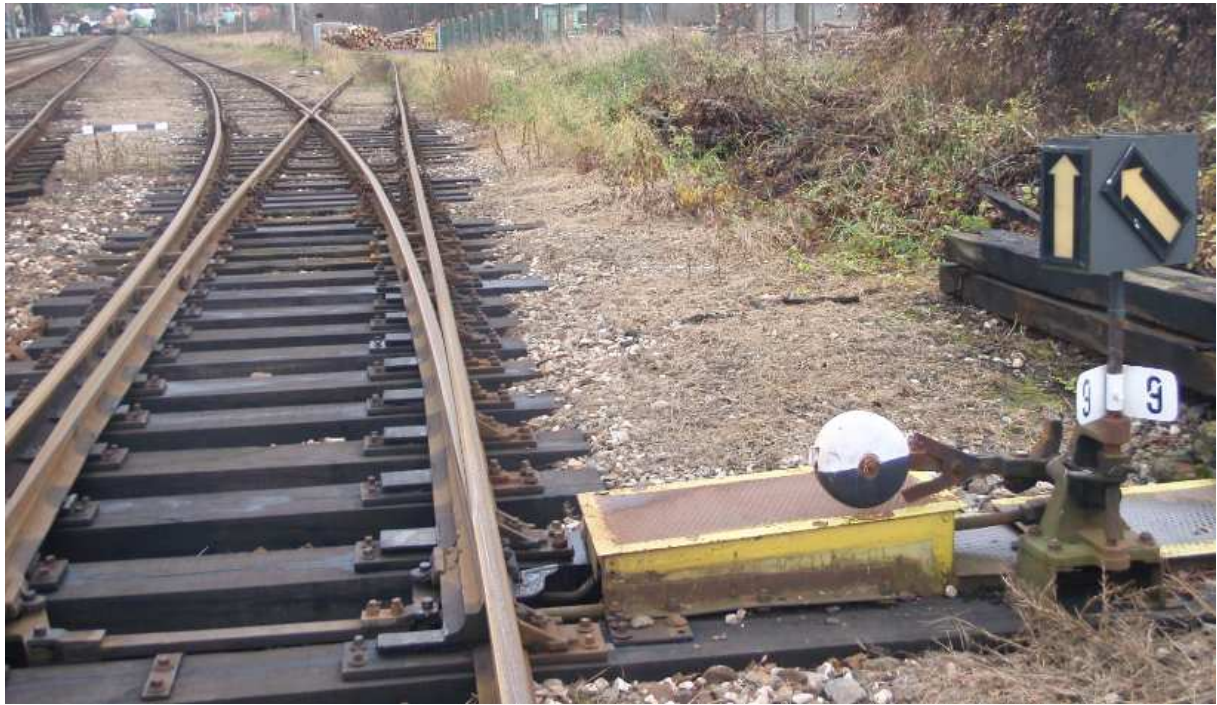
Obr. 26 Výhybka č. 9 umožňující odbočení na vlečku Kloboucká lesní s.r.o.
