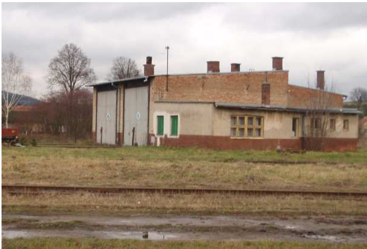
Obr. 9 Místní depo s nocležnou v popředí
