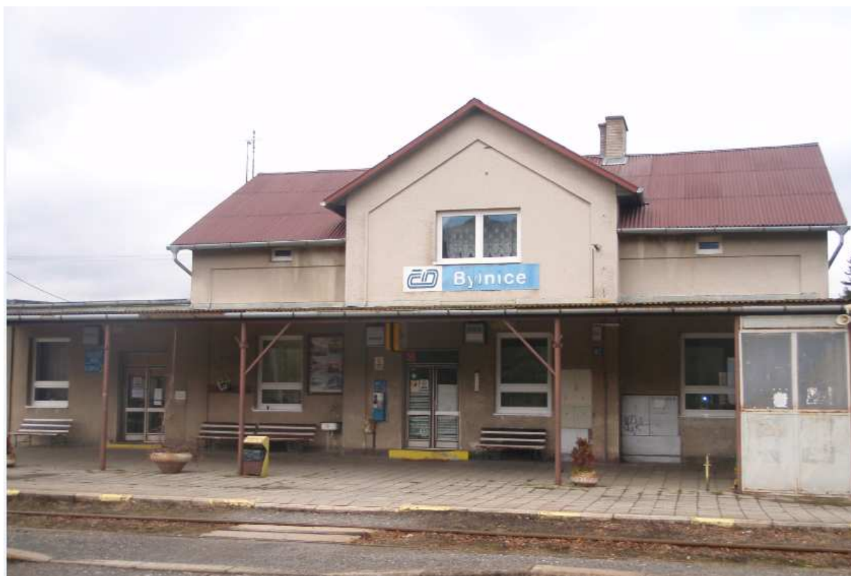
Obr. 1 Výpravní budova v pohledu z kolejiště
