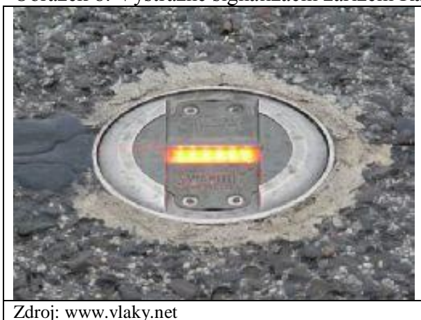
Obrázek 8: Výstražné signalizační zařízení Rail-flash
