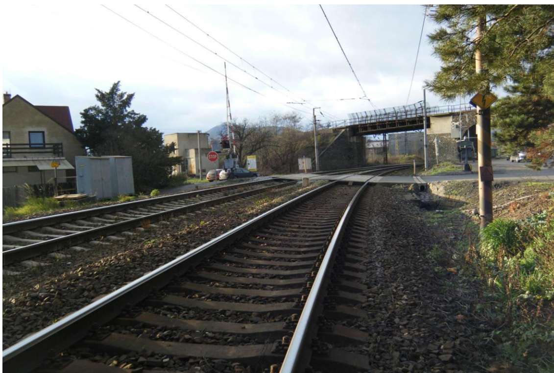
Traťová kolej na vjezdu do stanice od Litoměřic
