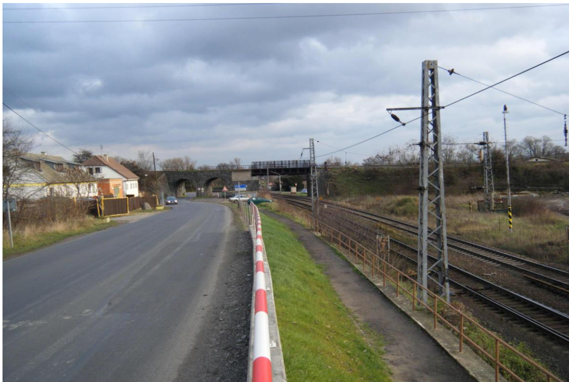
Pohled od kolejové spojky vjezdu na traťovou kolej s křížením s tratí č.087
