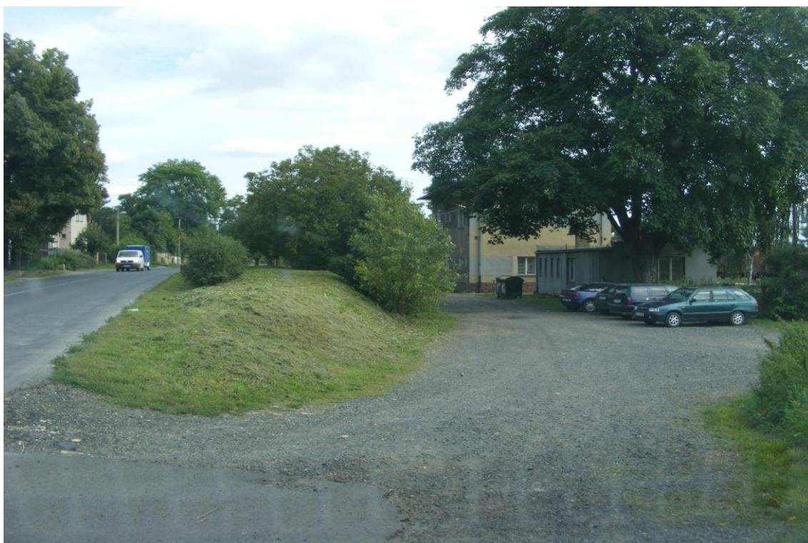
Výpravní budova – pohled na přednádražní plochu
