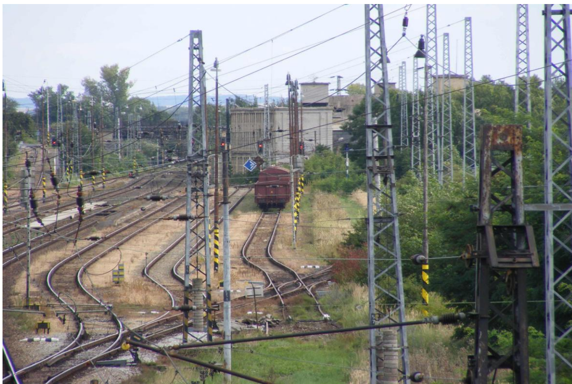
Pohled na lichou skupinu kolejí – křižovatková výhybka po snesené vlečce
