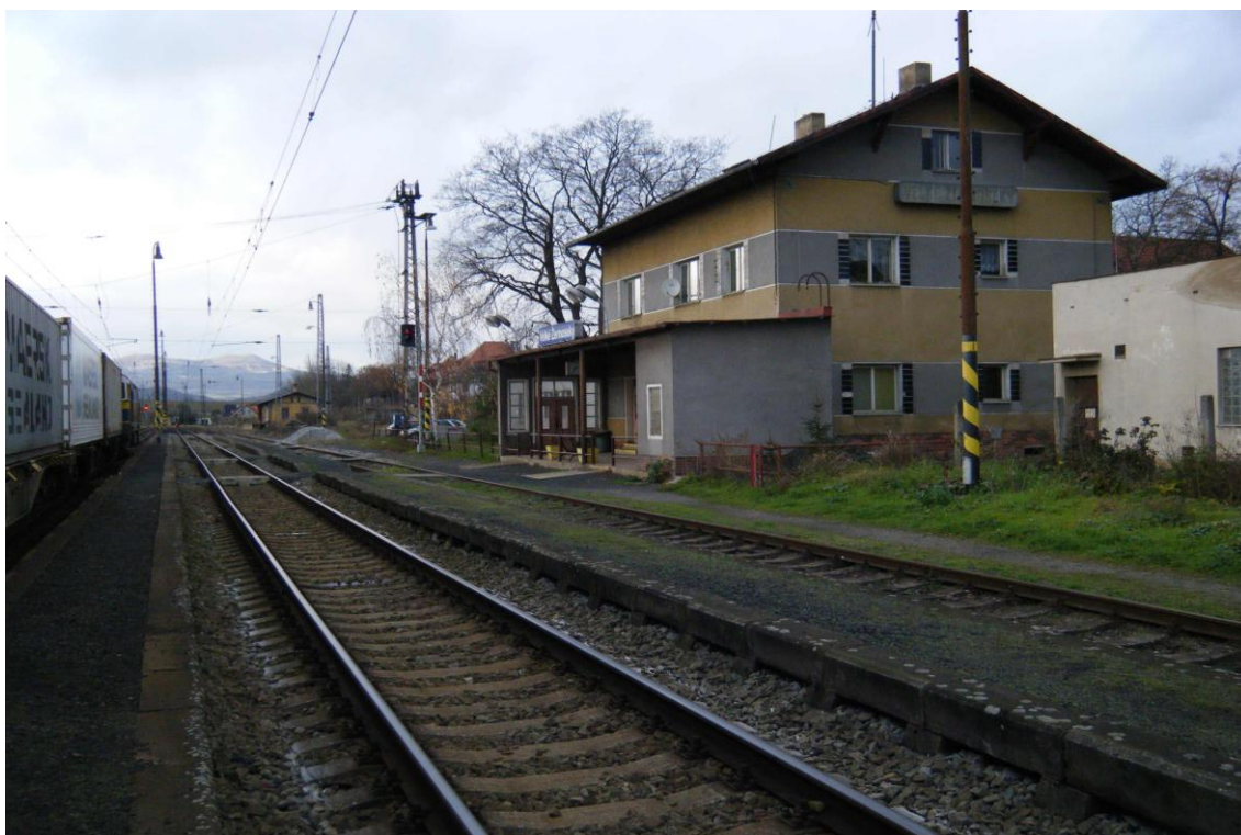
Železniční stanice Velké Žernoseky – výpravní budova
