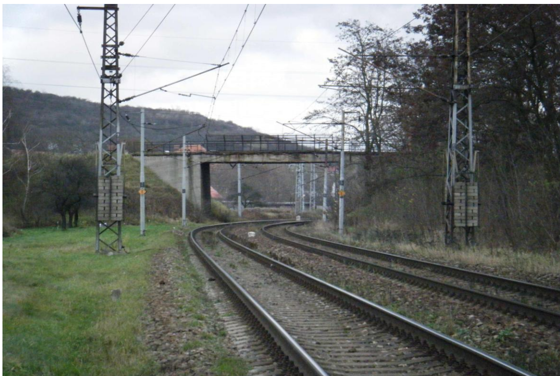
Trat'ová kolej a silniční nadjezd u Sebuzínského zhlaví
