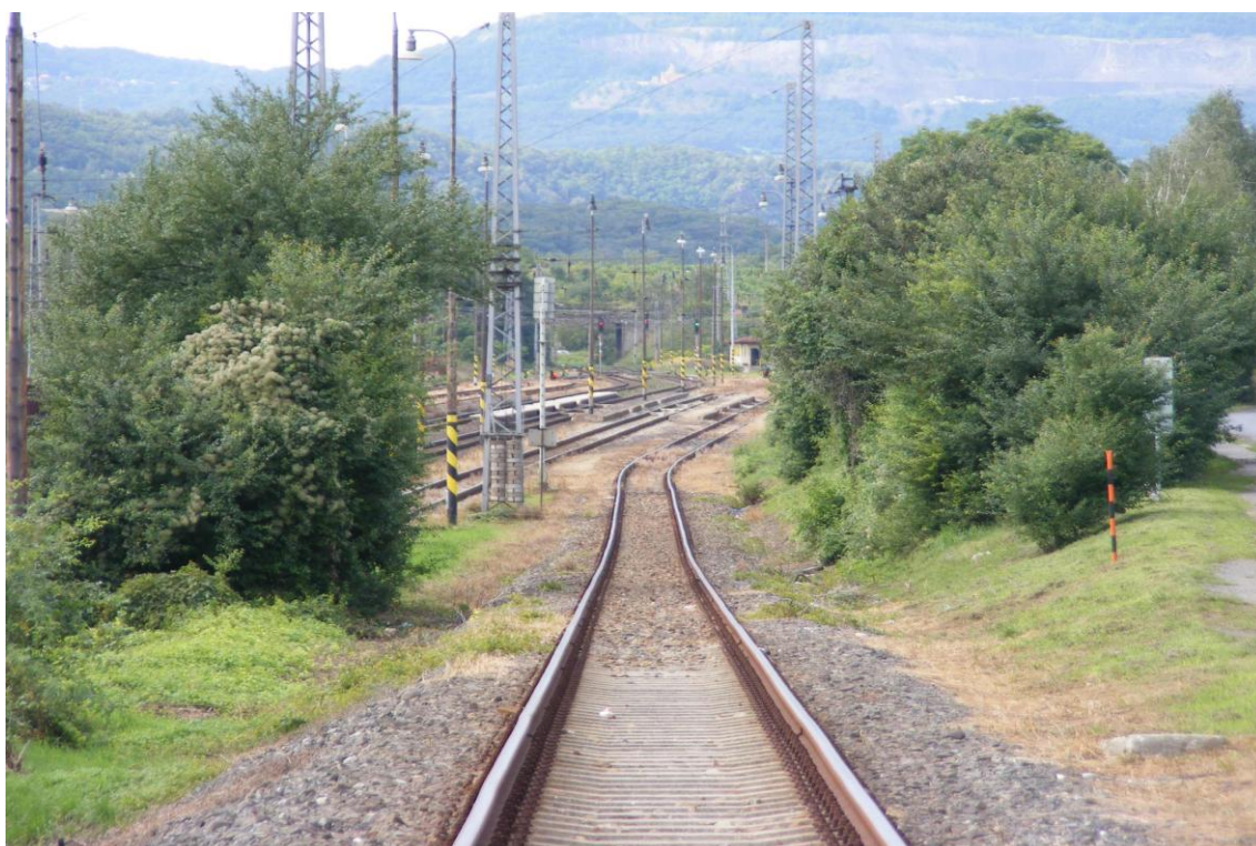
Kolej propojující stanici s tratí č.087
