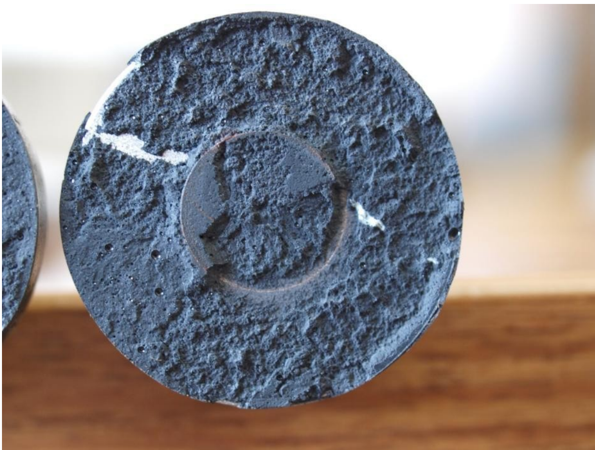
Obr. 5.9 Detail porušení lepeného spoje
