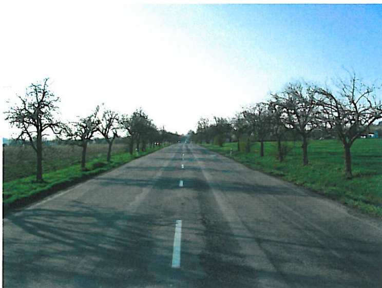
Obr.: Stávající komunikace, pohled na obec Boseň proti směru staničení.
