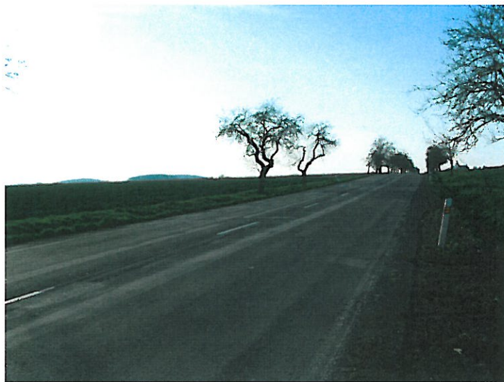
Obr.: Stávající převáděná komunikace v místě konečného napojení.
