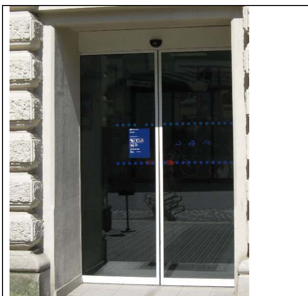
Obr.3.5.2.1: Označení na dveřích pro vstup do VB
