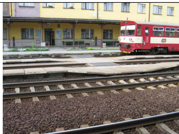
Obr.3.21.1.2: Přechod přes koleje – pohled k VB
