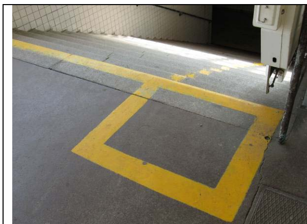
Obr.3.14.1.1: Schodiště do podchodu od VB
