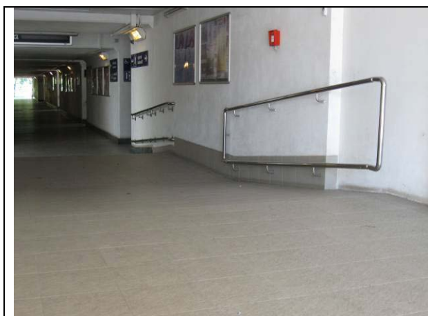
Obr.3.15.2.1: Madla u rampy v podchodu
