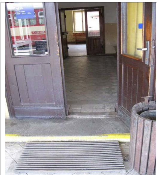
Obr.3.2.1.1: Pohled z nástupiště do výpravní budovy
