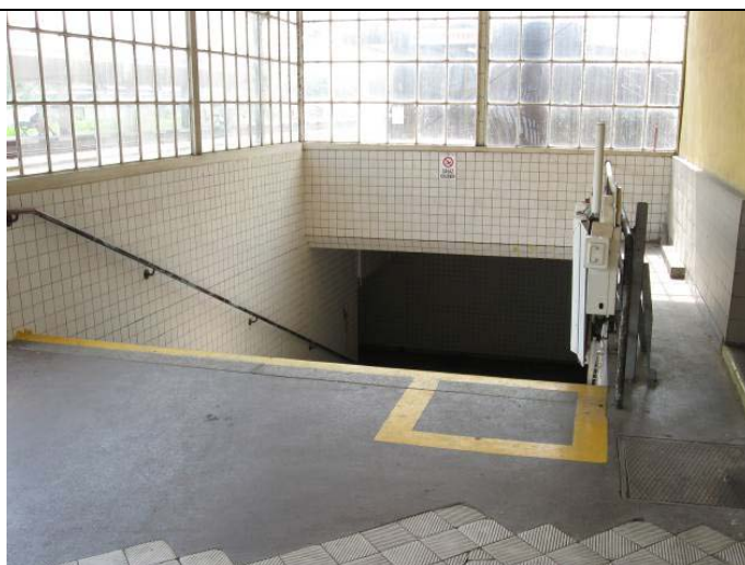
Obr.4.2.4: Plošina do podchodu
