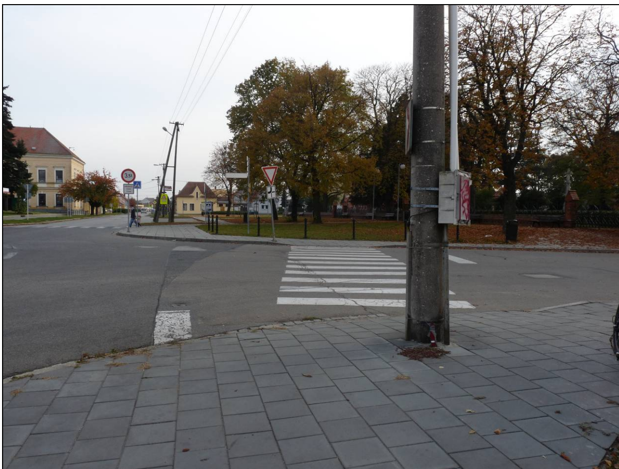
Obrázek J. Sloup elektrického vedení v prostoru před přechodem
