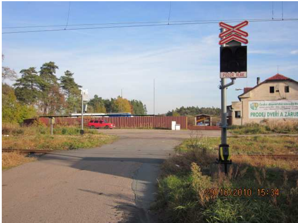
Železniční přejezd přes kolej směr Hradec Králové
