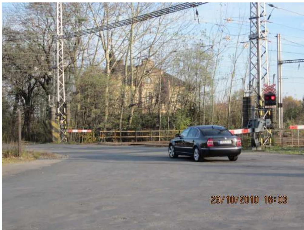
Železniční přejezd v kolínském zhlaví
