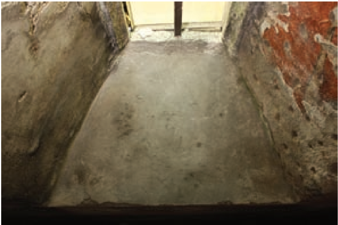
10. Parapet okenní špalety
