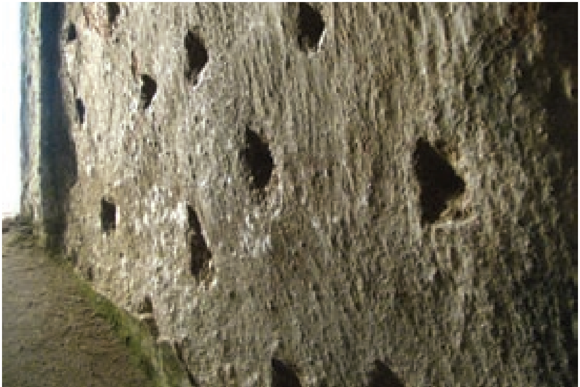
30. Napadení mikroorganismy v pravé části okenní špalety (plísně a zelená řasa)
