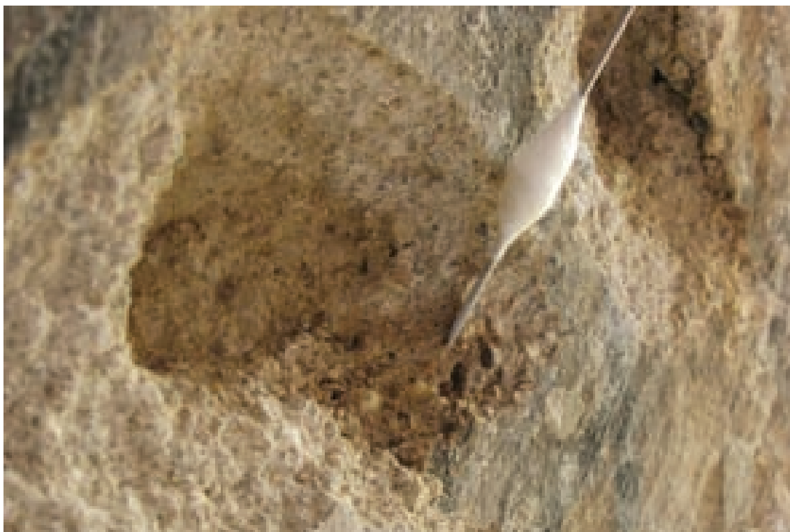
7. Konsolidace okrajů peků vápennou alkoholovou nanosuspenzí CaLoSil E25 pomocí injekční stříkačky s jehlou
