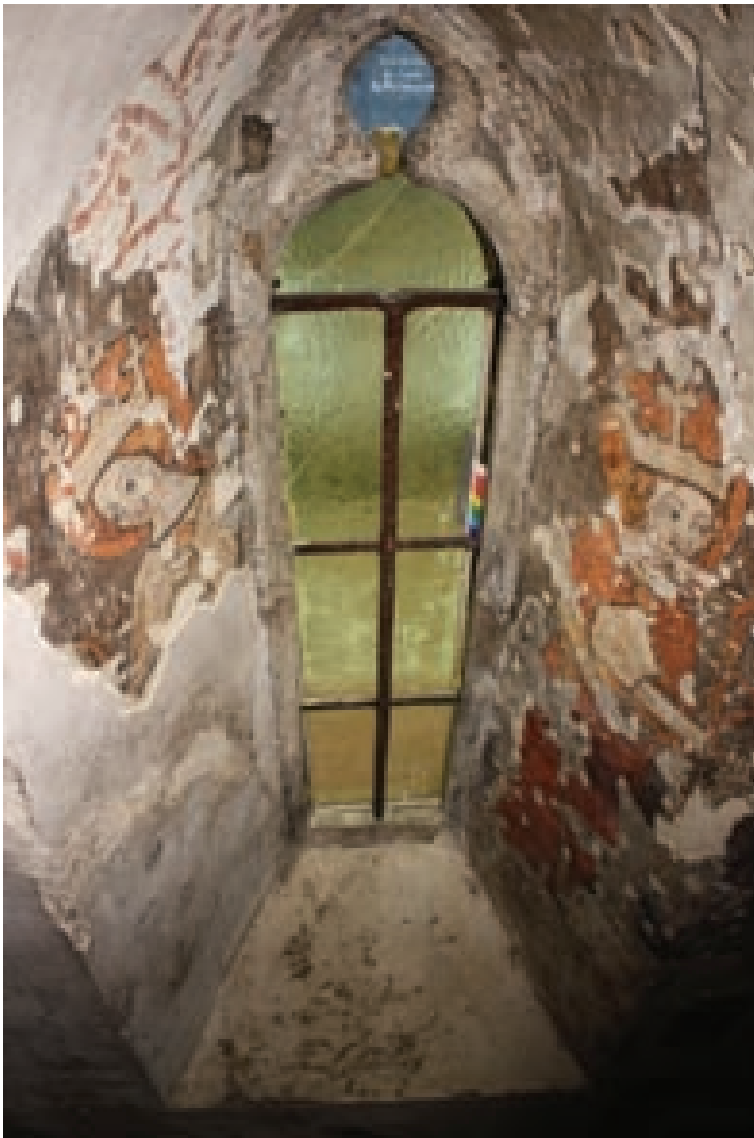
27. Celkový pohled do okenní špalety na východní stěně, stav po restaurování
