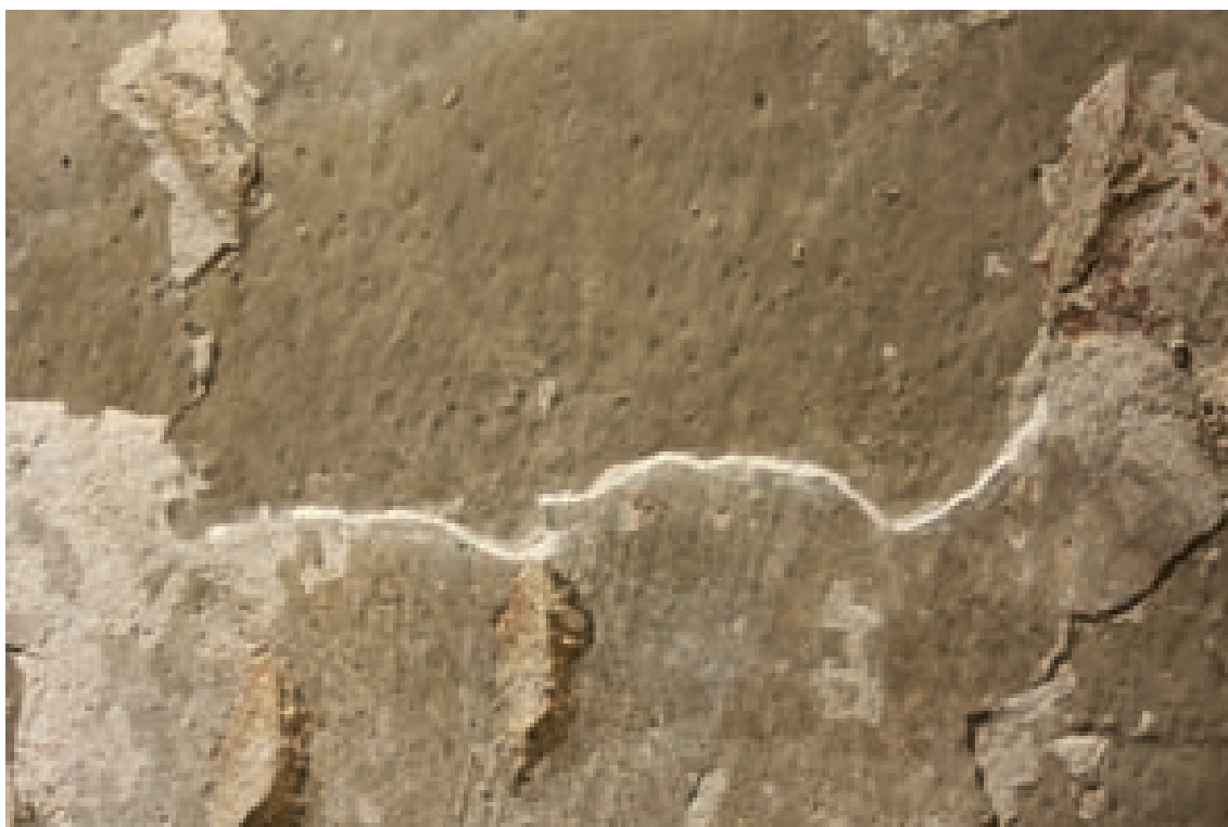
8. Upevňování okrajů nesoudržných nátěrových vrstev obtmelením jemnou maltovinou
