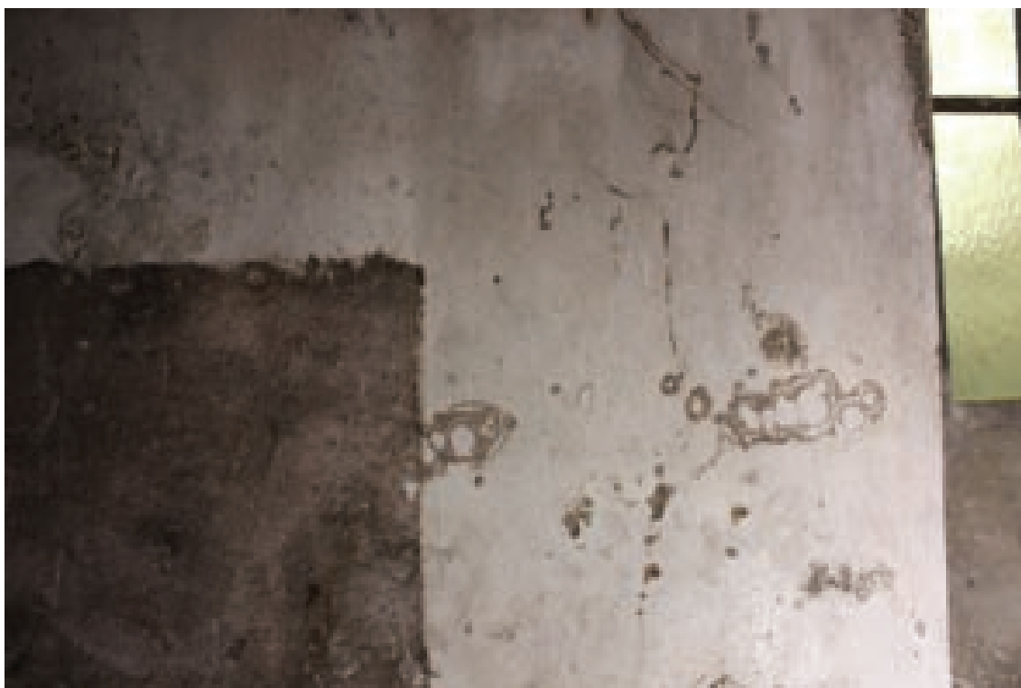
4. Levá polovina východní stěny - postup snímání nečistot z povrchu barokní omítky vodou za pomoci mikroporézní houby
