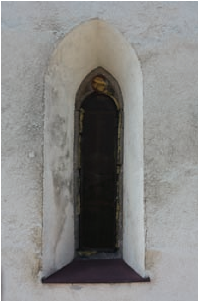
3. Okno východní stěny
