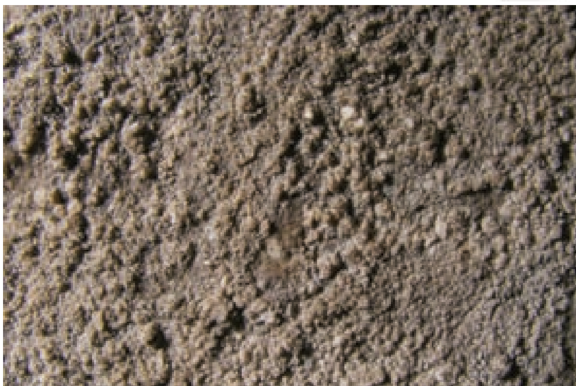
45. Šedavá eflorescence s vlhkým povrchem a měkkou strukturou na barokní omítce (S3)
