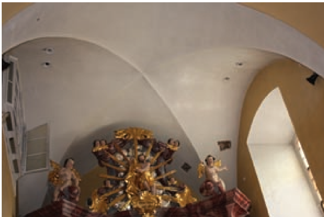
34. Čtyři větrací průduchy nacházející se v klenbě presbyteria
