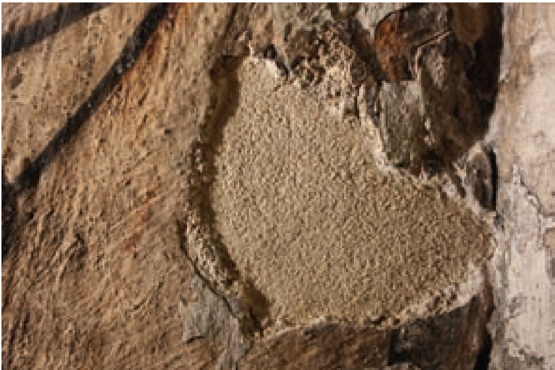
22. Detail tmelu zpracovaného pod úroveň povrchu okolní malby v bočním osvětlení
