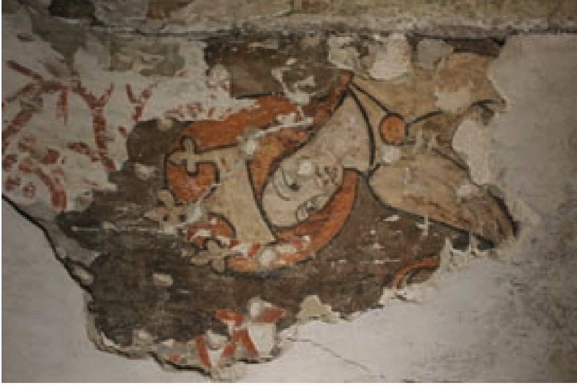
20. Postava neznámé svěťice, stav po vytmeleni defektů hrubým tmelem (1. vrstva)
