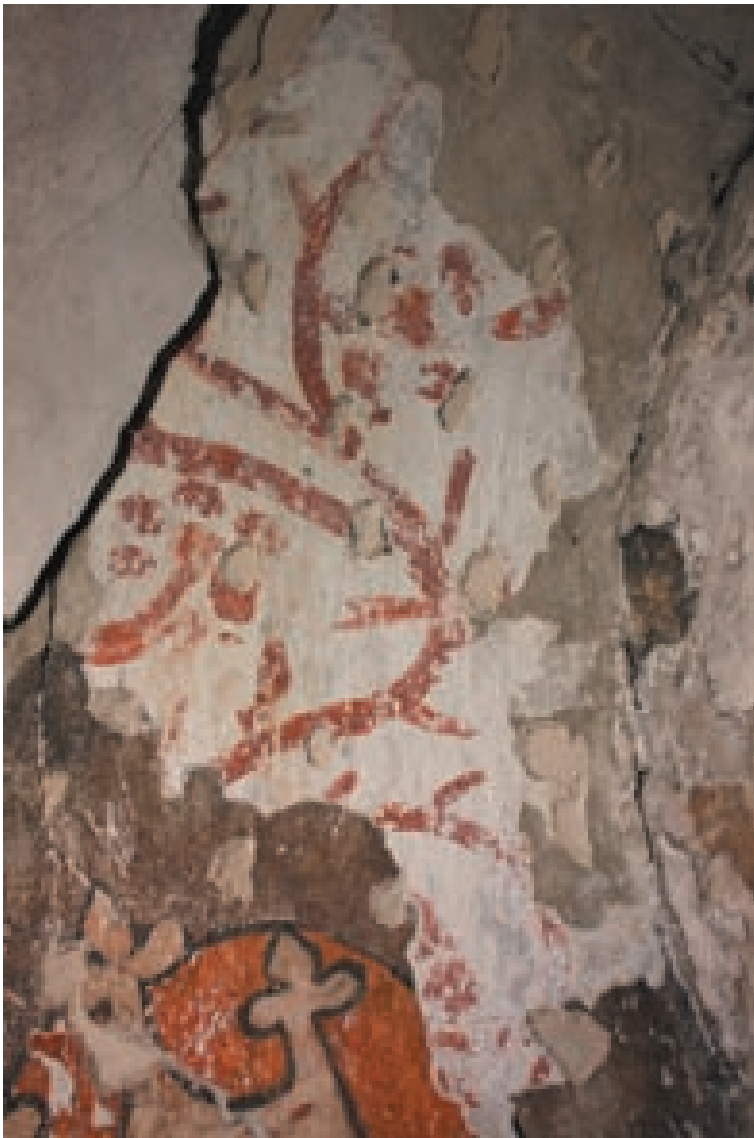
25. Fragment červeného rozvilinového dekoru v horní části levé poloviny okenní špalety, stav po restaurování
