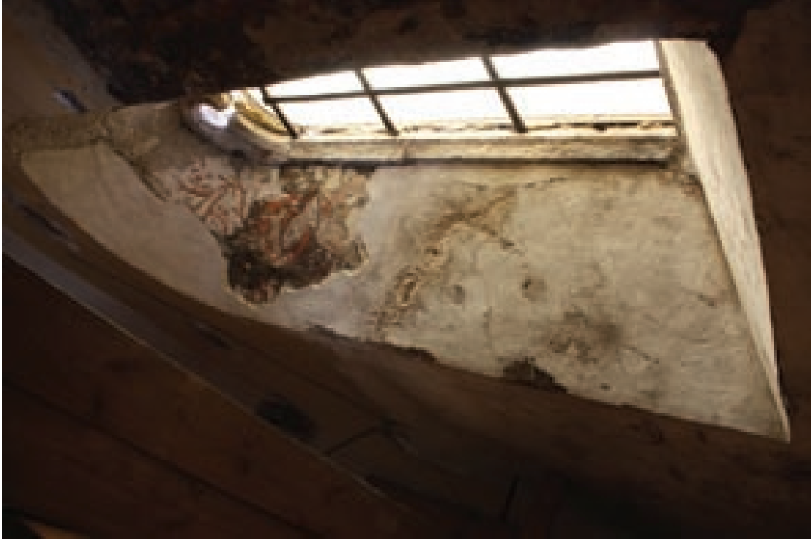
29. Celkový pohled na levou polovinu okenní špalety, stav po restaurování
