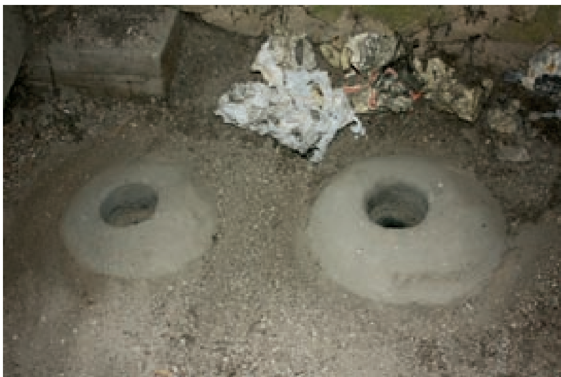
35. Detail větracích průduchů v klenbě presbyteria, které byli ucpány novinovým papírem z roku 1967 (stav po vyjmutí novin)
