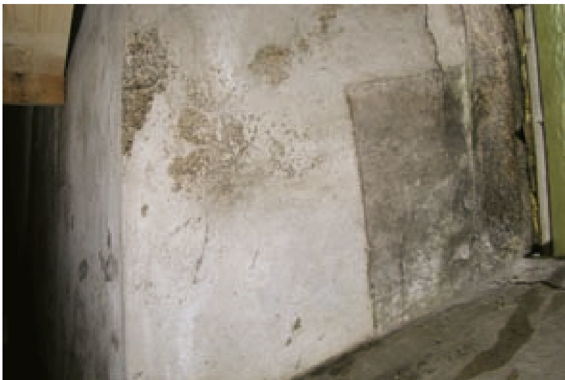
3. Levá polovina okenní špalety - snímání nečistot z povrchu barokní omítky vodou za pomoci mikroporézní houby
