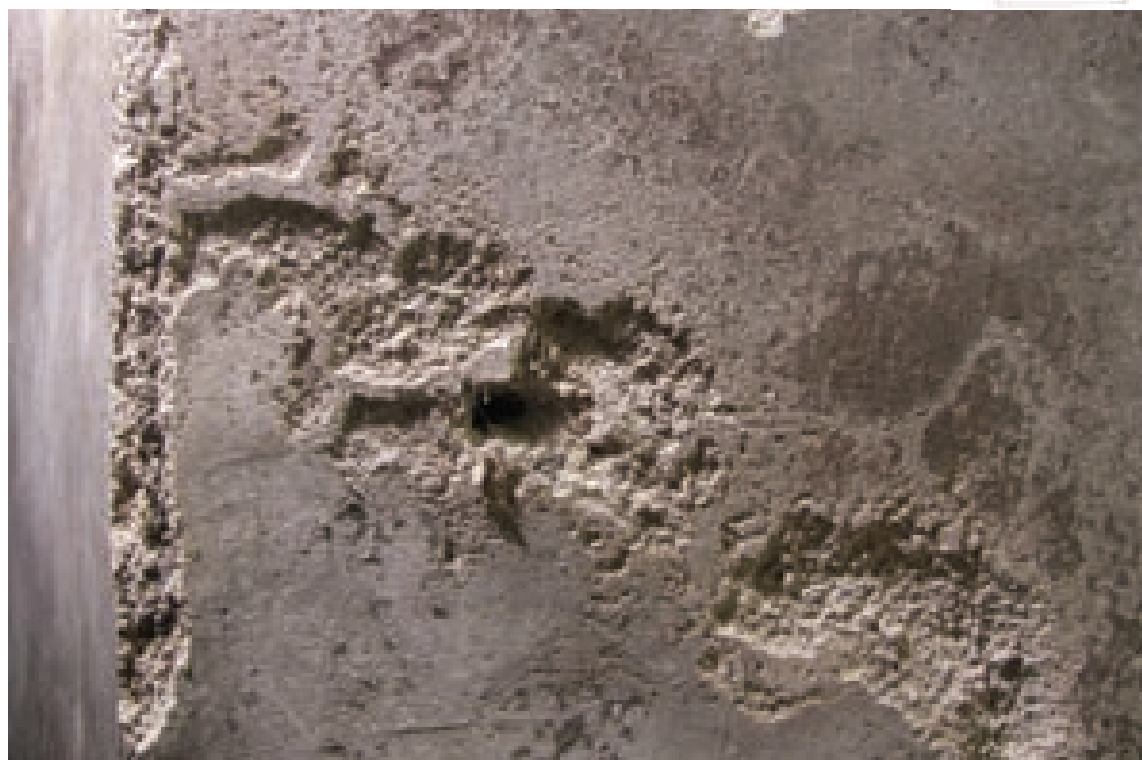
41. Povrch barokní omítky v levé části okenní špalety degradovaný činností vodorozpustných solí
