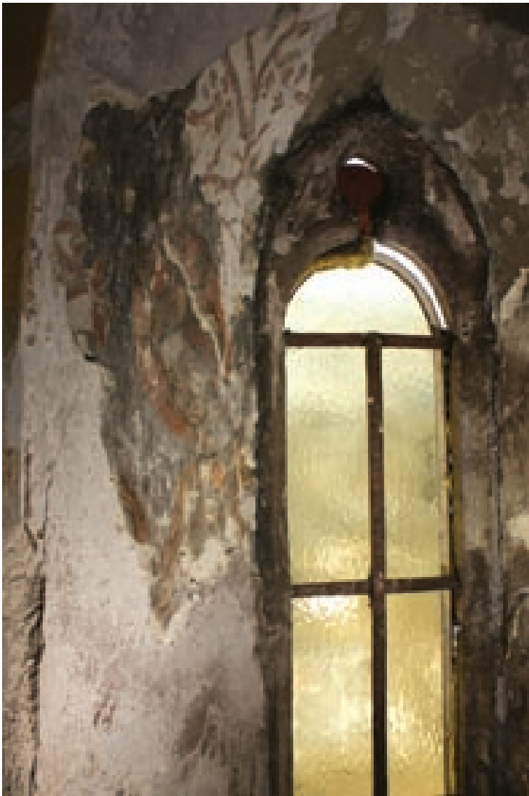
7. Okenní špaleta východní stěny
