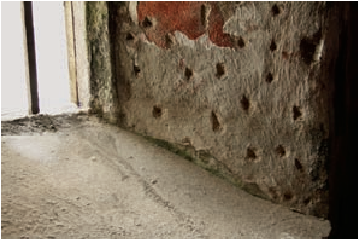
9. Parapet okenní špalety se stopami navátého sněhu; stav k 1. 2. 2010 (foto: Mgr. art. Jan Vojtěchovský)
