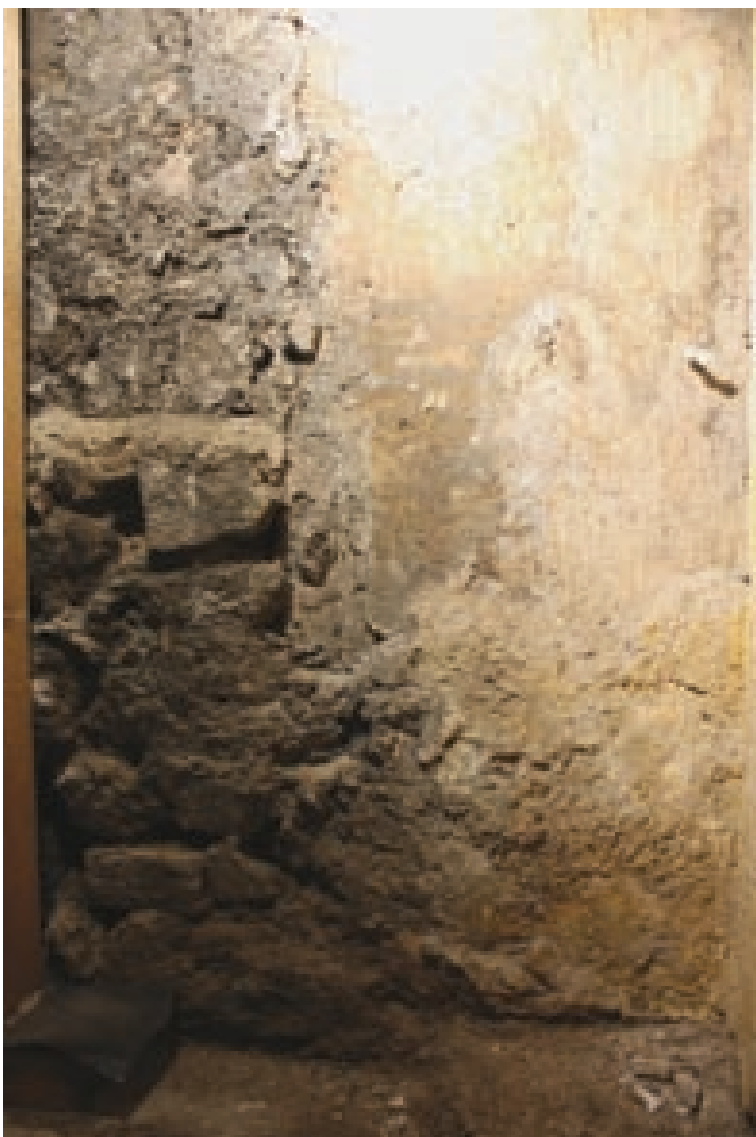
24. Pohled na pravý dolní roh východní stěny s viditelným zdivem a degradovanými omítkami; omítka v pravé části snímku byla až donedávna skryta pod heraklitovými deskami
