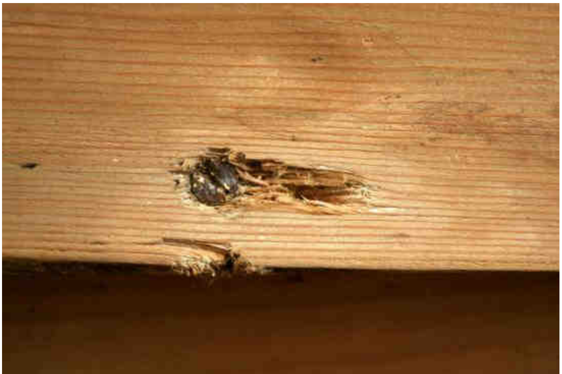
Obr. č. 175: Stav po odstranění starých tmelů, detail zadní strany, denní rozptýlené světlo.
