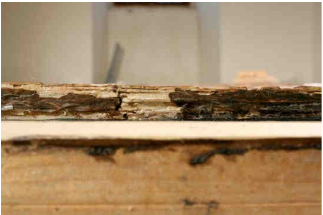
Obr. č. 83: Stav po vyrovnání, boční detail, denní rozptýlené světlo.
