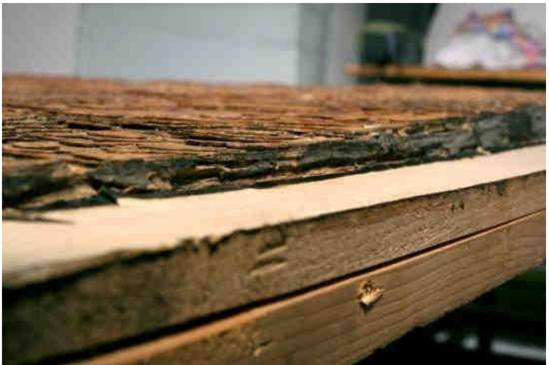
Obr. č. 79: Stav po vyrovnání, boční detail, denní rozptýlené světlo.
