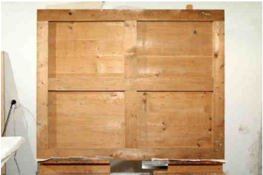
Obr. č. 179: Stav po tmelení, celkový pohled na zadní stranu, denní rozptýlené světlo.
