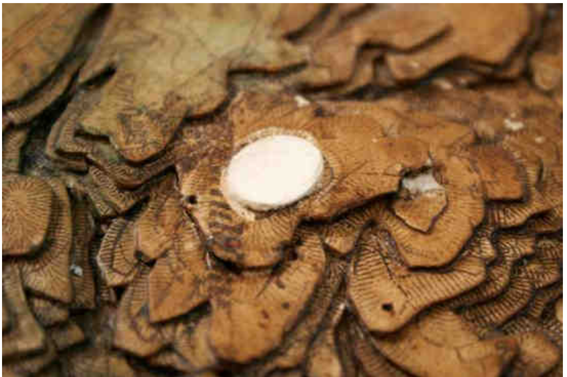
Obr. č. 127: Stav po tmelení lepenek, detail, denní rozptýlené světlo.
