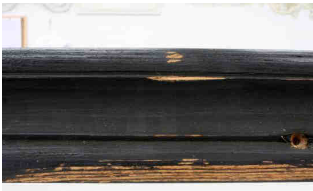
Obr. č. 51: Stav před restaurováním, detail rámu, denní rozptýlené světlo.
