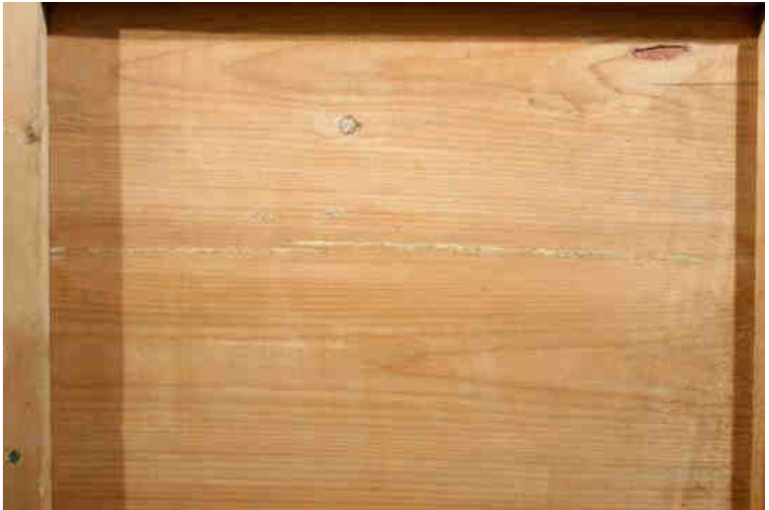
Obr. č. 180: Stav po tmelení, detail zadní strany, denní rozptýlené světlo.
