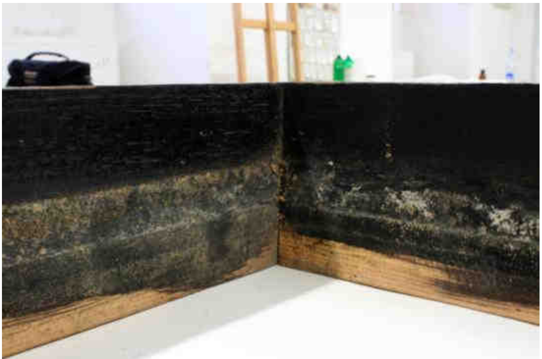
Obr. č. 55: Stav před restaurováním, detail rámu, denní rozptýlené světlo.
