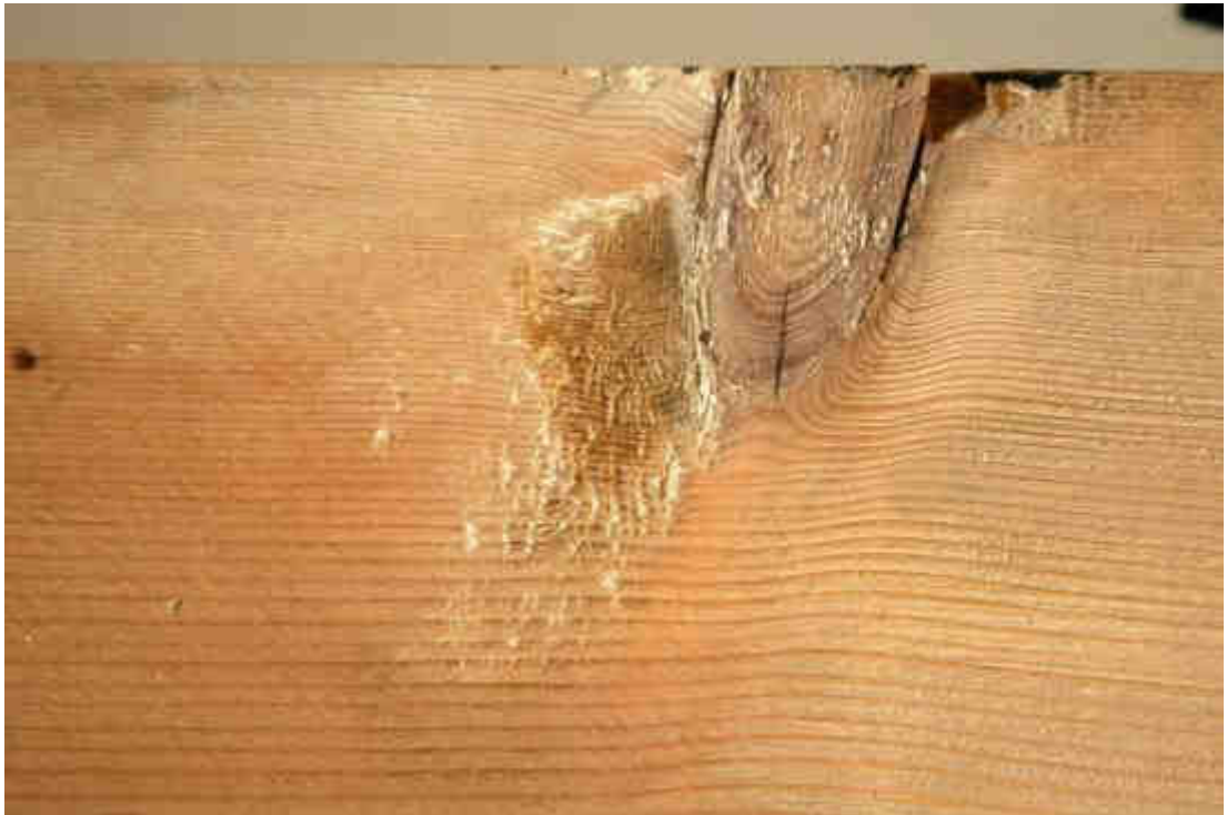
Obr. č. 178: Stav po odstranění starých tmelů, detail zadní strany, denní rozptýlené světlo.
