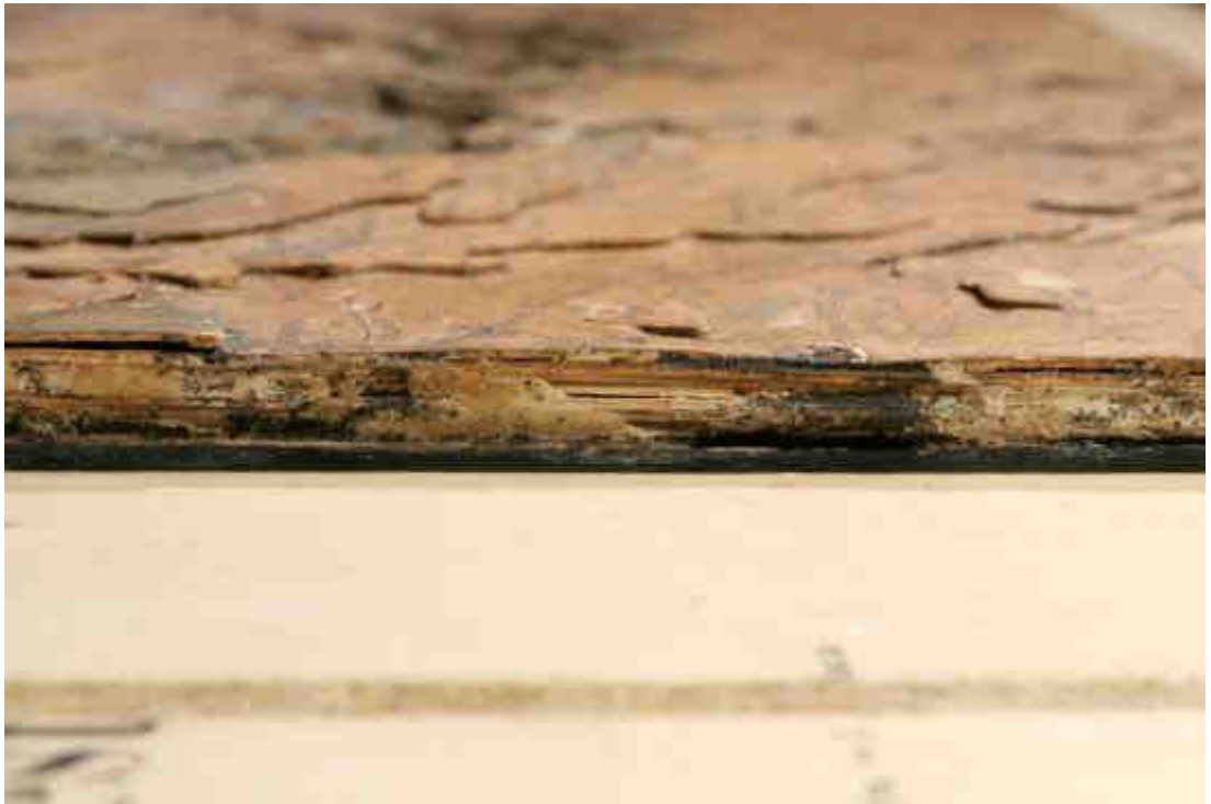
Obr. č. 86: Stav po vyrovnání, boční detail, denní rozptýlené světlo.
