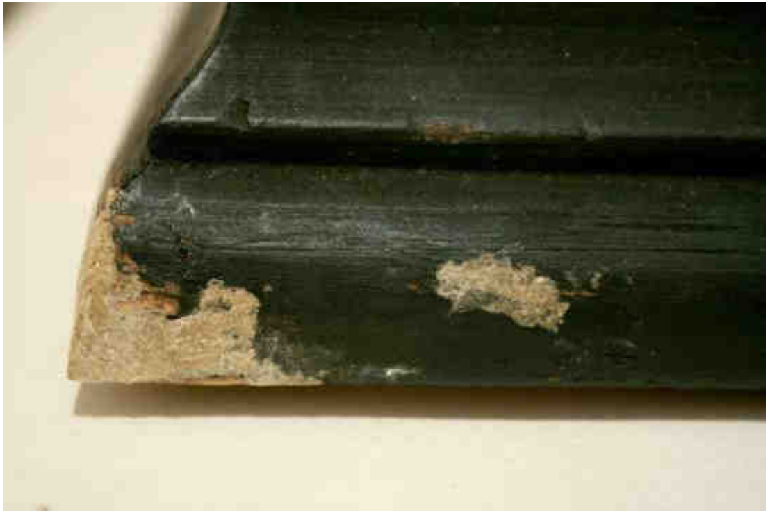
Obr. č. 198: Stav po tmelení, detail rámu, denní rozptýlené světlo.
