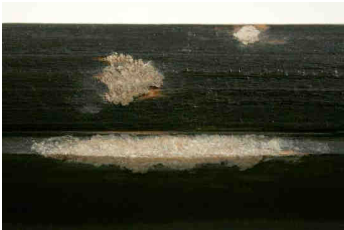
Obr. č. 202: Stav po tmelení, detail rámu, denní rozptýlené světlo.
