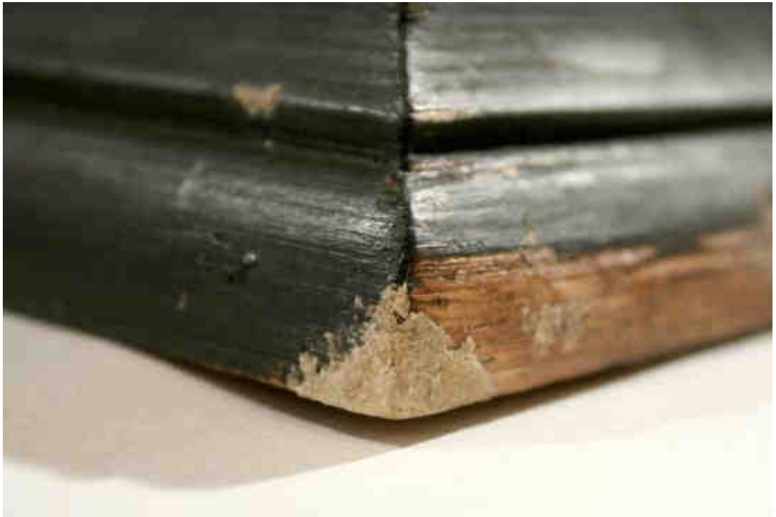
Obr. č. 196: Stav po tmelení, detail rámu, denní rozptýlené světlo.
