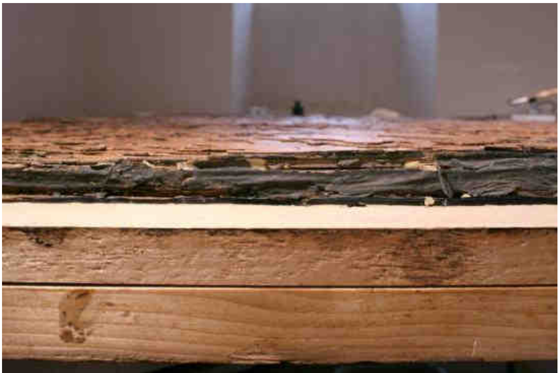
Obr. č. 81: Stav po vyrovnání, boční detail, denní rozptýlené světlo.
