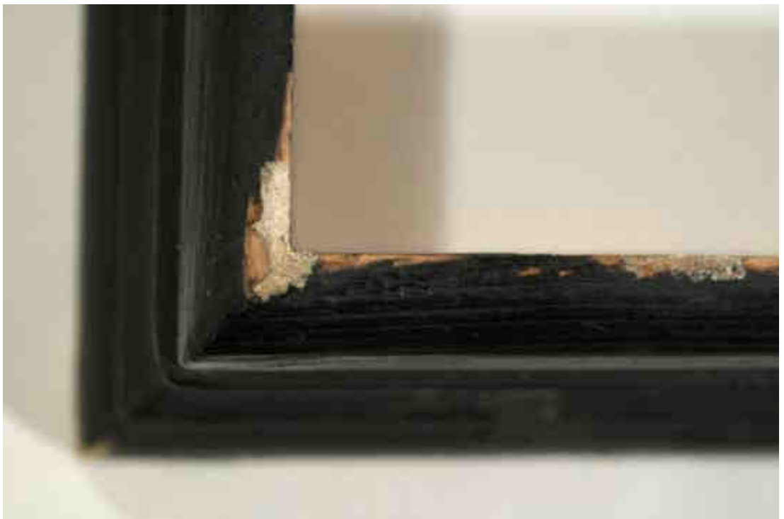
Obr. č. 199: Stav po tmelení, detail rámu, denní rozptýlené světlo.
