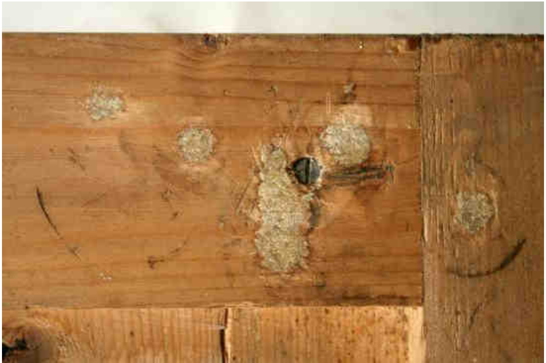
Obr. č. 184: Stav po tmelení, detail zadní strany, denní rozptýlené světlo.
