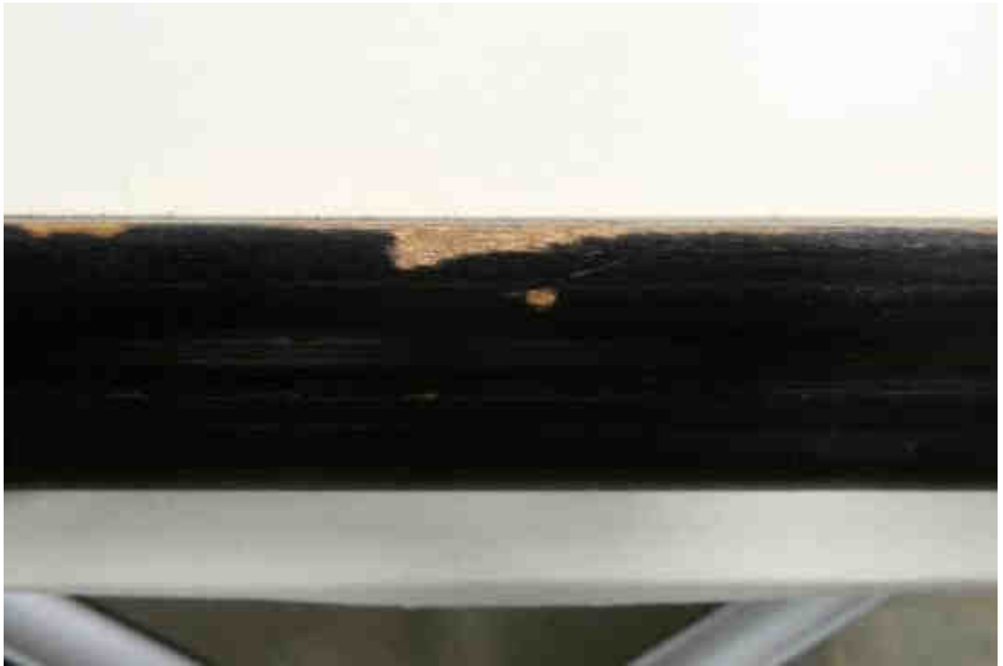
Obr. č. 54: Stav před restaurováním, detail rámu, denní rozptýlené světlo.
