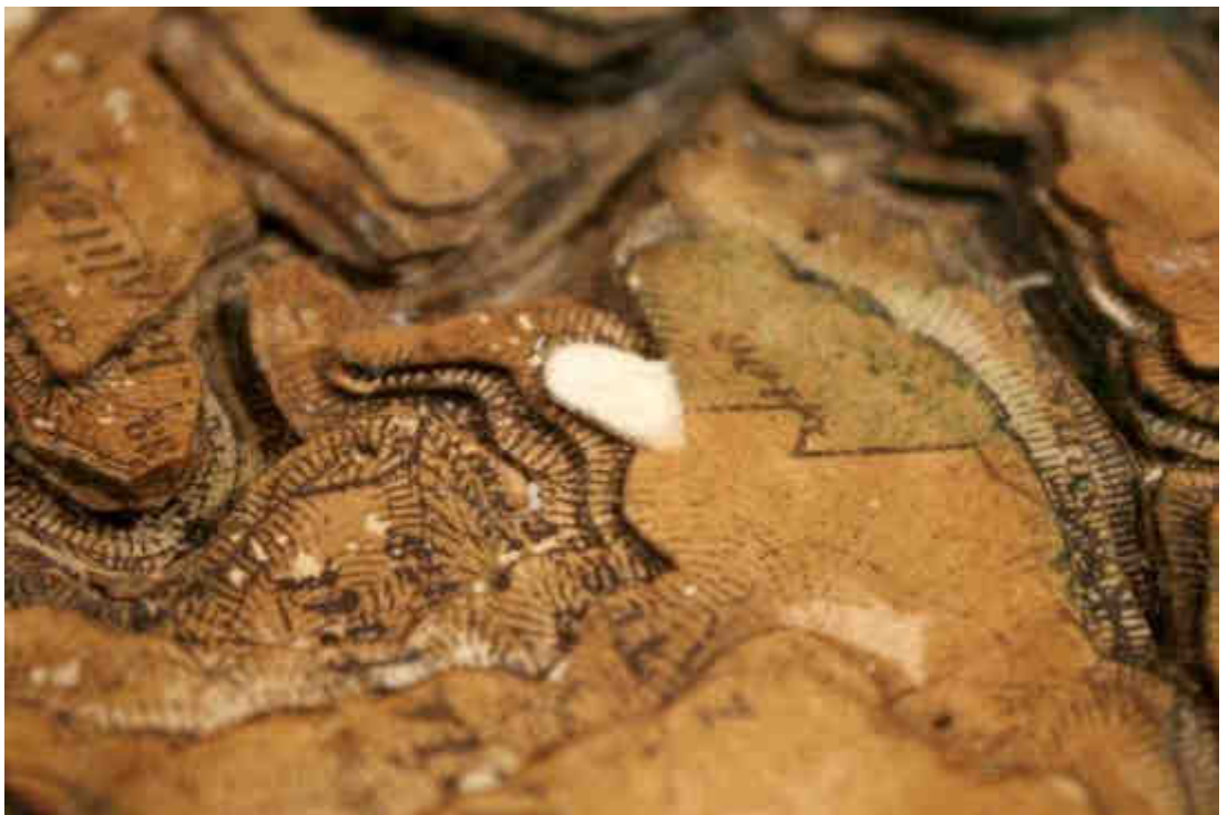
Obr. č. 115: Stav po tmelení lepenek, detail, denní rozptýlené světlo.
