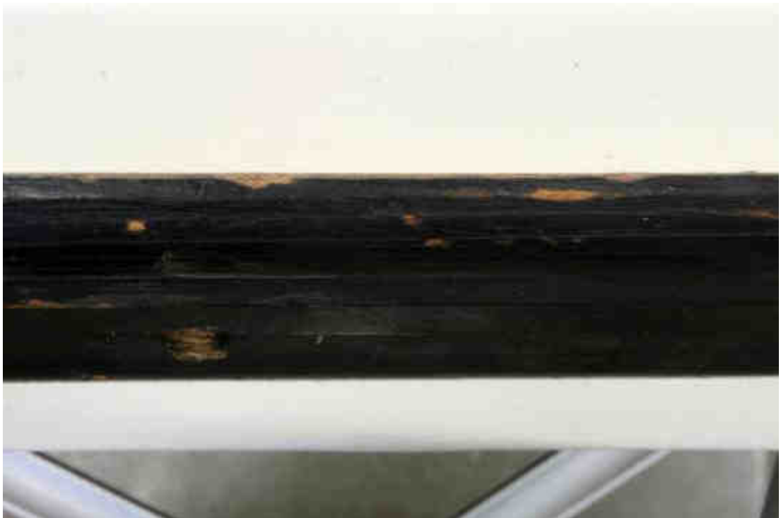
Obr. č. 53: Stav před restaurováním, detail rámu, denní rozptýlené světlo.
