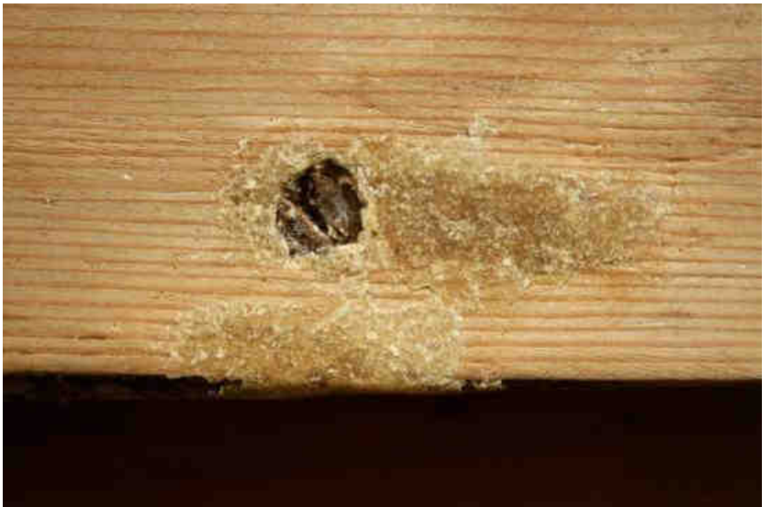
Obr. č. 185: Stav po tmelení, detail zadní strany, denní rozptýlené světlo.
