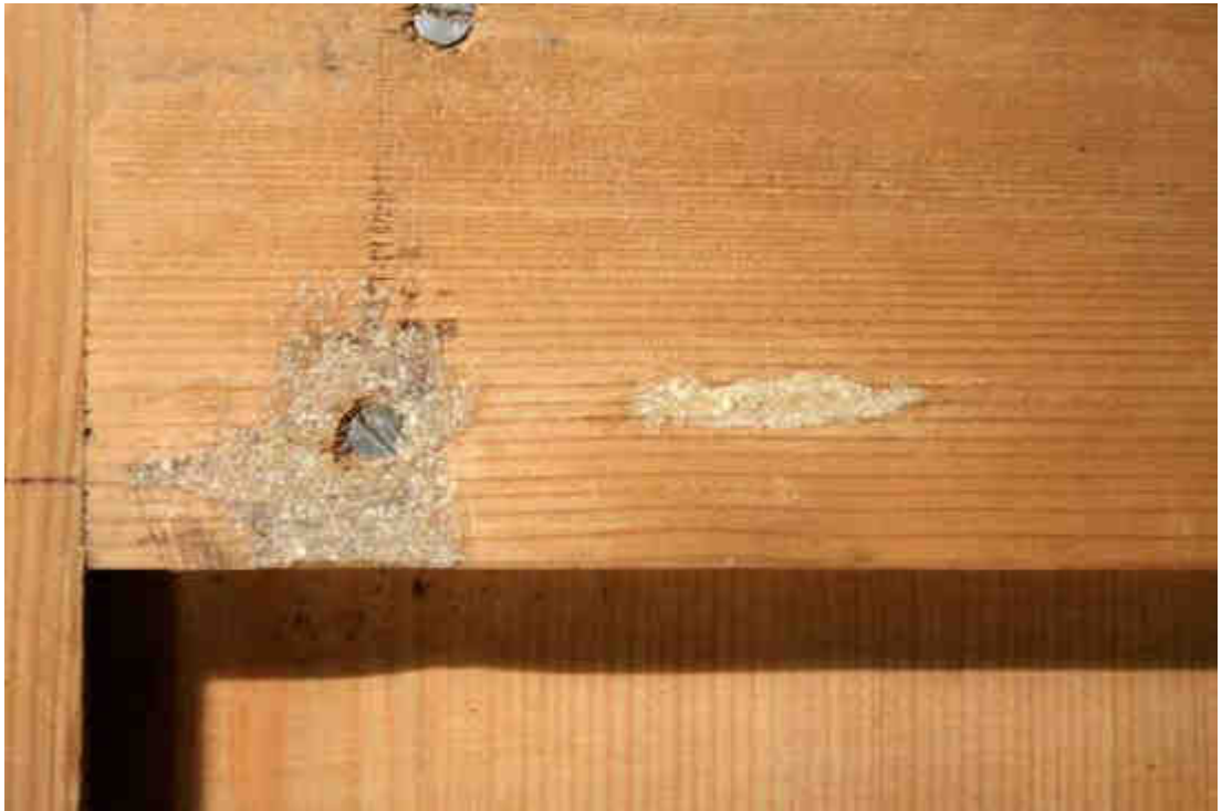
Obr. č. 182: Stav po tmelení, detail zadní strany, denní rozptýlené světlo.
