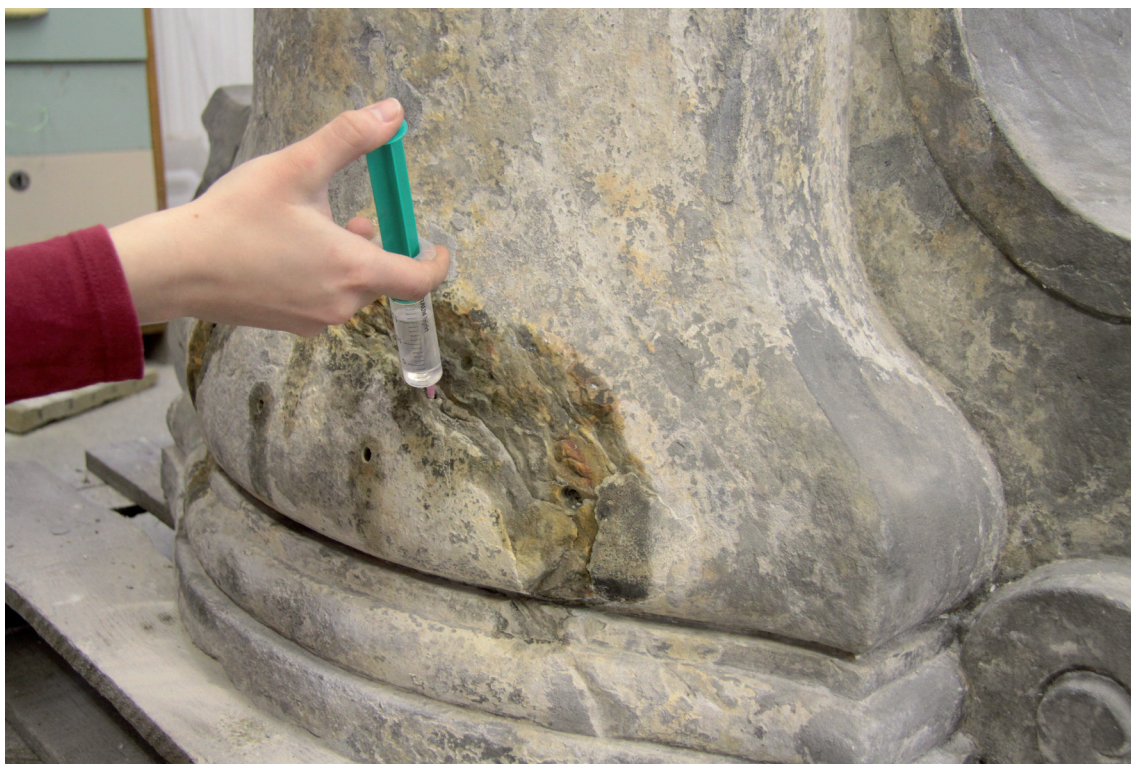
Obr. 41 - Zadní strana podstavce, hloubkové zpevnění Funkosil 300, 500
