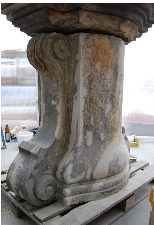
Obr. 42 - Vytmelení zadní části podstavce
