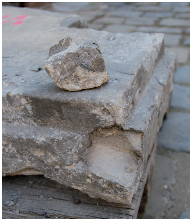
Obr. 52 - Čištění plintu, odstranění tmel z tvrdého bílého tmelu
