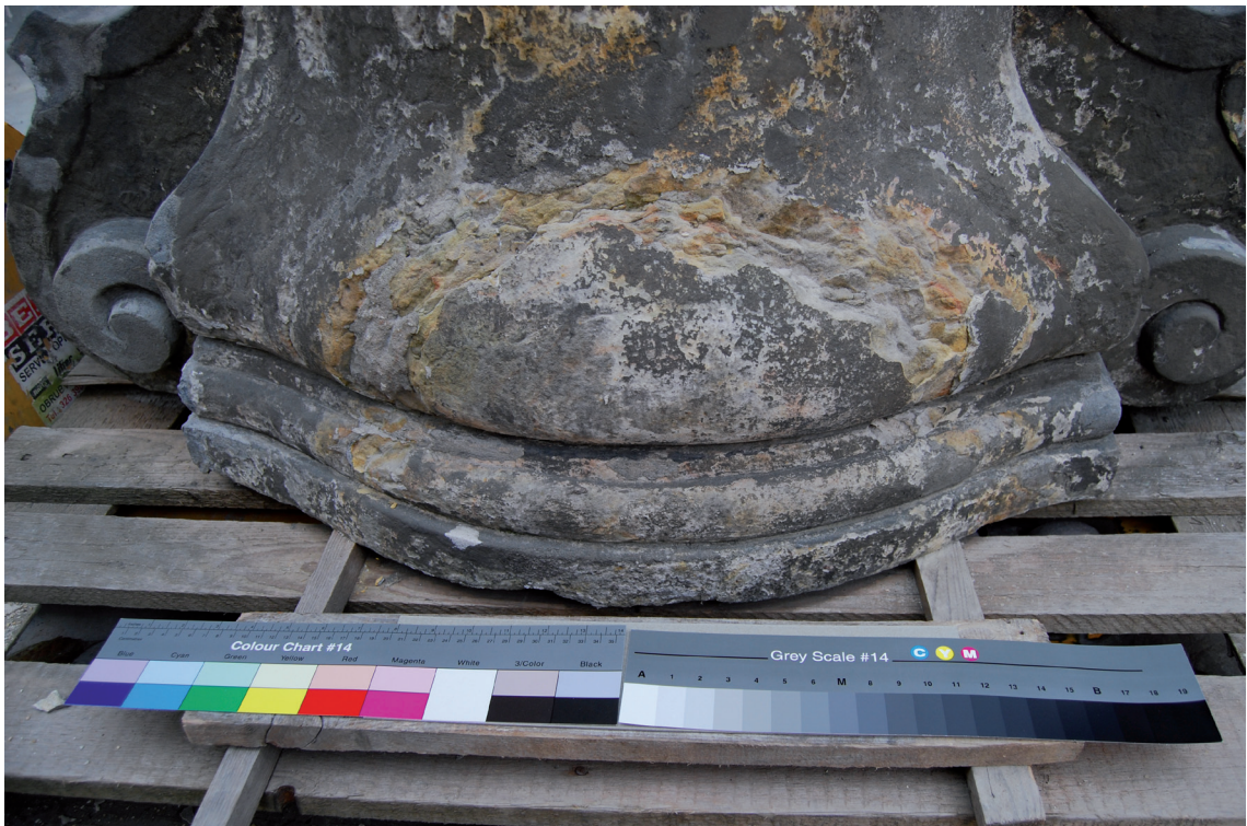
Obr. 17 - Zadní degradovaná část podstavce s otevřenou lasou v kameni
