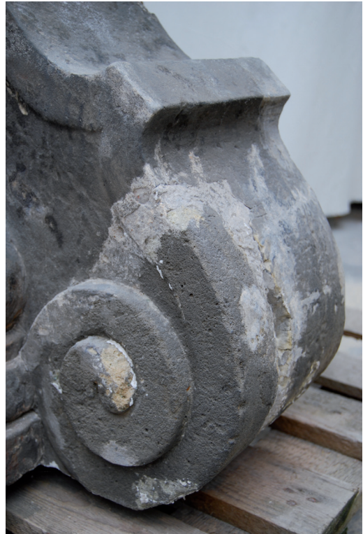
Obr. 16 - Detail obtmelený sekundární doplňek s vyžilými tmely
