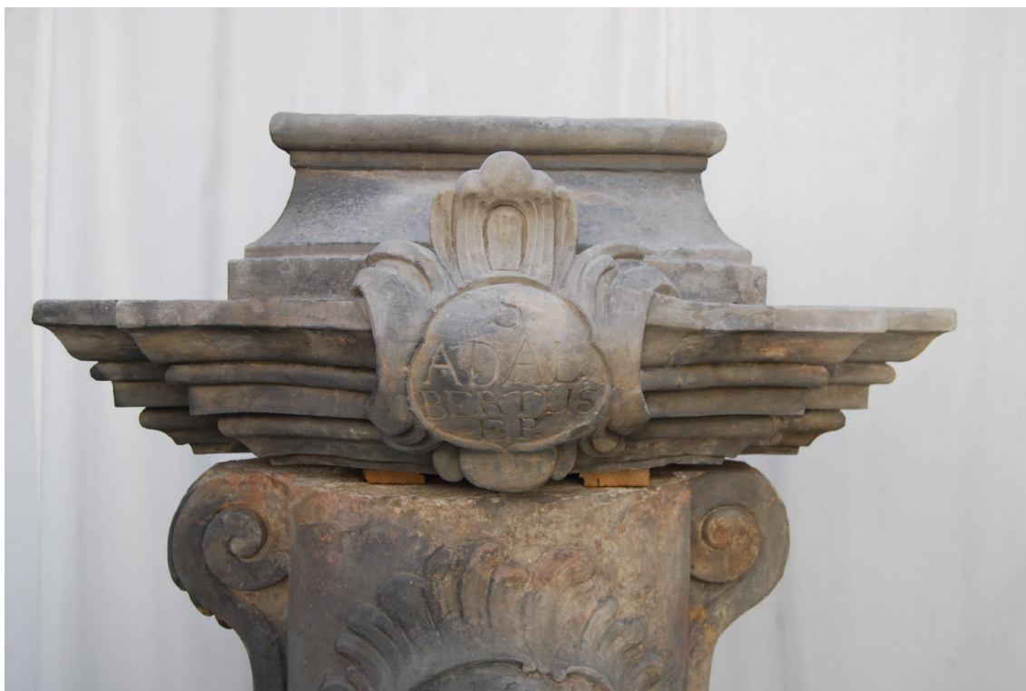
Obr. 67 - Hlavice - stav po restaurování
