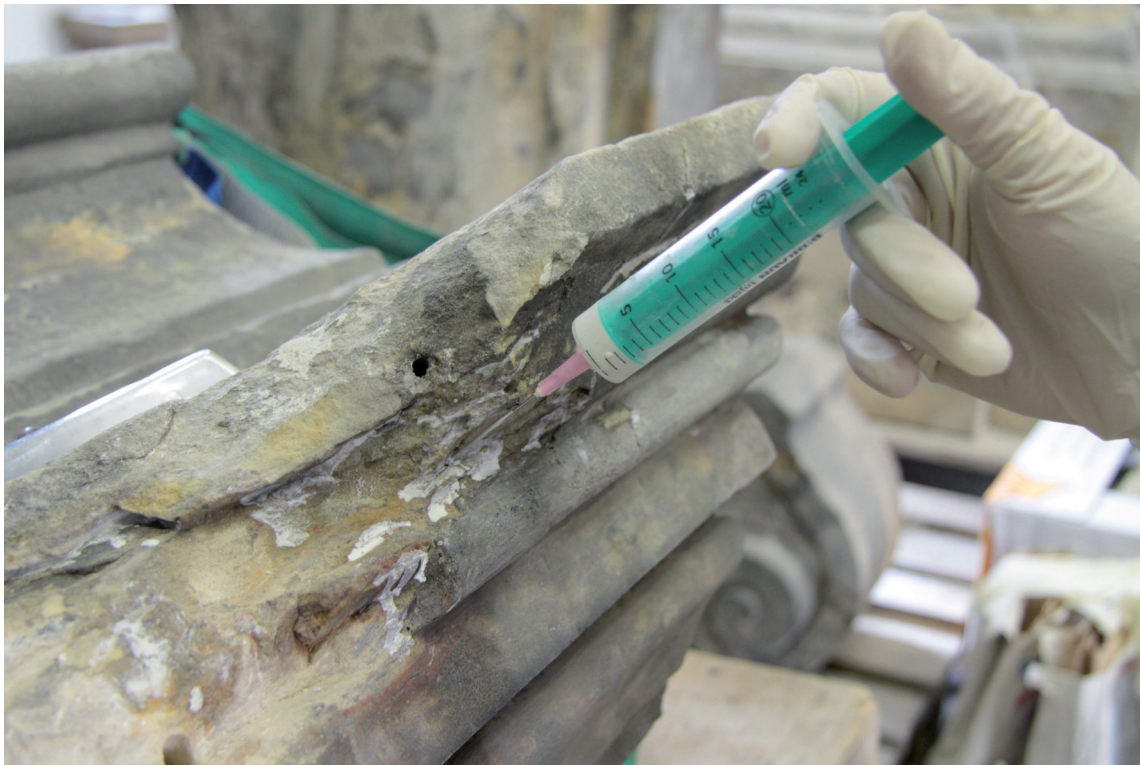
Obr. 44 - Injektáž hlavice organokřemičitanem Funkosil 500 KSE-Füllstoff A, B
