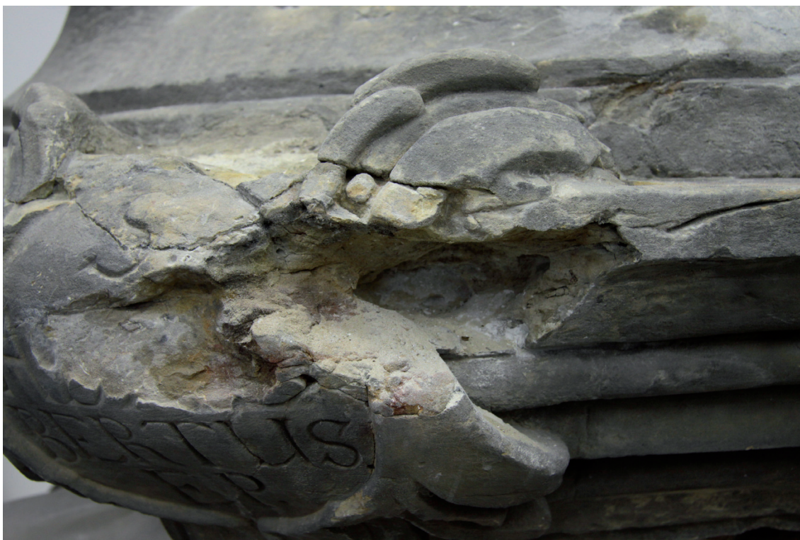
Obr. 46 - Detail nápisové hlavice po odstranění nevhodného bílého tmelu
