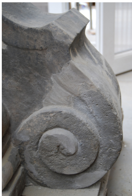
Obr. 43 - Detail vytmelení voluty
