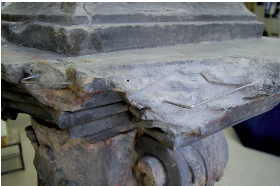
Obr. 45 - Přilepení dvou podporných armatur pro rohové tmely, do otvorů z předcházejícího restaurování v roce 1994-97
