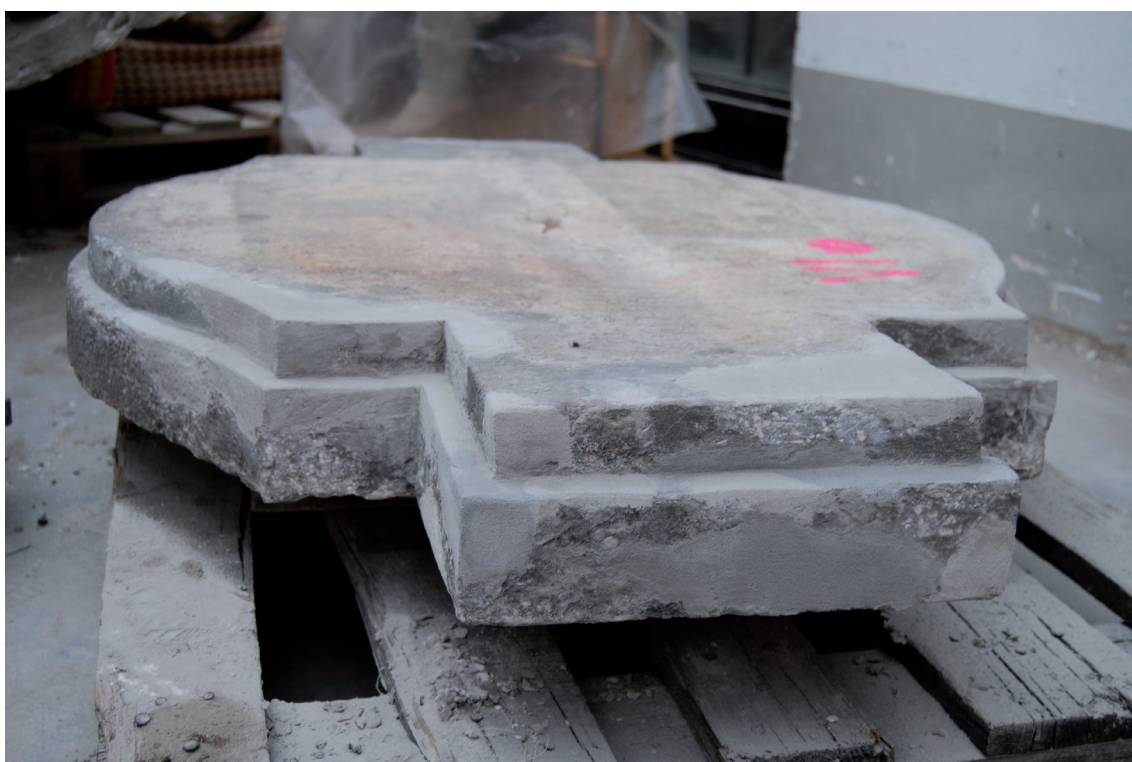
Obr. 53 - Vytmelení plintu
