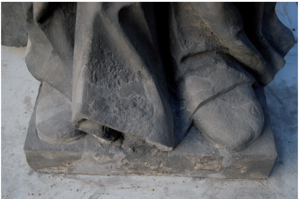
Obr. 26 - Detail nohou po vytmelení
