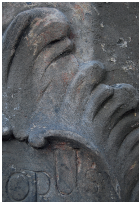
Obr. 37 - Čištění tmavě zelené povrchové úpravy pískováním
