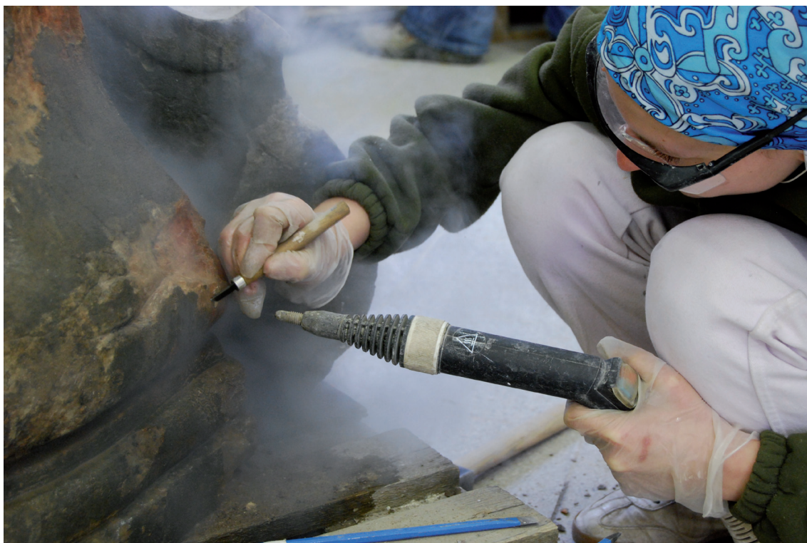
Obr. 35 - Dočišťování pomocí vodní páry a skalpelu
