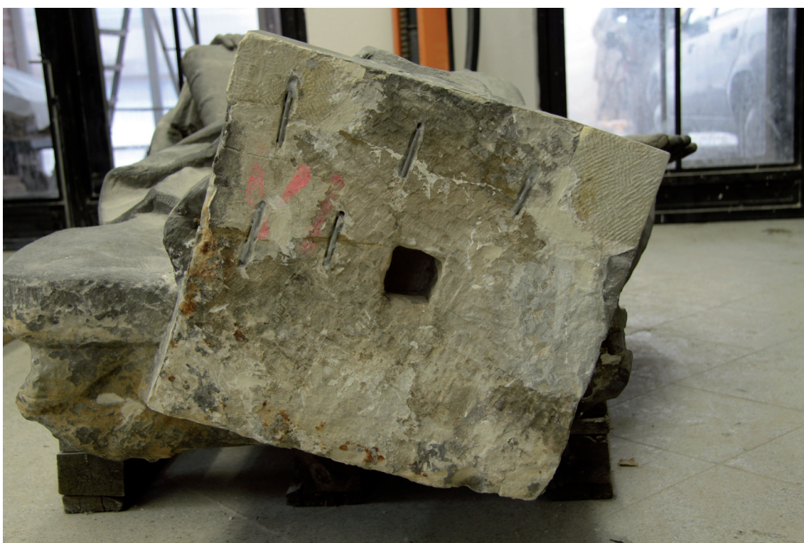
Obr. 25 - Ložní plocha zajištěná kramličkami po očištění od malty
