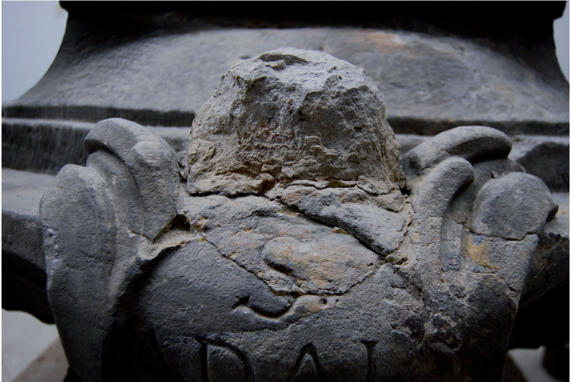
Obr. 22 - Detail degradovaného tmelu na nápisové kartuši
