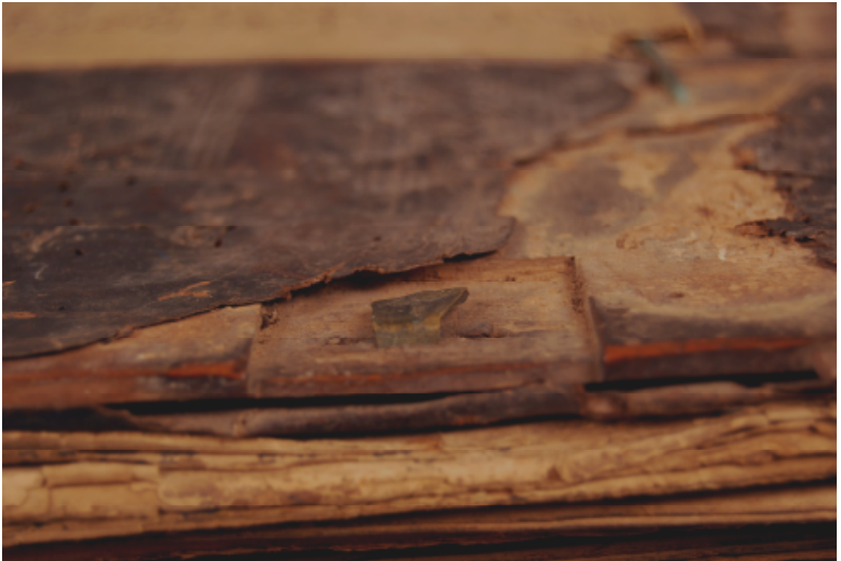
Obr. č. 35 Detail žlábků přední desky – stav před restaurováním
