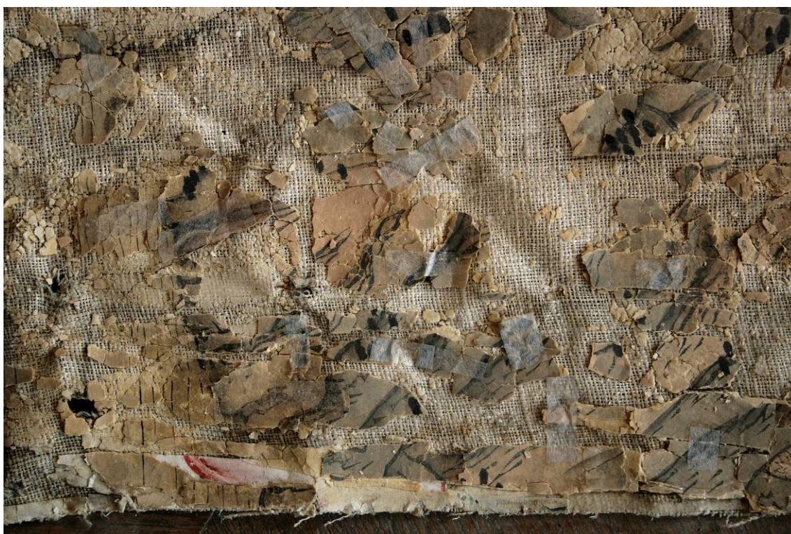
Obr. 61 – Pohled na zajištění části díla tzv. můstky z japonského papíru
