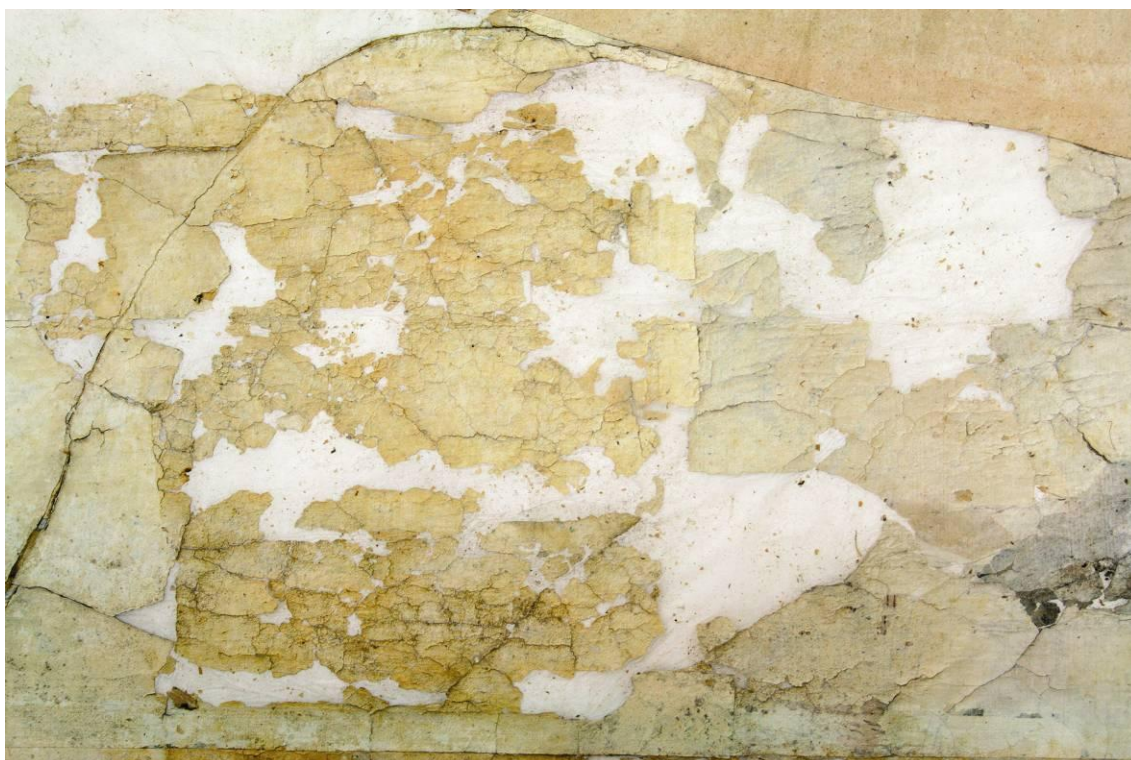
Obr. 95 – Detail přelepu před vyčištěním
