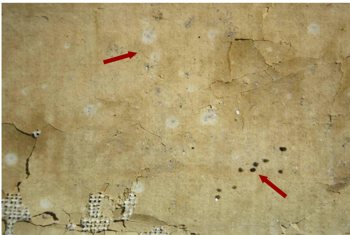
Obr. 47 – Detail poškození papíru v pozadí – bílé skvrny pravděpodobně po mikrobiologickém napadení, hmyzí exkrementy
