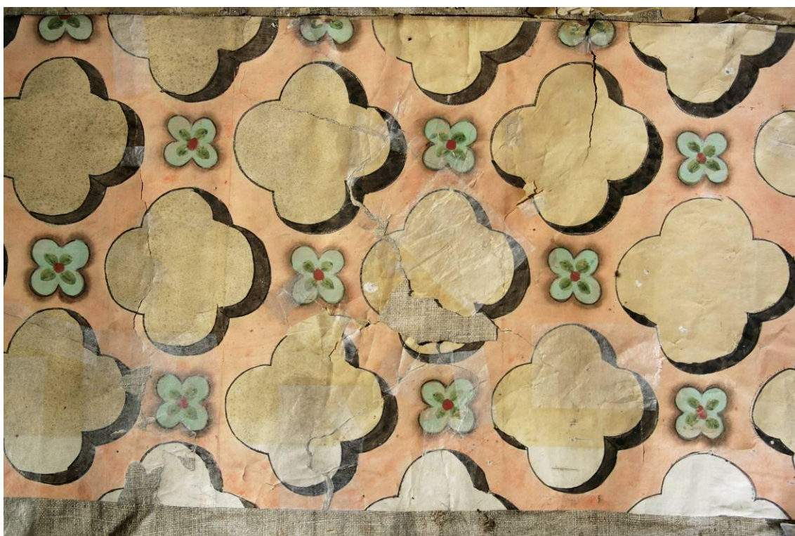
Obr. 63 – Pohled na zajištění trhliny japonským papírem
