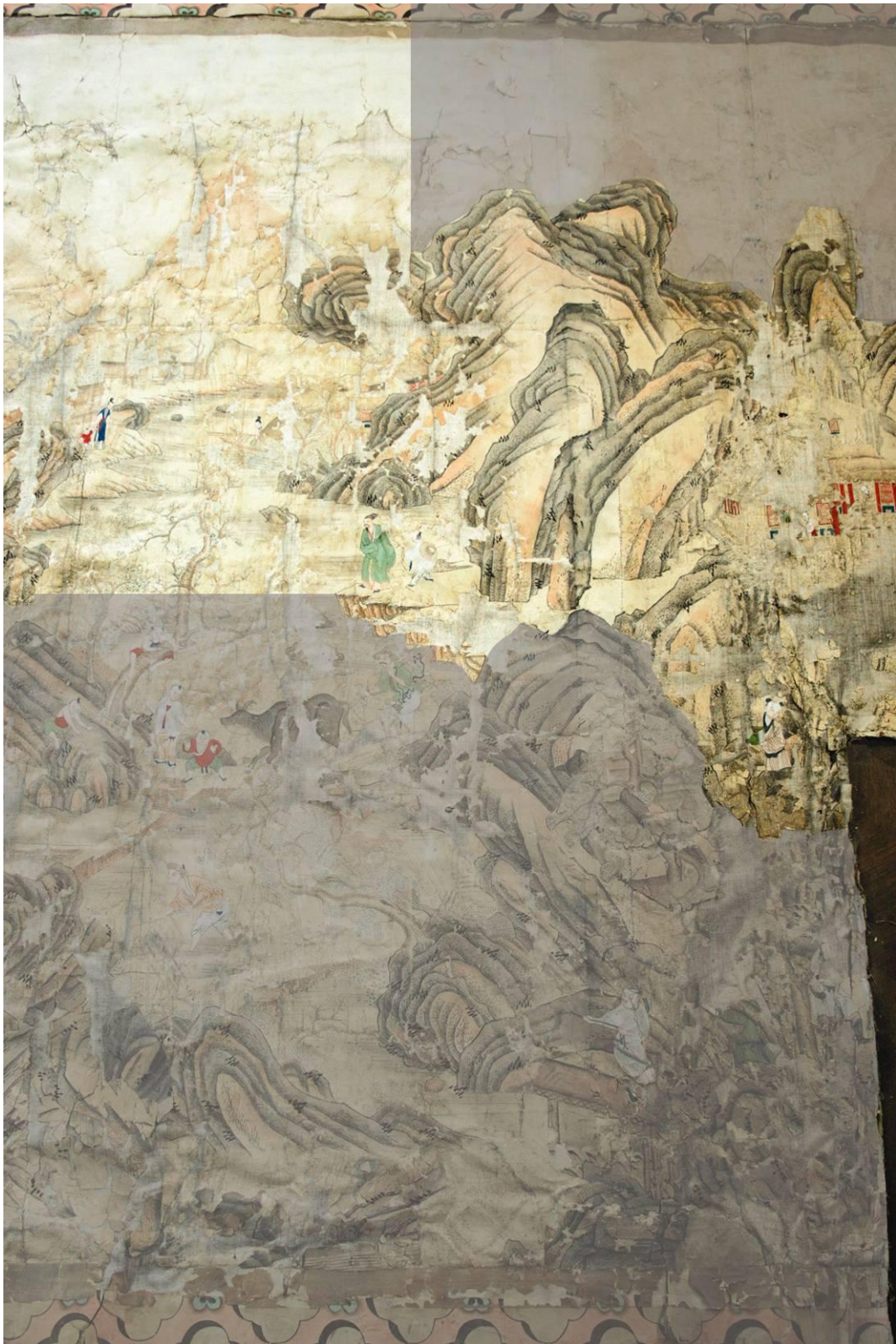
Obr. 54 – Detail přiděleného úseku tapety – stav díla po mechanickém očištění a správném umístění fragmentů
