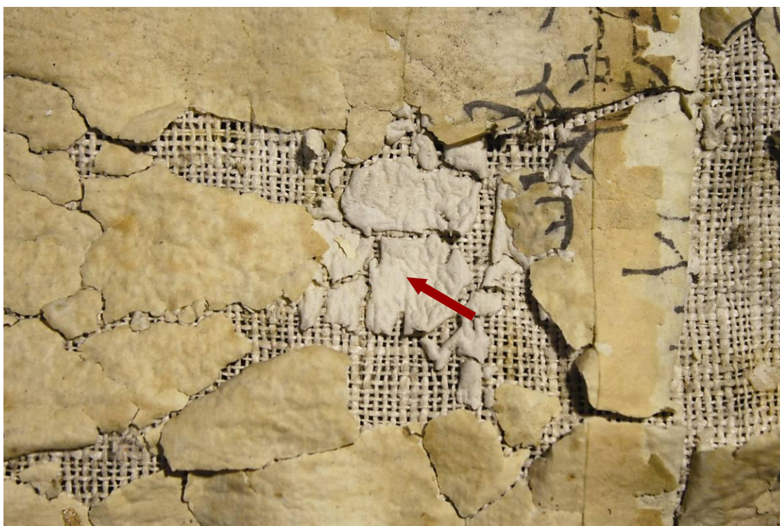
Obr. 42 – Detail vrstvy podlepového papíru
