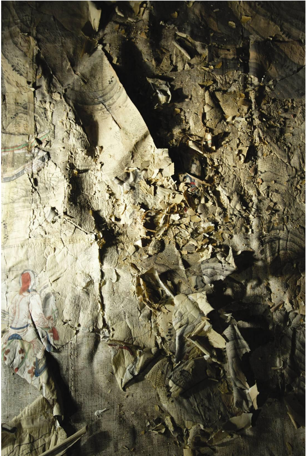
Obr. 26 – Detail poškození v bočním světle – pohled na fragmenty sesypané na jedno místo
