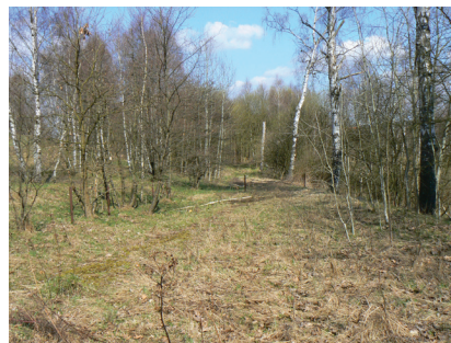
Obr. 3 Silnice do Novin pod Ralskem; současný stav
