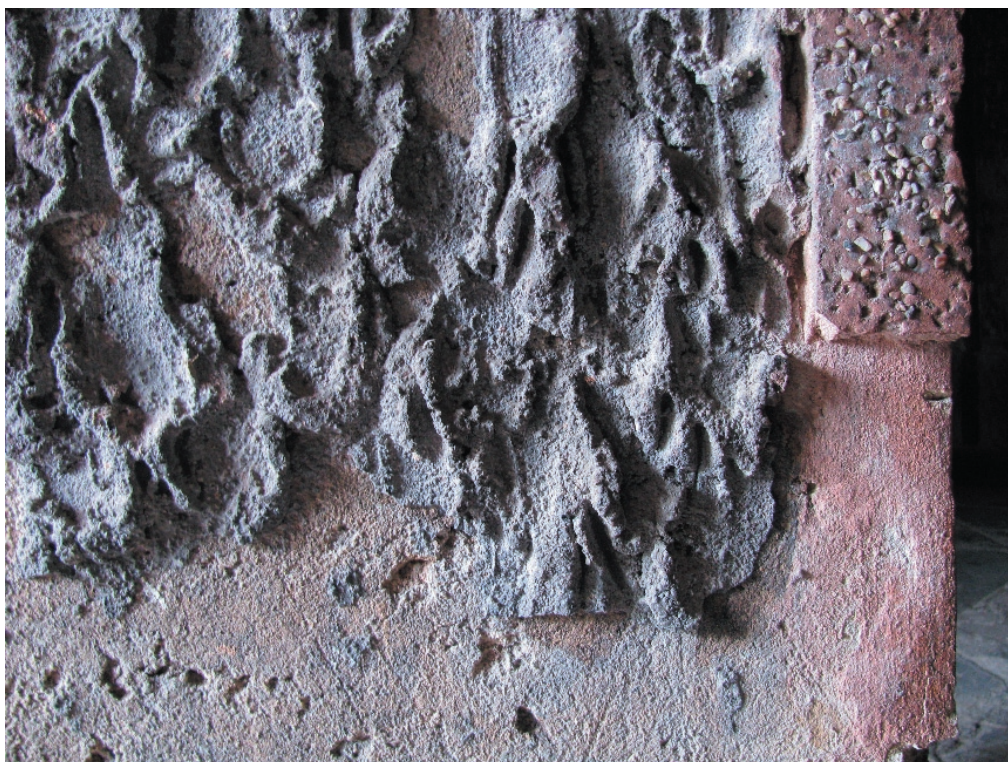
Zámek Ploskovice. Grotty v suterénu objektu. Detail plastické výzdoby stěn.
