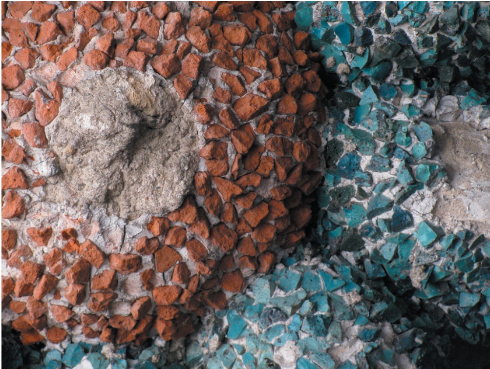
Zámek Kroměříž, sala terrena. Detail plastického květu z drobných úlomků cihel a strusky na stropě Apollónovy grotty.
