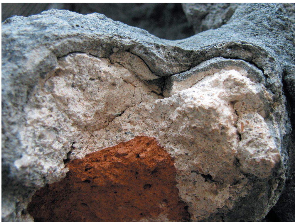
Způsob výstavby umělých krápníků na voliére v areálu zahrady Valdštejnského paláce v Praze.
