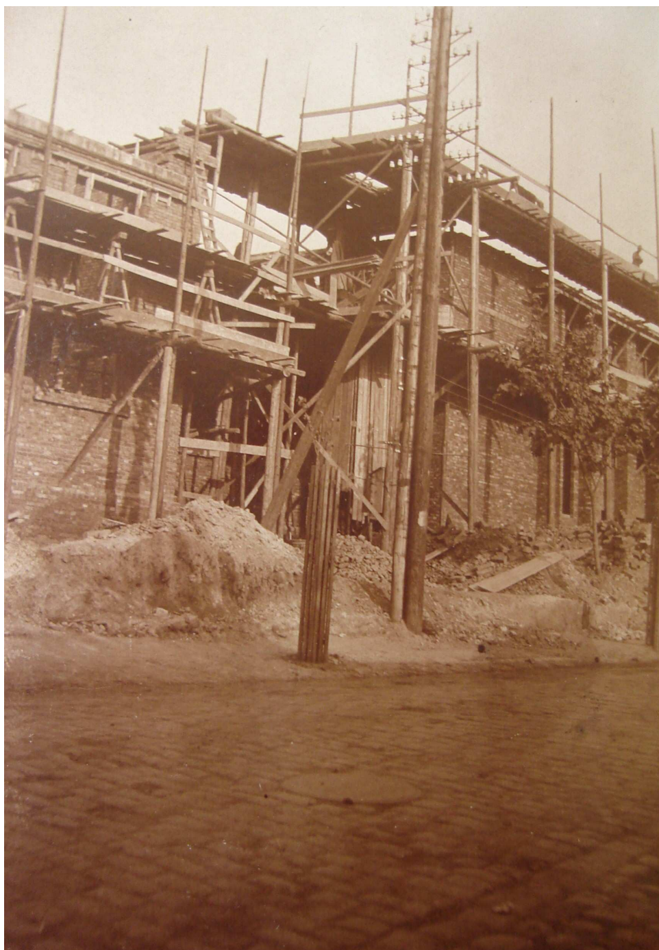
Příloha č. 4. – Stavba nové školní budovy v Sokolově.
