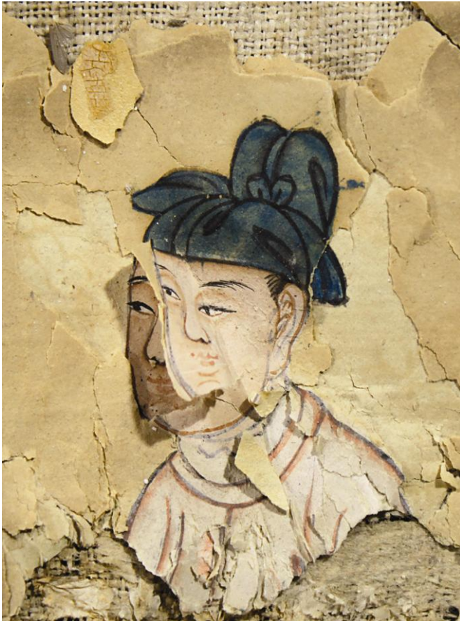
Obr. 100 Vrstvení tapety, pod poškozenou svrchní vrstvou tapety je vidět téměř shodný obličej provedený ve stejných barvách, detail tapety z Valtic
