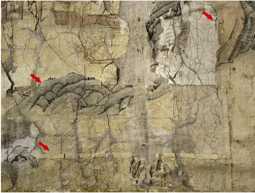
Obr. 97 Slepování tapet z archů, na detailu tapety z Valtic jsou patrné horizontální i vertikální spoje jednotlivých listů papíru
