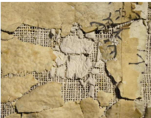
Obr. 102 Podlepení tapety, pod poškozenou svrchní vrstvou tapety je vidět bílý podložní papír, detail tapety z Valtic
