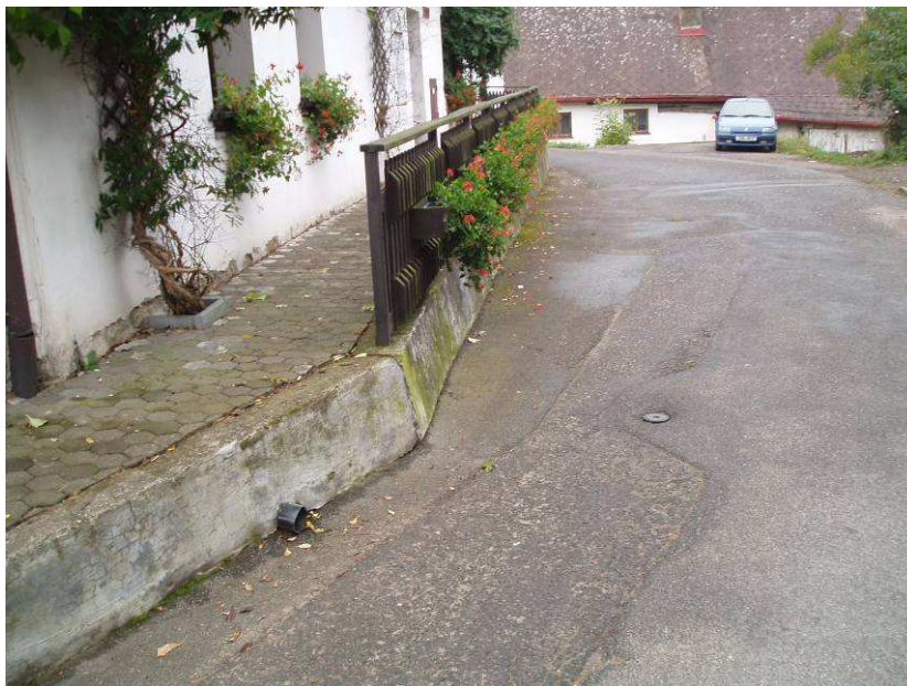
Opěrná zeď č.3
