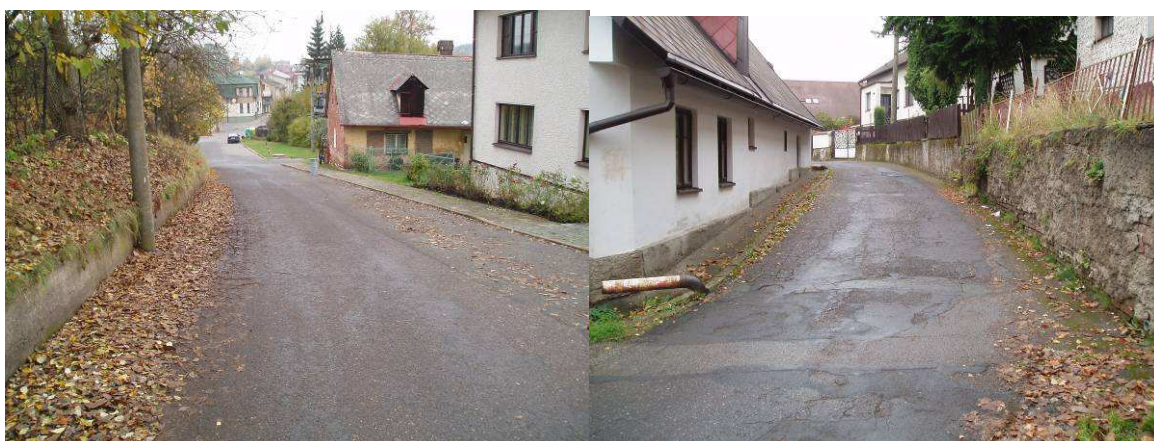
Opěrná zed' č.1
