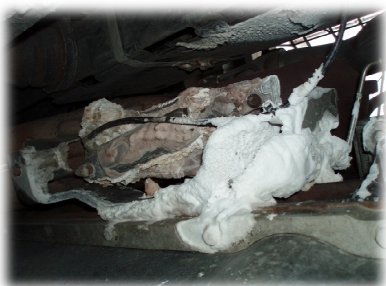
Obrázek 31: Projev netěsnosti vedení AdBlue®
