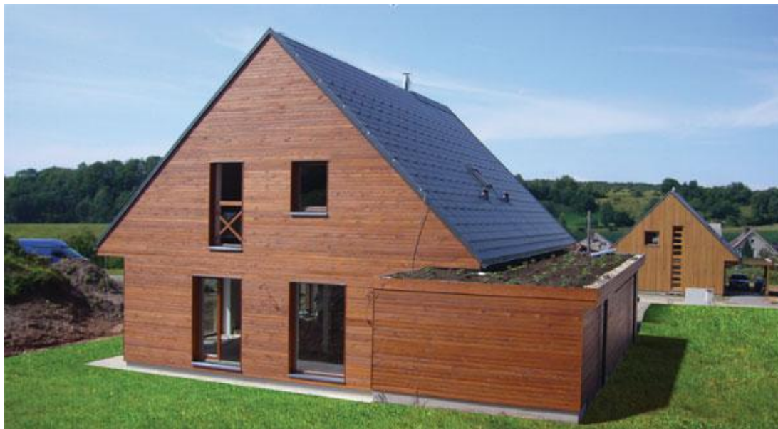
Obrázek č. 13: Pasivní dům v obci Koberovy 64
