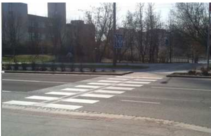
Obr. 13 Přechod detailnější pohled
