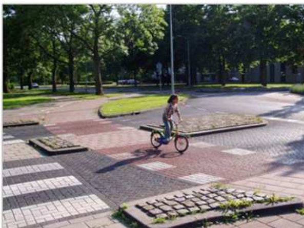
Obr.6 Samostatné vedení cyklistů na okružní křižovatce, Breda-Nizozemí (foto: Petr Pokorný)
