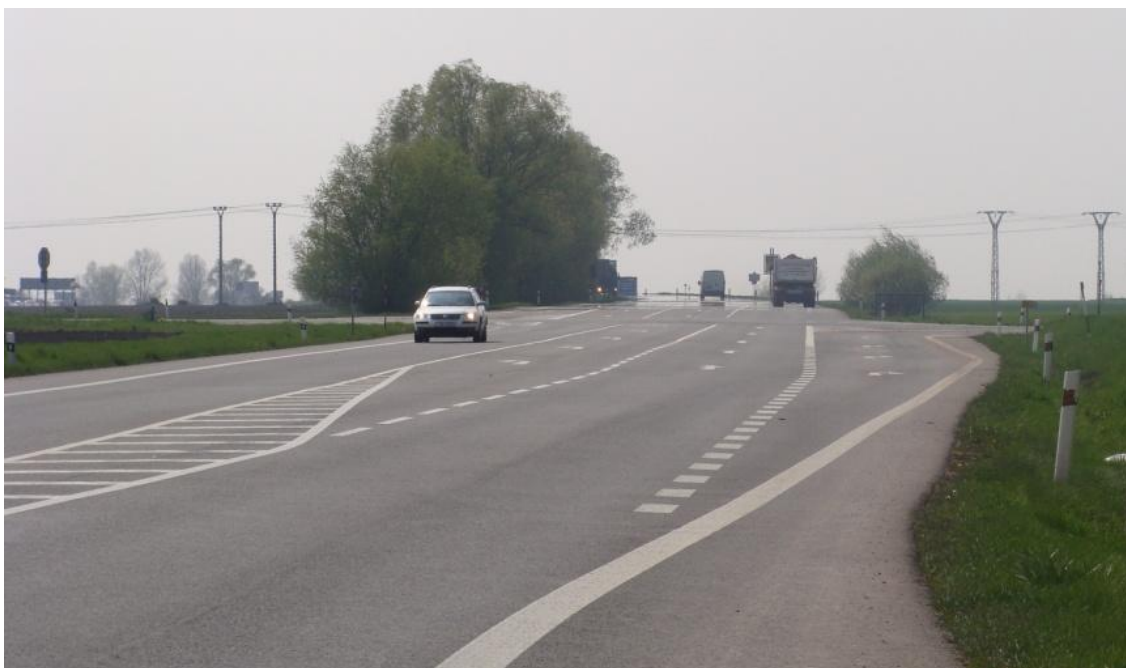
Křižovatka silnic č. I/55 a č. II/432 (pohled od Uherského Hradiště)
