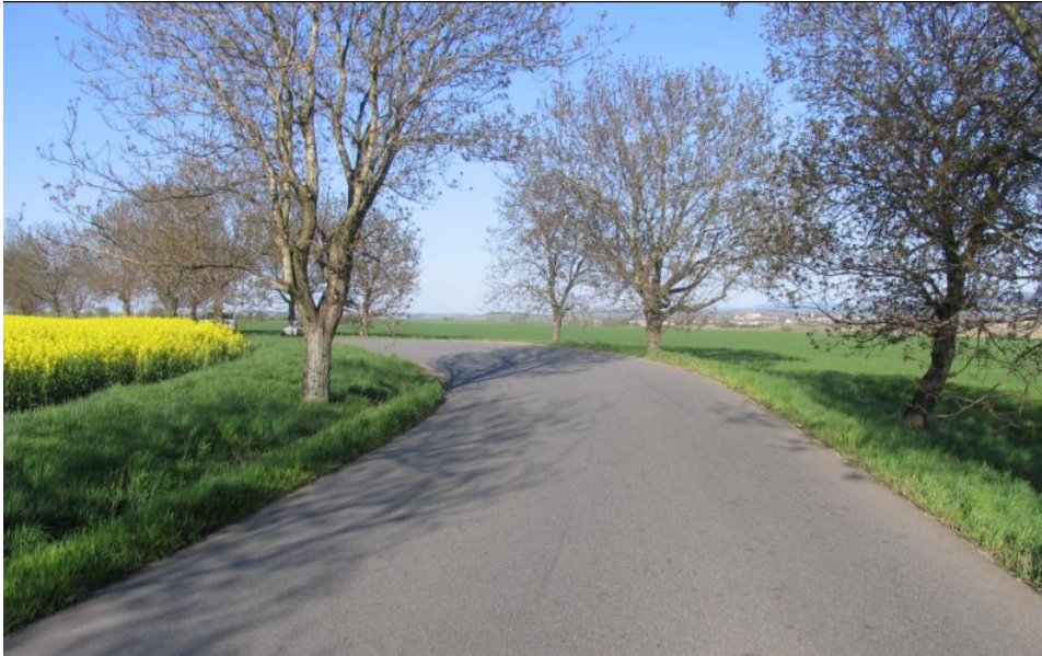
Obrázek č. 31: Nehodový směrový oblouk (pohled ze směru jízdy od Strážnice)
