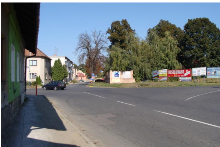
Obrázek č. 12: Zástavba zasahující do rozhledu (pohled z ulice Havlíčkova od Hodonína)
