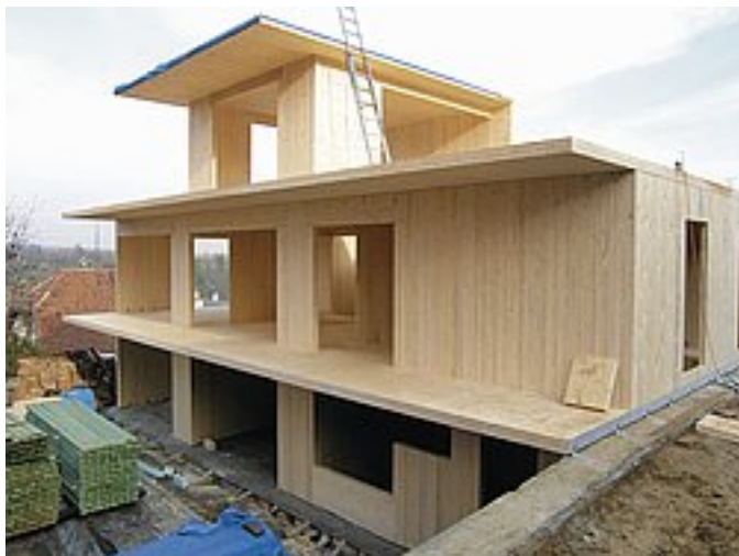
Obrázek 11: Stavba domu z KLH panelů
