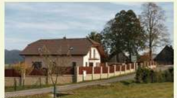
Nevhodné oplocení na vsi
