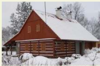
Velmi zdařile zrekonstruovaná venkovská chalupa
