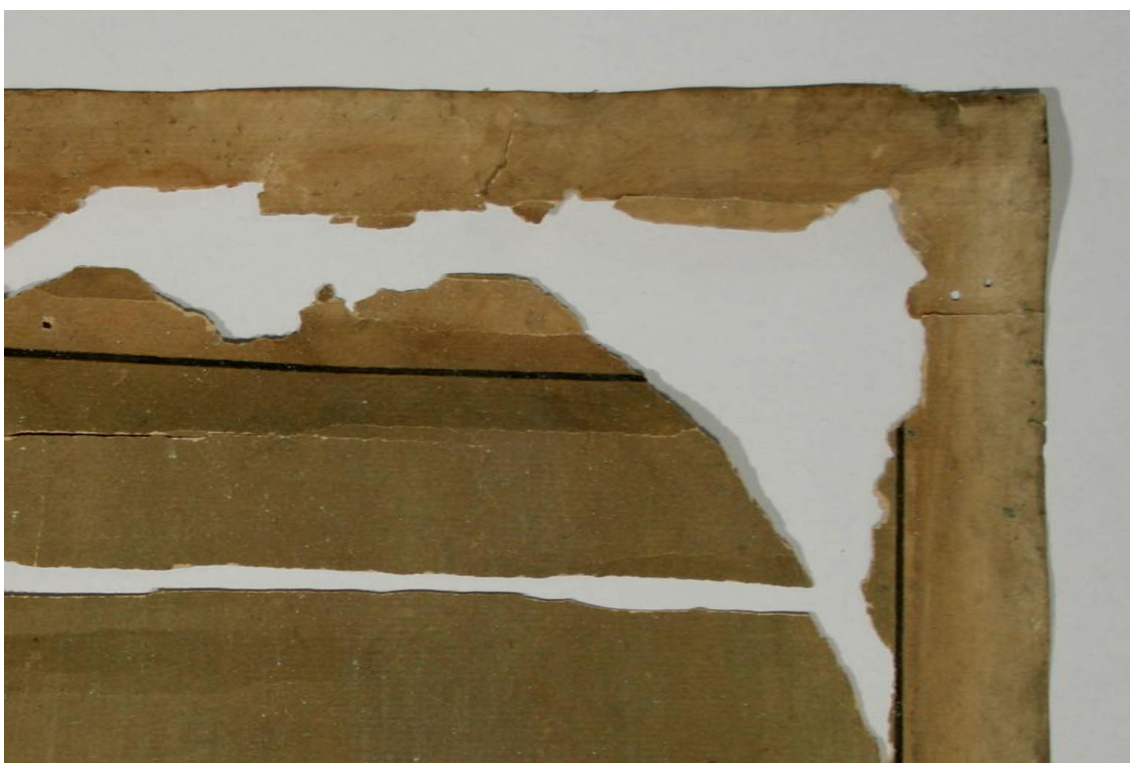
Obr. č. 4: Stav před restaurováním, detail poškození, průzkum v denním rozptýleném světle.
