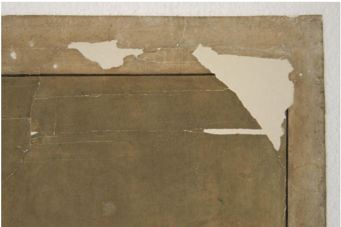
Obr. č. 40: Stav v průběhu restaurování, detail doplňků.
