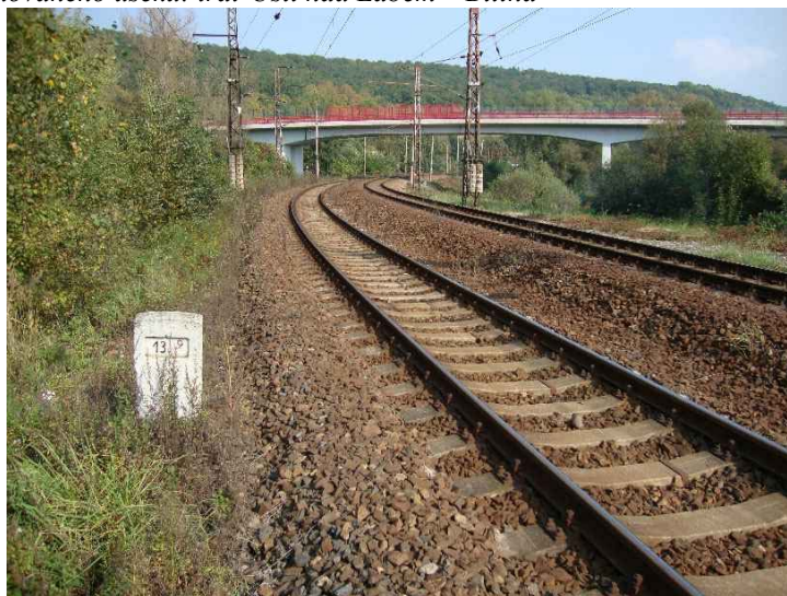
Snímek 1 Začátek rekonstruovaného úseku: trať Ústí nad Labem – Bílina
