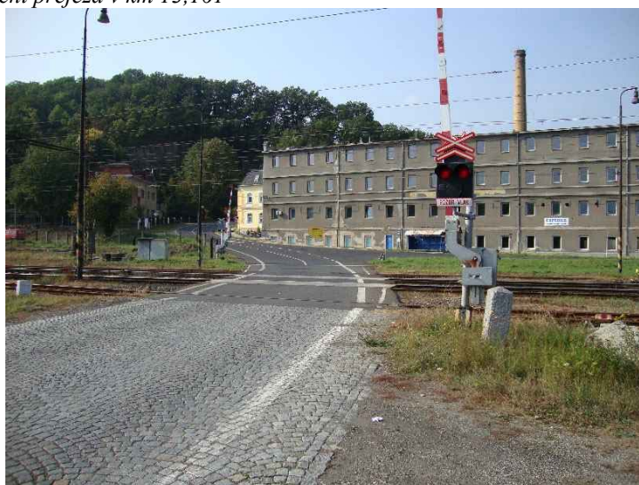
Snímek 8 Bývalá vlečka Ospap, dnes kuse ukončena před úrovňovým přejezdem
