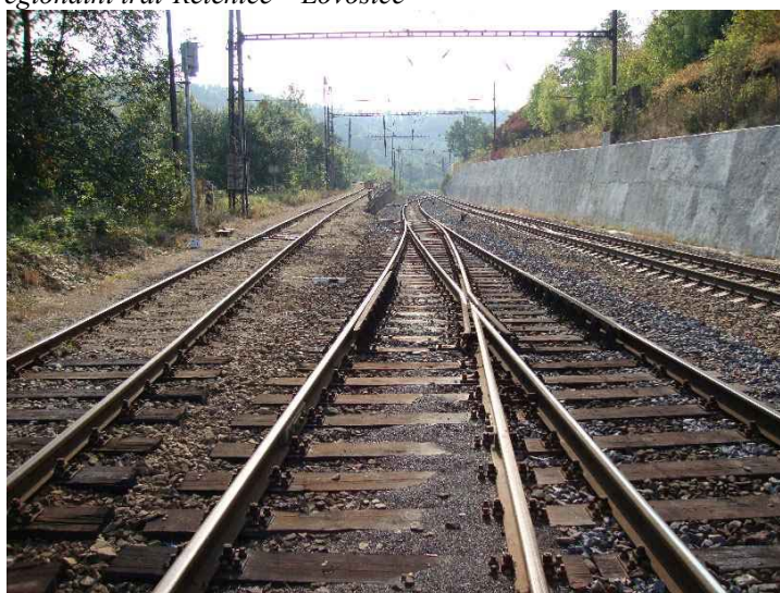
Snímek 20 Opěrná a zárubní zeď na bilinském zhlaví
