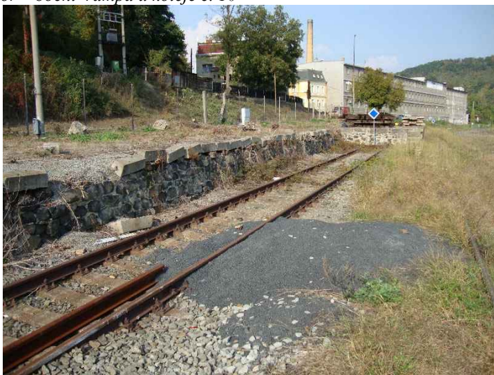
Snímek 11 Nákladový prostor – rekonstruovaná boční rampa u koleje č. 8
