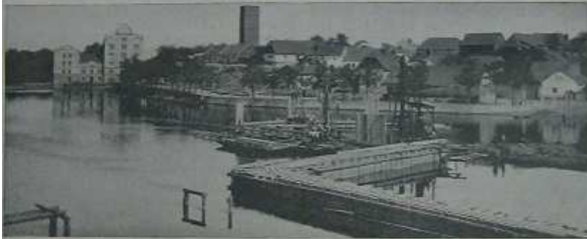
Stavba jimky. — Zatloukání pilotů.
