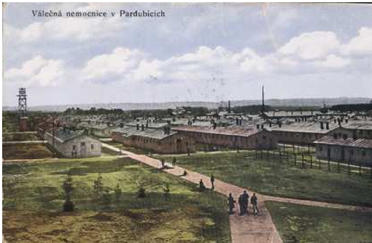
Příloha č. 6: Pohled na baráky s protipožární věží a komíny ze spaloven.
