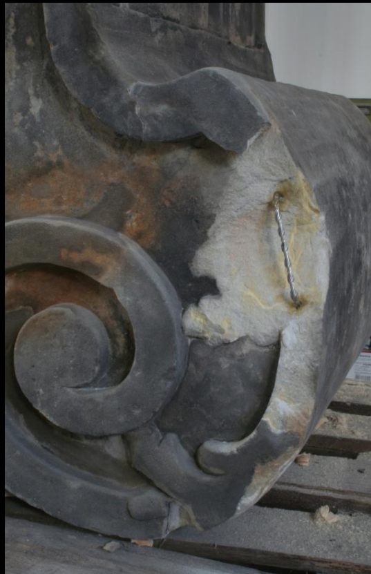
↑ Stav po dolepení chybějícího kusu, doinjektování prasklin a vložení nerezové armatury
