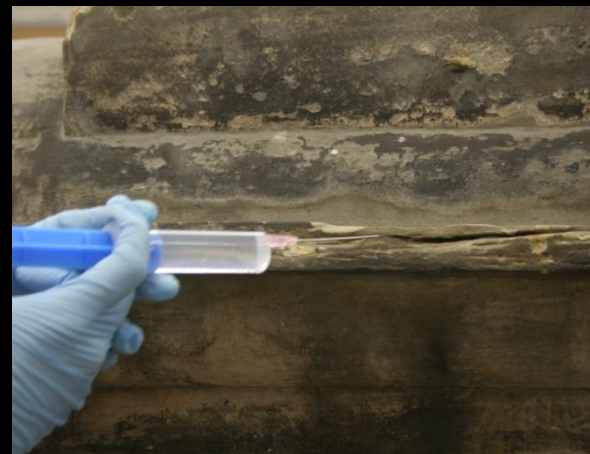
↑↑ Odstranění nevhodných tmelů
