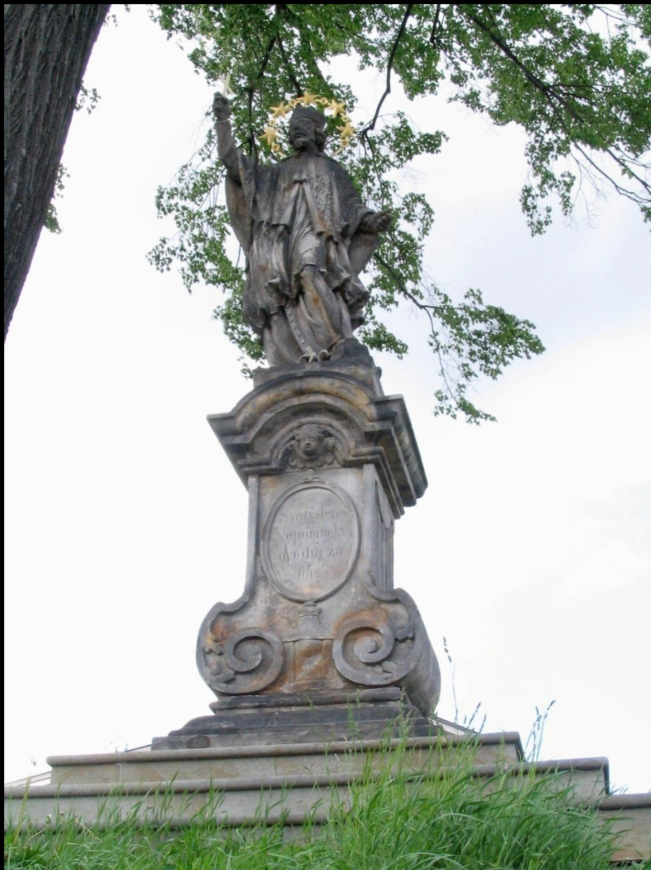
↑ Fotografie stavu památky po dokončeném restaurování v roce 2004
