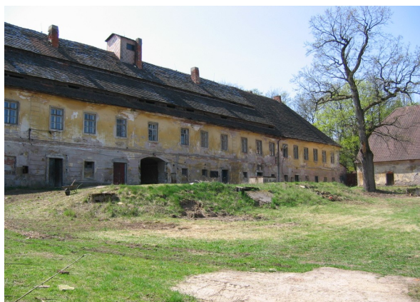
17. Kavalierhaus z vnitřního dvora po odstranění zeleně, 2009
