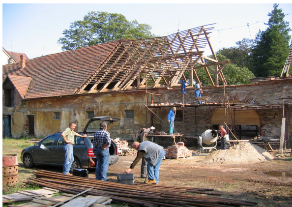
14. Průběh oprav na chlívu, 2005
