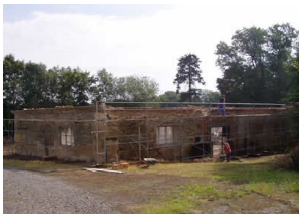
10. Liberecká firma REOPA, s.r.o. provádí zabezpečovací práce na stodole, 18. 8. 2004
