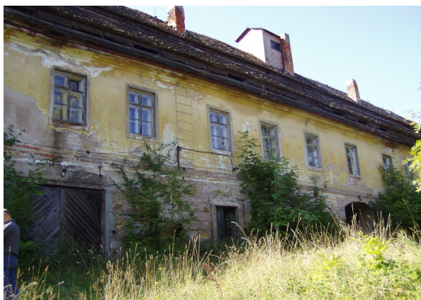
16. Kavalierhaus z vnitřního dvora před odstraněním náletové zeleně, 2004
