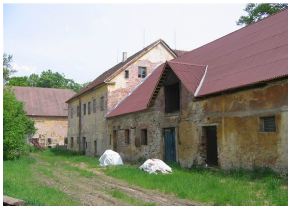
15. Chlív – provizorní zastřešení, 2009
