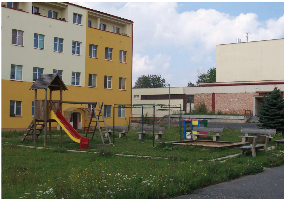
Obr. 3 V rámci opravy domů se vytváří i okolí a dětská hřiště do něj patří
