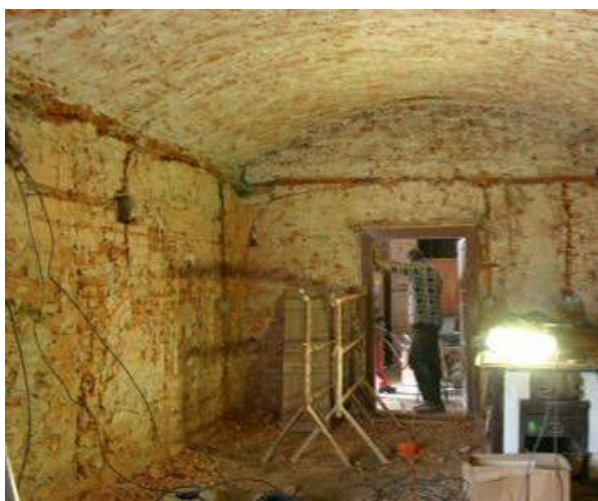
č. 51. Oprava kuchyně v roce 2006.
