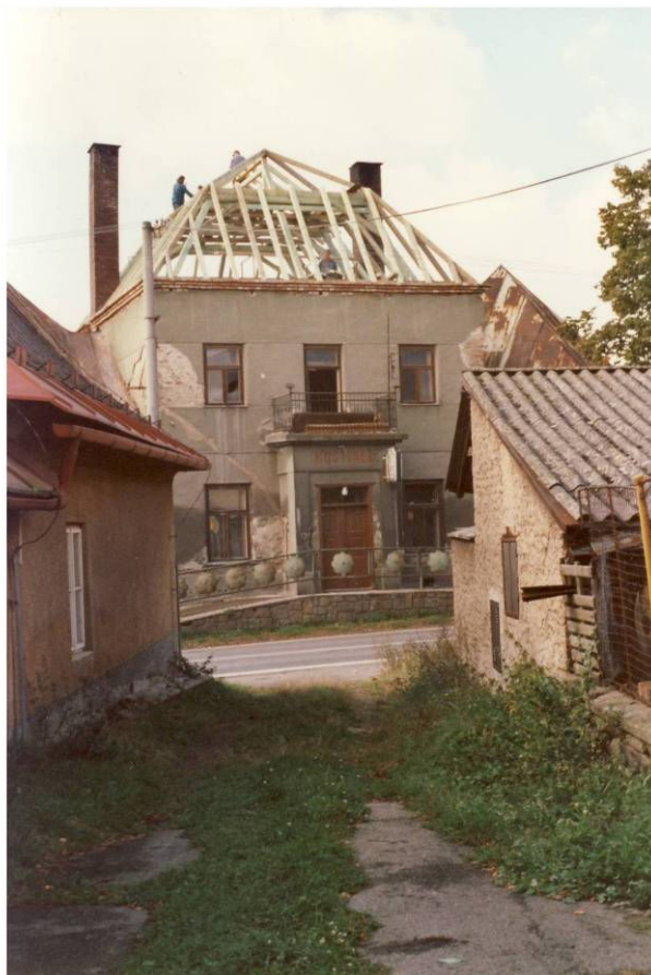
č. 44. Opravy v roce 1999 na středním traktu.
