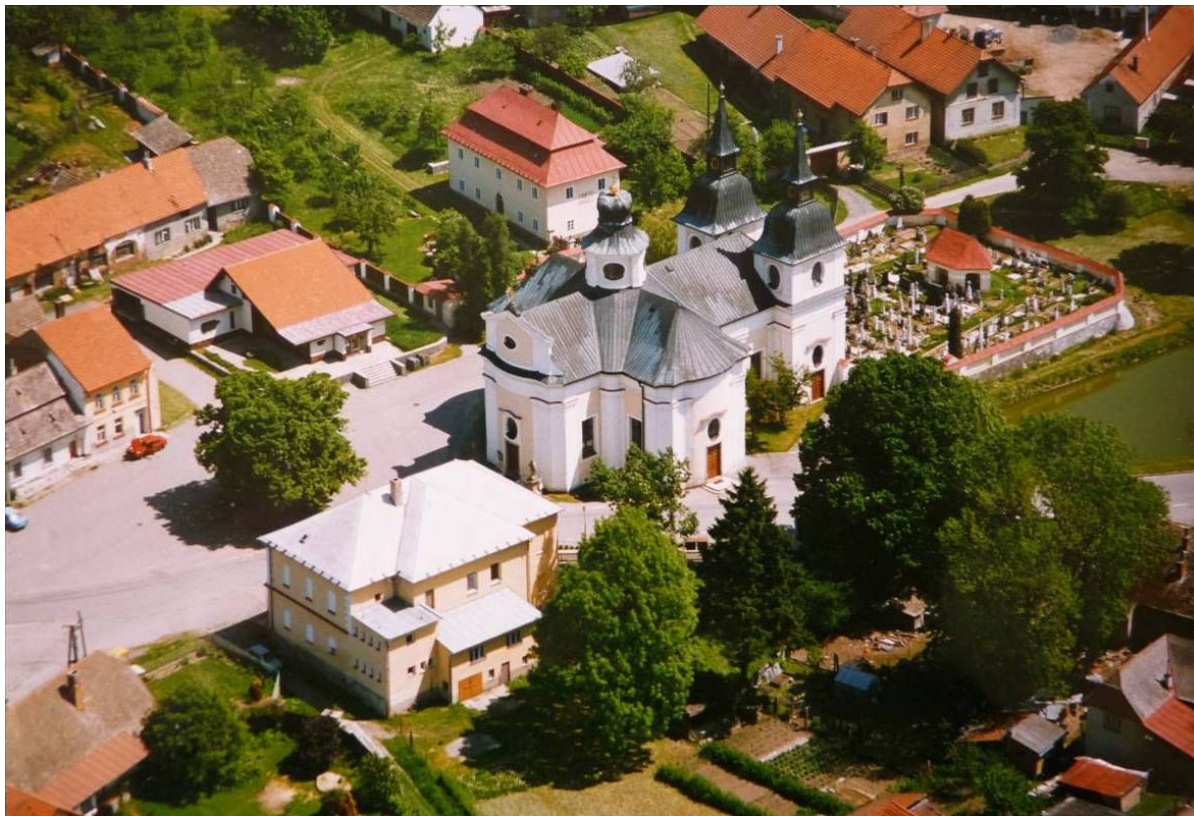
č. 72. Sjednocení střešních nátěrů (před a po) po roce 2002.
