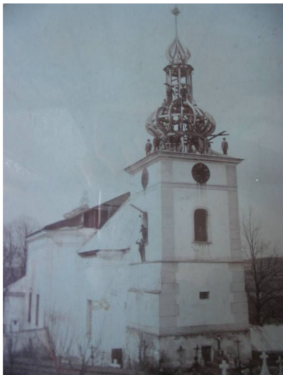
č. 80. Stavba nového krovu na věži po roce 1907.
