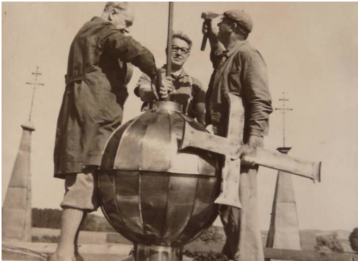
Opravy střechy v roce 1983.
