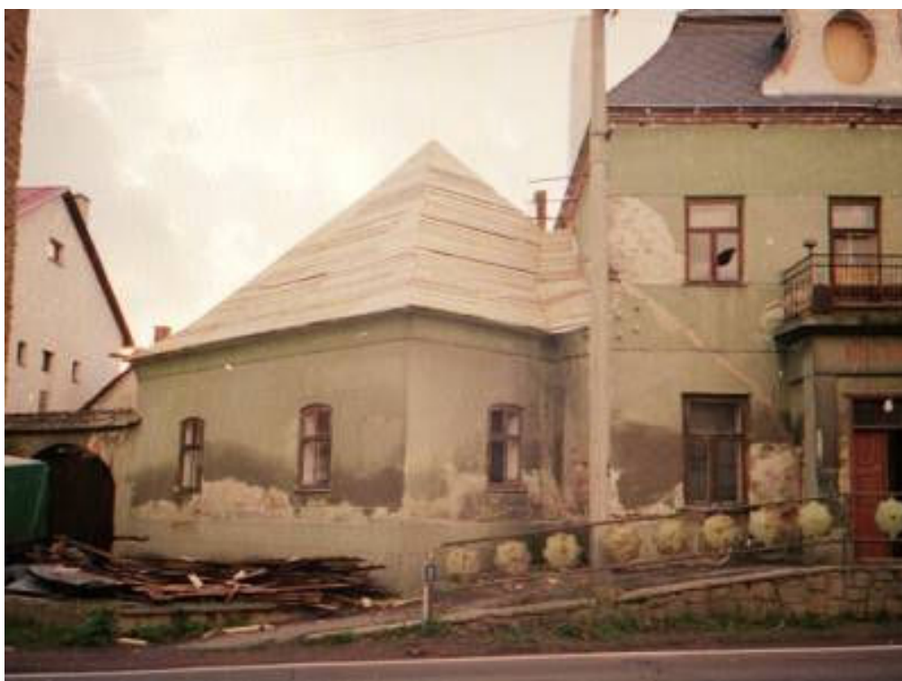
č. 45. Opravy z roku 2000 na jižním křídle.
