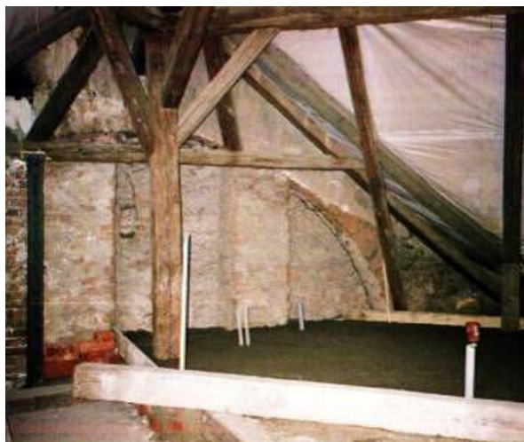
č. 49. Opravy interiéru v roce 2004, podkroví.
