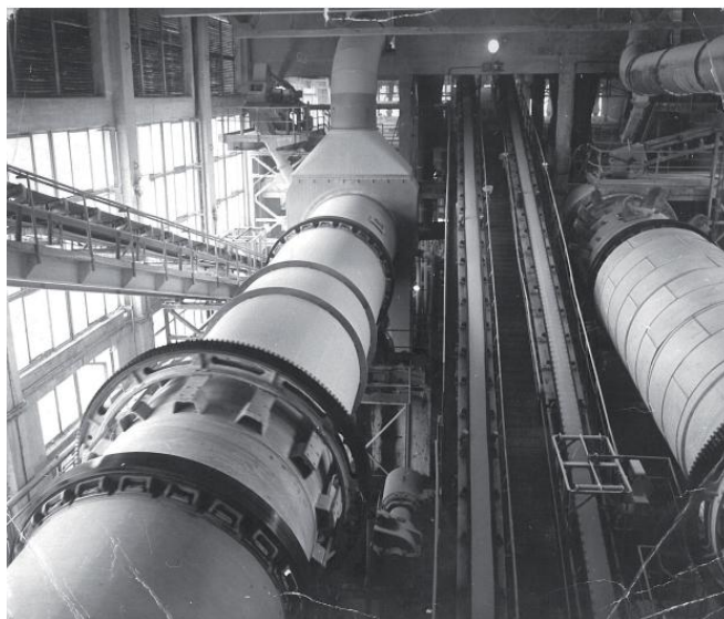
Obr. 4 Suchá strana výroby hnojiv NPK
